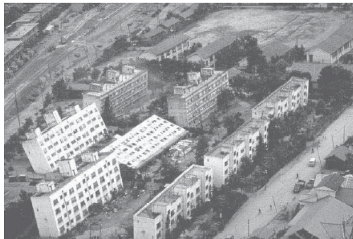
Figura IV.8 Edificios inclinados por licuación de arenas.
