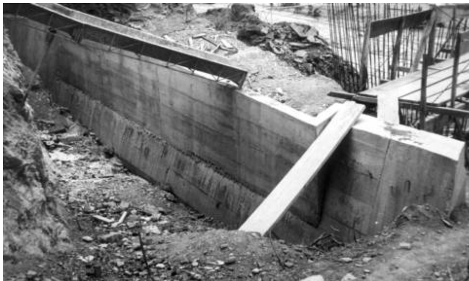
Figura II.7 Puente El Salado.
