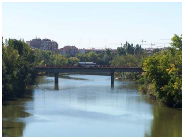
Figura I.4. Puente de vigas armadas.
