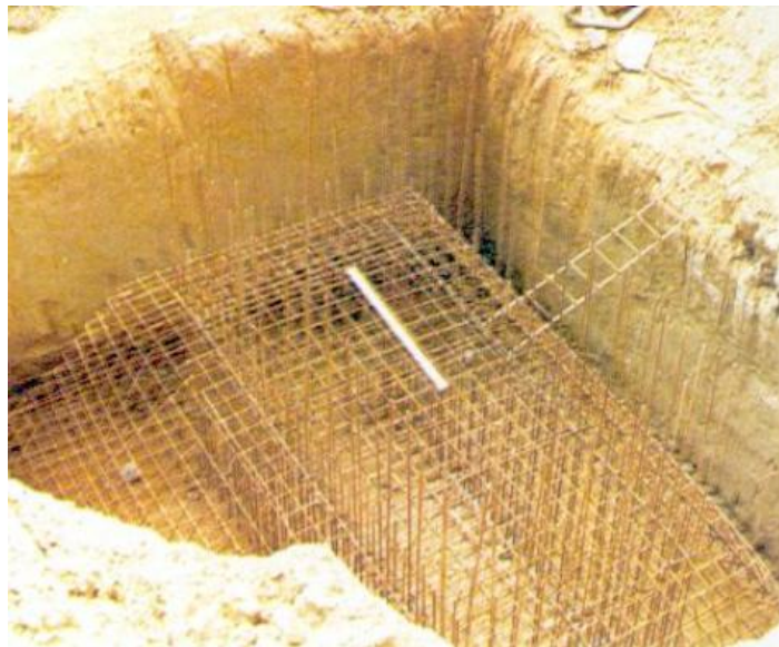
Figura II.5. Cimentación superficial en terreno duro.
