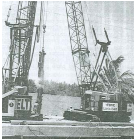
Figura II.18 Hincado de pilotes desde un chalán.
