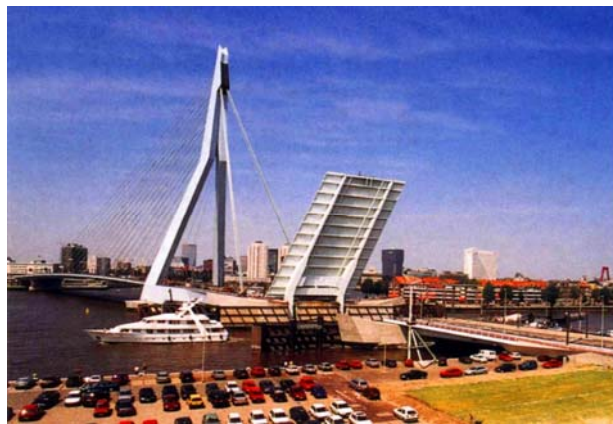
Figura I.10. Puente levadizo de una hoja.
