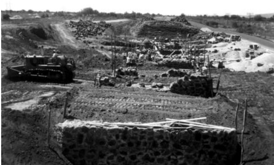
Figura II.6. Puente Masiaca Auxiliar.
