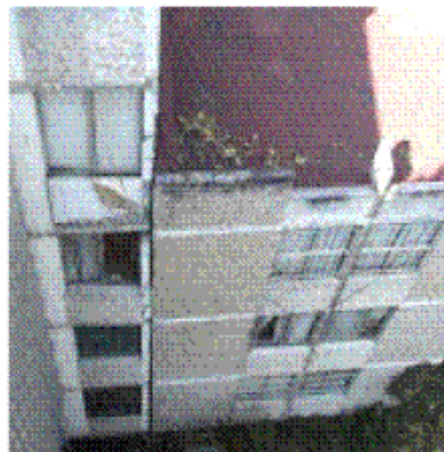
Fotos 9 y 10; Donde se puede apreciar lo siguiente, otra vista del daño sufrido en el contacto de los niveles superiores de los edificios S-32 y T-25 , donde se aprecia el daño de la celosía.
