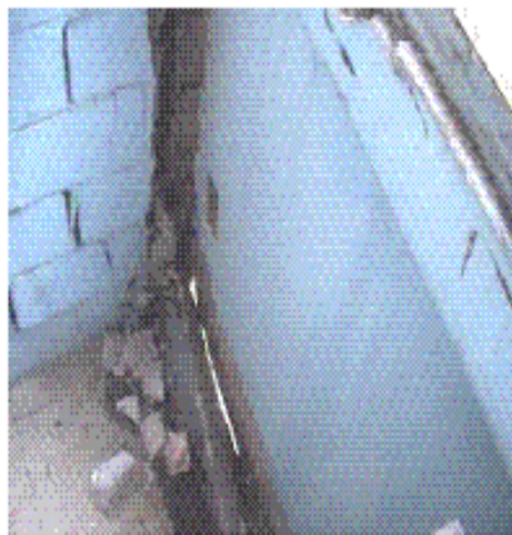
Fotos 7 y 8; En la ventana superior, el precolado bajo de ella cayó al jardín, y el precolado del nivel inferior está fuera de su sitio, al igual que el superior en peligro de caer. Vista del muro del edificio S-32 donde se aprecia desde el interior que el precolado no rigidiza al muro y se sale de su lugar.
