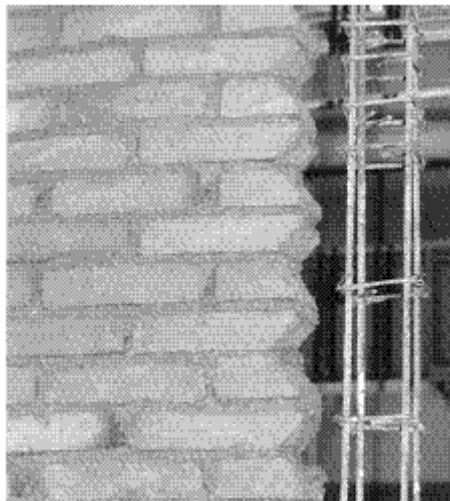
Figura 2.4 Dentado de un muro de tabique recocido para garantizar el "amarre" con los castillos de confinamiento.
