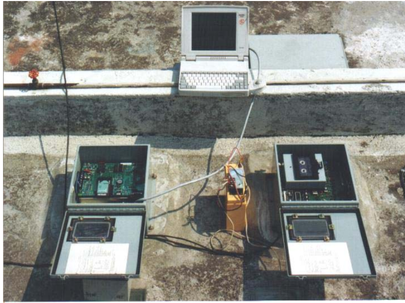
Fig. 3.4 Equipos de medición y computadora portátil
