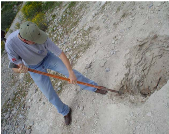
Excavación de pozo a cielo abierto dentro del terreno.
