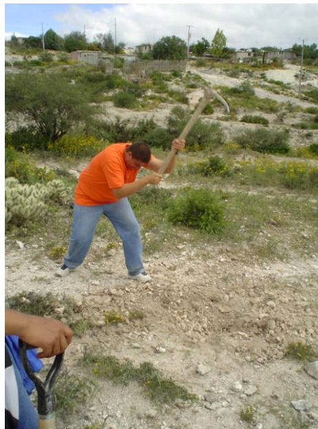
Fotografía 10 Excavación de pozos a cielo abierto
