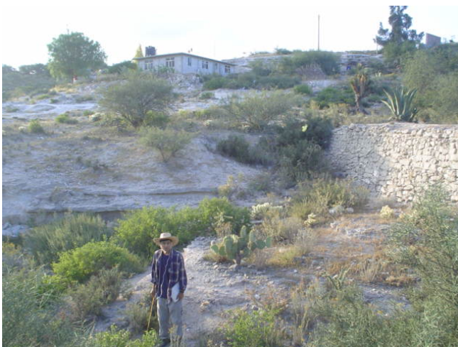
Talud ubicado al este del terreno.
