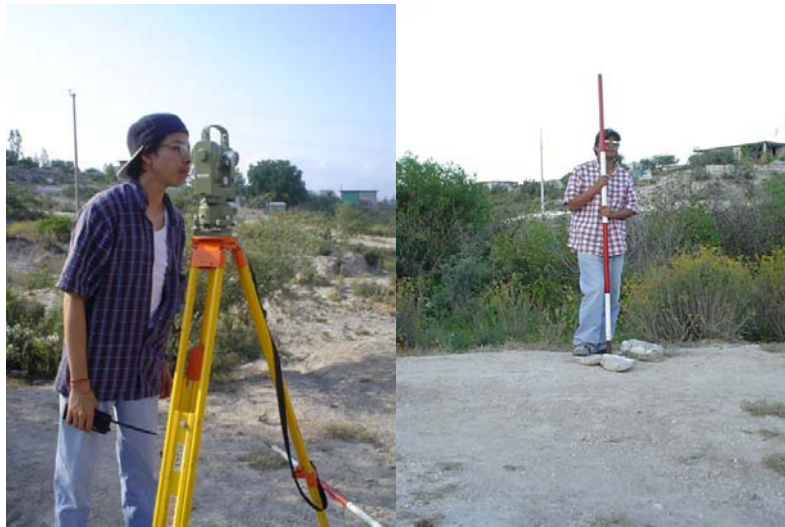
Fotografía 1 Levantamiento de la Poligonal.
