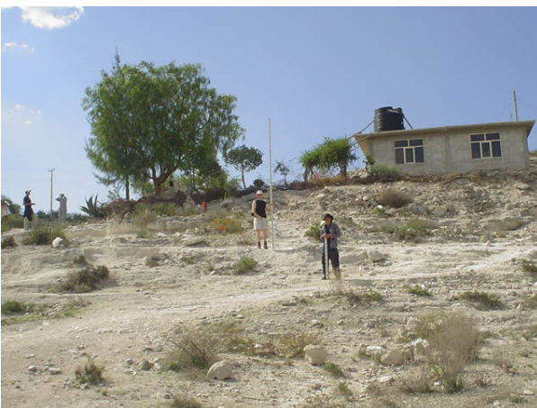
Casa y Talud de Colindancia
