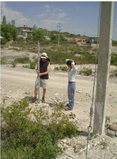
Poste de Concreto
