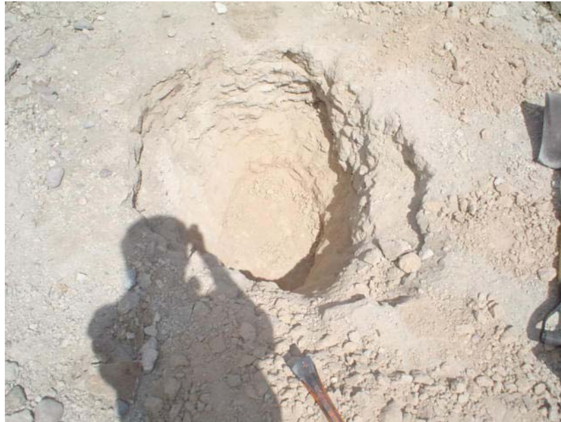
Fotografía 1 Excavación de los pozos
