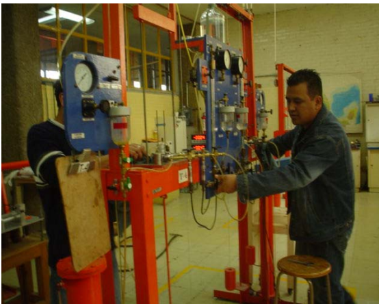
Supervisión de las líneas de conducción para evitar posibles fugas y burbujas de aire.
