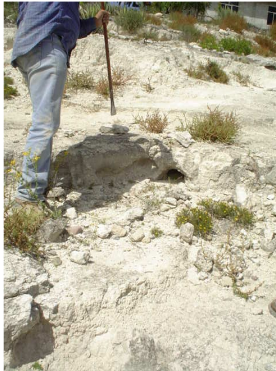
Fotografía 13 Talud en la colindancia
