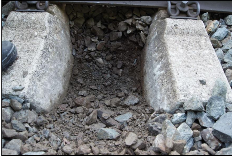
Figura 10. Balasto contaminado. (Wan et al., 2022)
