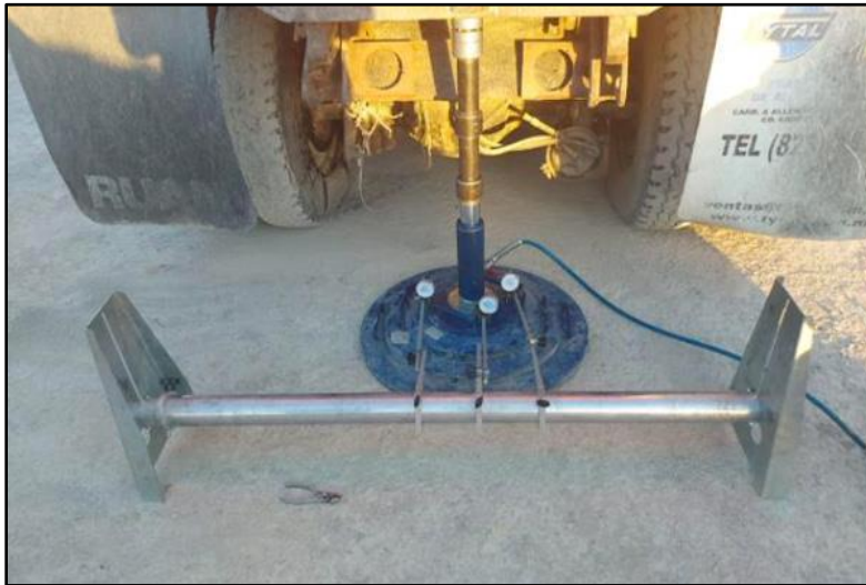
Figura 17. Prueba de placa. (Admin, 2023)
