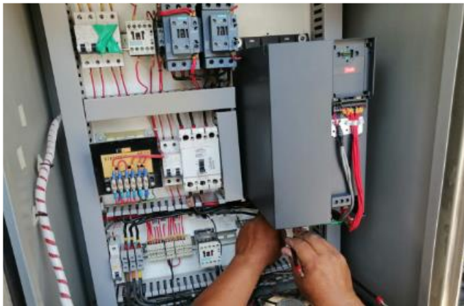
Instalación de variador de frecuencia en el tablero de la bomba Secundaria 02 (Mantenimiento Correctivo Programado).
