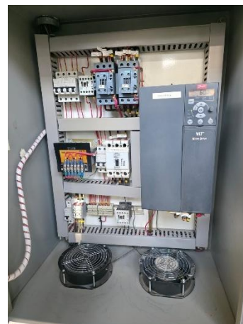
Inspección, corrección y reemplazo de ventiladores de inyección y de extracción en tableros de control.
