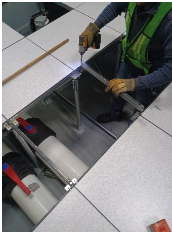
Nivelación de piso falso. Revisión de piezas, travesaños y postes. Sellado de pasos en cámara plena.
