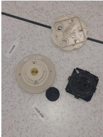
Revisión y limpieza de los 224 detectores del sistema de detección de incendio (humo y calor).
