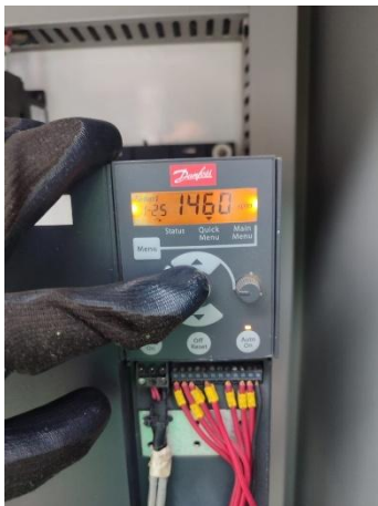
Inspección y limpieza de los variadores de frecuencia en los tableros de las bombas Secundaria 01 y 03.
