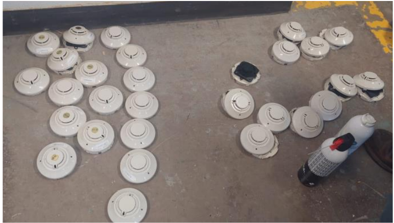
Revisión y limpieza de los 224 detectores del sistema de detección de incendio (humo y calor).
