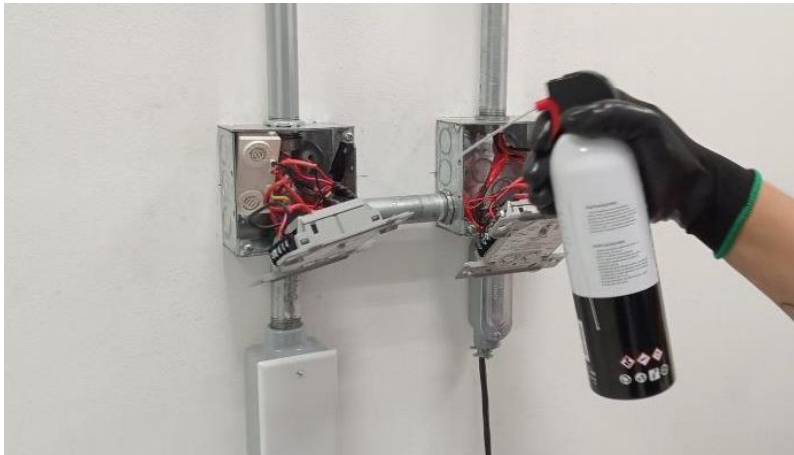
Revisión y limpieza de los 224 detectores del sistema de detección de incendio (humo y calor).
