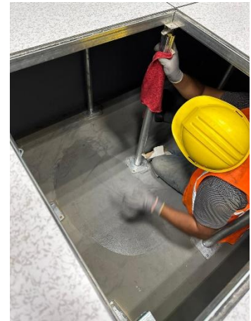
Nivelación de piso falso. Revisión de piezas, travesaños y postes. Sellado de pasos en cámara plena.
