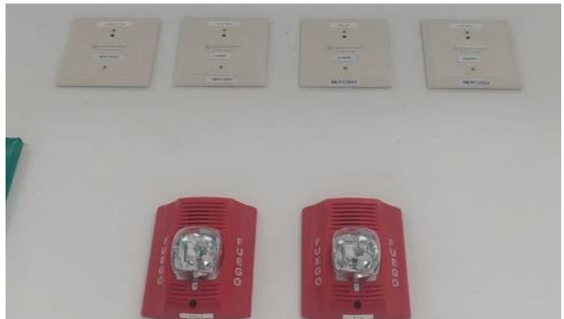
Revisión y limpieza de los 134 módulos del sistema de detección de incendio (control, relay y monitoreo).
