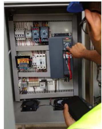
Instalación de variador de frecuencia en el tablero de la bomba Secundaria 02 (Mantenimiento Correctivo Programado).
