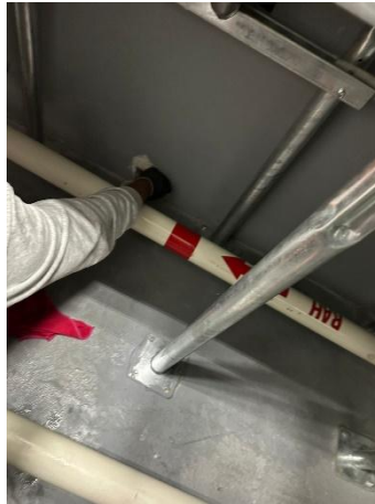
Nivelación de piso falso. Revisión de piezas, travesaños y postes. Sellado de pasos en cámara plena.
