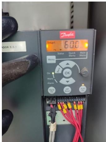
Inspección y limpieza de los variadores de frecuencia en los tableros de las bombas Secundaria 01 y 03.
