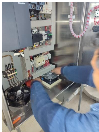
Inspección, corrección y reemplazo de ventiladores de inyección y de extracción en tableros de control.
