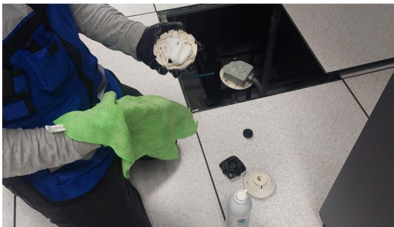
Revisión y limpieza de tablero Notifier.
