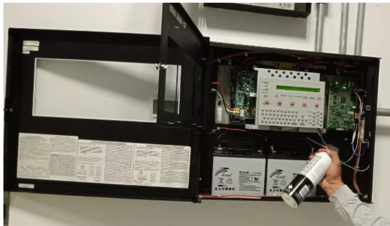
Revisión y limpieza de tablero Notifier.
