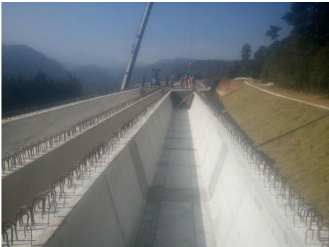
En la imagen se puede mostrar como se ve una trabe desde arriba, las tabletas forman la losa.
