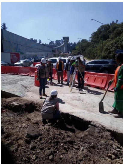
Se puede observar el monitoreo de una excavación para la fabricación de una guarnición. Se revisa que el trabajo se haya realizado dentro del trazo marcado.
