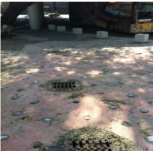
Figura B2.- La presencia de árboles en la zona de recarga al acuífero, afecta con la presencia de materia orgánica y su obstrucción a lo largo del tren de conducción.
