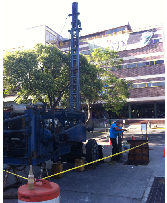
Figura B25.- El Pozo de Química durante el tiempo de limpieza
