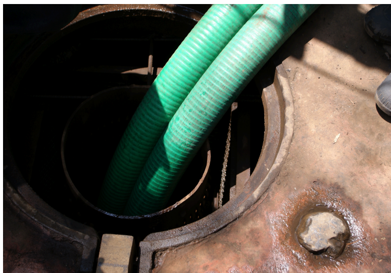
(b) Bombeo del agua para determinar si el ademe y el pozo han quedado limpios
