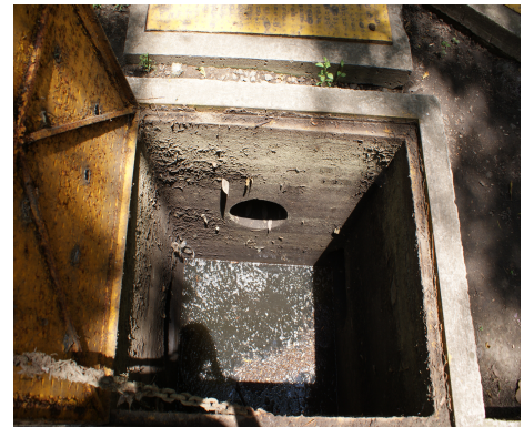
Figura 4.9.- Trampa para retener sólidos
