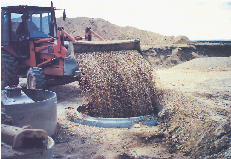
Figura 2.7.- Construcción de una trinchera de infiltración
