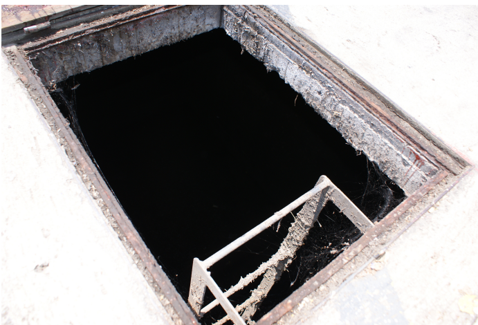
Figura B9.- Escalera de descenso a la cisterna de almacenamiento
