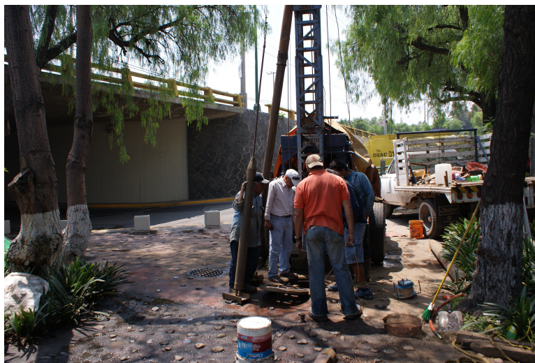
(a) Uso de martinete y escobillas de alambre para la limpieza del ademe
