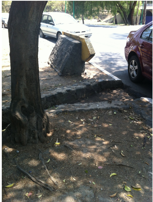
Figura B26.- El Pozo de Beisbol cuenta con canaletas sin rejilla, teniendo obstrucción de restos orgánicos
