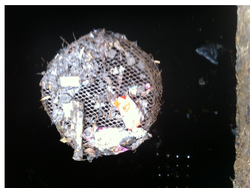
Figura 4.8.-Detención de residuos en el pozo de Economía
