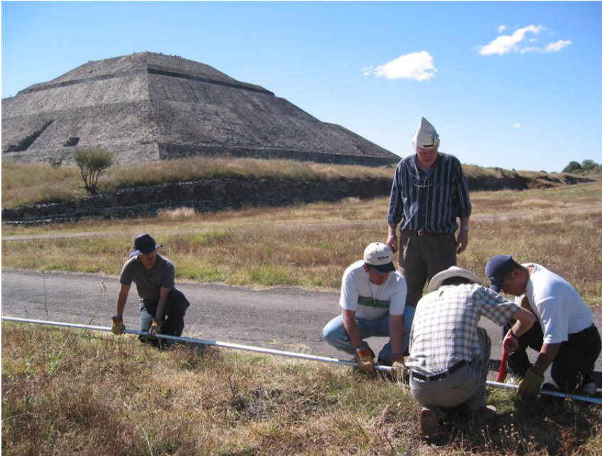
Figura 3.2 Instalación de energía
