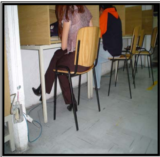
Fotografía 20 En esta fotografía se puede observar un nodo de red implementado en condiciones de premura y austeridad el cual traerá costos mayores ya que este material en poco tiempo no funcionará y se tendrá que gastar nuevamente en la implementación, se observan cables UTP CAT. 5E y UTP CAT. 5, enredado con una toma de energía eléctrica sin sujetar solamente está fijado por los UTP's que están sujetos en la extensión de energía eléctrica y su trayectoria como se observa va en el piso entre los pies de los usuarios.
