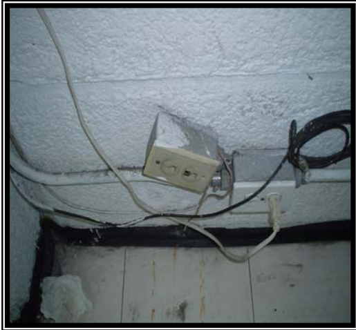
Fotografía 13 En esta fotografía se puede observar un nudo de voz enredado en una tubería de energía eléctrica además hay cables eléctricos de algún otro equipo electrónico así como una extensión de cable telefónico todos estos enredados en la tubería.
