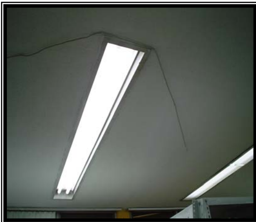
Fotografía 17 Conjunto de fotografías que muestran como el UTP pasa cerca de las lámparas sin respetar los estándares de distancias entre las lámparas y las trayectorias de comunicaciones debe ser una distancia mínima de 30 cm.
