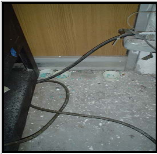
Fotografía 6 Muestra un par de fotografías con las tomas de energía eléctrica y como se puede observar van en contra del estándar de alimentación a equipos de comunicaciones
