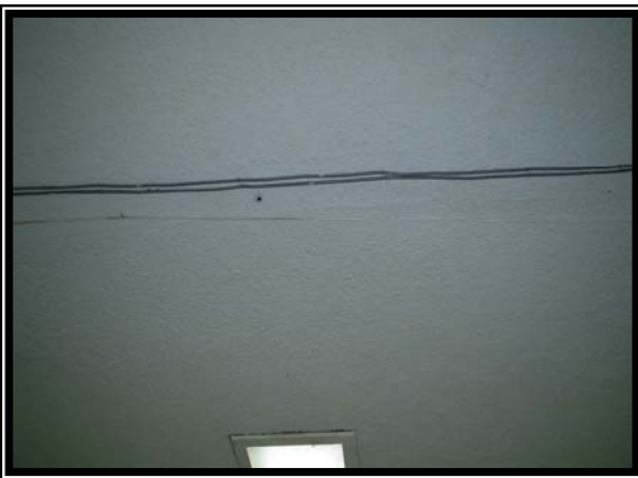
Fotografía 31 Conjunto de fotografías que muestran canalización parcial ya que en unas partes solo esta el UTP sujeto con grapas o solamente la mitad de la trayectoria se encuentra canalizada.
