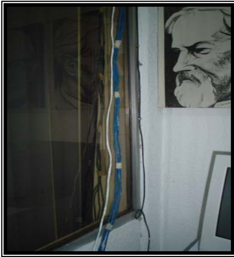
Fotografía 22 En esta fotografía se puede observar un mazo de cables UTP CAT 5E que vienen del Closet de Telecomunicaciones y llegan directamente a las tarjetas NIC de algunas computadoras y no pasan por algún nodo de datos.
