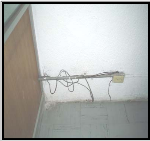
Fotografía 15 En esta fotografía se puede observa cable UTP CAT 5 enredado en una tubería de energía eléctrica así como parte de una extensión de energía eléctrica con las puntas sin aislar en la misma instalación Eléctrica, esto no solo va en contra de los estándares de comunicaciones sino de
