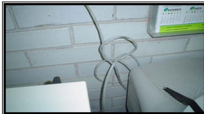
Fotografía 27 En esta fotografía se puede observar como dentro de un cubículo esta el cable UTP CAT 5 hecho nudo en algunas partes y otras se observa que esta muy doblado esto puede crear demasiadas contingencias de red.
