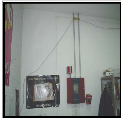
Fotografía 16 En esta fotografía es del área de préstamos, donde se observa cableado de UTP que va por la pared sujetado con cinta canela a una tubería muy probablemente de energía eléctrica.
