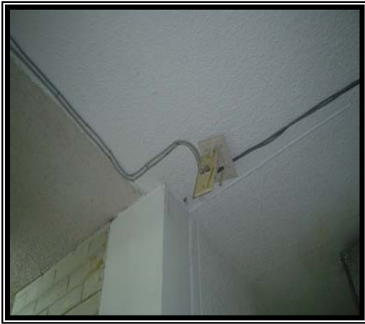
Fotografía 18 En esta fotografía se puede observar un nodo de red en el techo de falso plafón, el cual se encuentra a punto de caer y no está canalizado solo se encuentra engapado lo cual puede cortar algunos hilos de UTP por la presión ejercida en el mismo.
