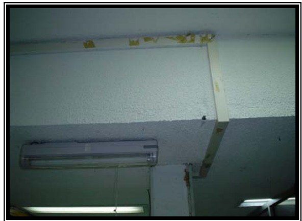
Fotografía 31 Conjunto de fotografías que muestran canalización parcial ya que en unas partes solo esta el UTP sujeto con grapas o solamente la mitad de la trayectoria se encuentra canalizada.
