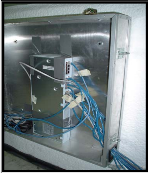
Fotografía 27 En esta fotografía se puede observar dentro de un registro un hub 3COM para potenciar la señal y distribuir más servicios de red esto puede crear demasiadas contingencias de red, no esta bien sujeto y los UTP's no se encuentran arreglados con cinturones.
