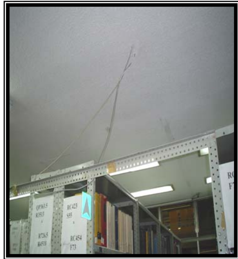
Fotografía 23 En esta fotografía se puede observar cable UTP CAT. 5 colgando del techo al área de estantes se puede observar que en la parte de atrás existió una canalización que muy probablemente se despegó con el tiempo o la quitaron por las constantes remodelaciones
