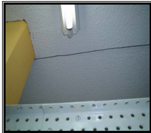
Fotografía 17 Conjunto de fotografías que muestran como el UTP pasa cerca de las lámparas sin respetar los estándares de distancias entre las lámparas y las trayectorias de comunicaciones debe ser una distancia mínima de 30 cm.
