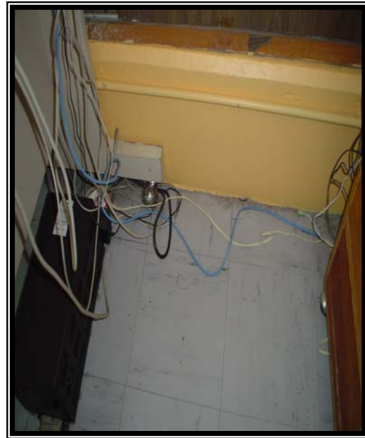
Fotografía 26 Par de Fotografías que muestran como llega el UTP desde el Closet de Telecomunicaciones sin tener una estructura de trayectoria completa con nodos de salida.
