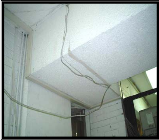
Fotografía 9 En esta fotografía se puede apreciar la entrada de la biblioteca y el cableado que se realizó para colocar otra computadora en red para la consulta al sistema de prestamos, se tiene diferente categoría de cable UTP además que no se encuentran ni canalizado ni bien sujeto al techo.
