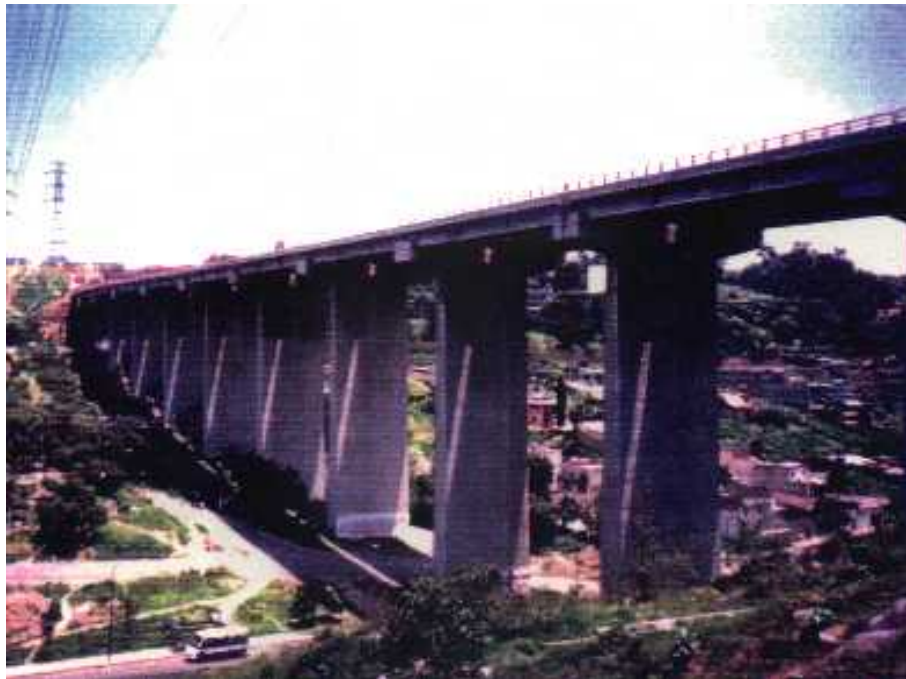
Figura IV.1. Vista Panorámica del Puente “Viaducto Atizapán”
