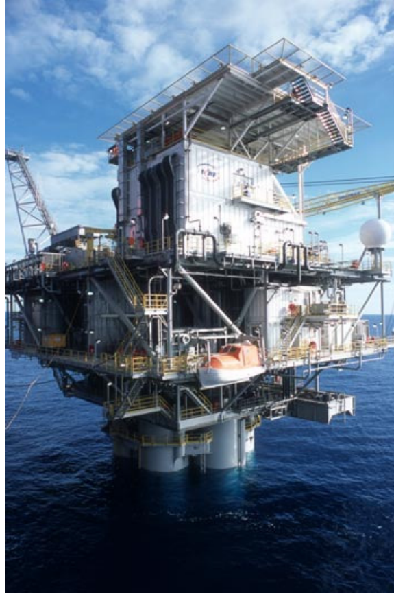
Figura II.6 Cubierta de la plataforma Spar Red Hawk.
