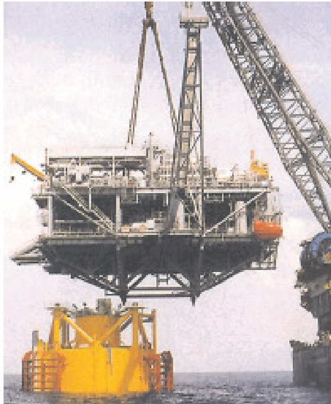
Figura II.5 Cubierta en instalación.
