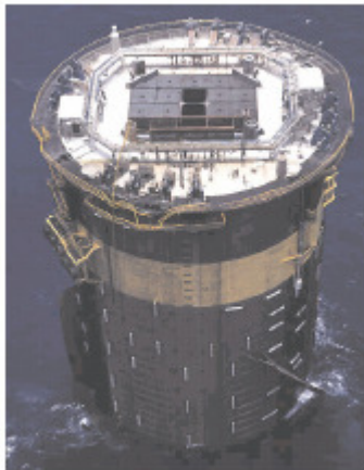
Figura II.8 Casco instalado.
