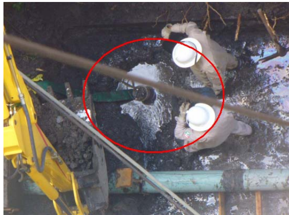
Fotografía 13. Colocación de bomba para abatir el nivel de aguas freáticas, edificio "B".
