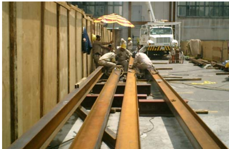
Fotografía 33. Suministro de estructura metálica al conjunto Verónica
