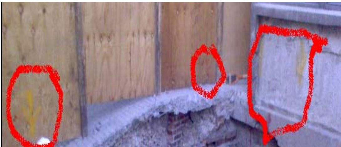
Fotografía 6. Los recuadros y círculos encierran las marcas del nivel, así como de los ejes de las trabes que conforman la cimentación.
