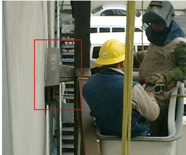
Fotografía 42. Montaje y soldado de placa de conexión deslizante.
