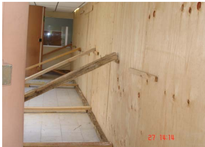
Fotografía 5. Protección de las instalaciones del departamento de Inspección, realizada con tapiales a base de hojas de triplay y polines, ubicadas en el interior del primer nivel del edificio “B”.
