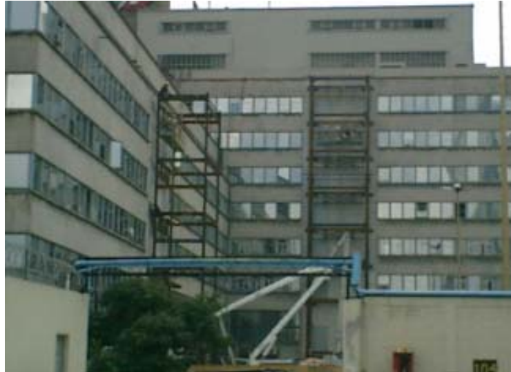
Fotografía 38. Vista de las torres de escaleras, después de realizado el montaje de traveses.
