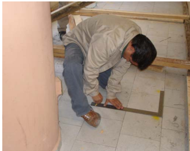
Fotografía 7. Trazo del cajón donde esta proyectada la trabe TC-1 para su anclaje a losa existente dentro de las instalaciones del edificio “B”.
