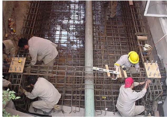
Fotografía 24. Colocación y nivelación de anclas y placa base, edificio "B"
