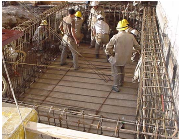
Fotografía 21. Armado de losa una vez concluidas las trabes TC-1 y TC-2.
