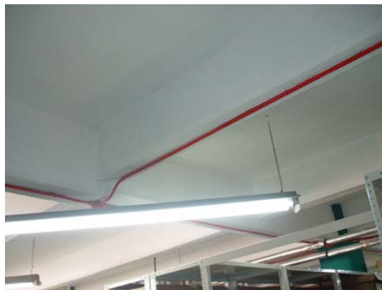
Figura 2.4 Detalle de traveses principales y secundarios
