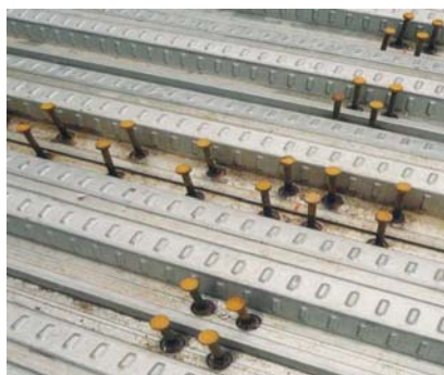
Figura 2.6 Sistema losacero con pernos de cortante
