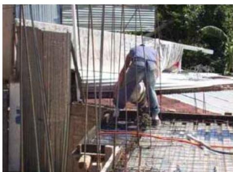
a. Colado de cerramientos
