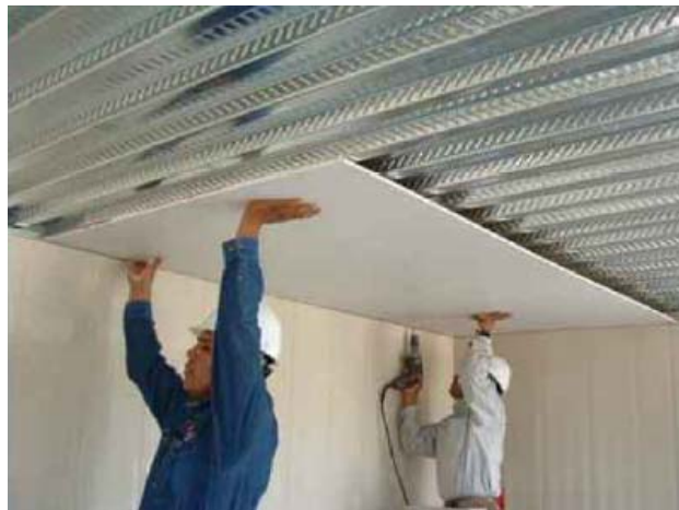
Figura 2.10 Protección contra el fuego mediante un plafón falso.
