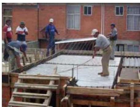
Figura 3.8 Colocación del refuerzo por temperatura
