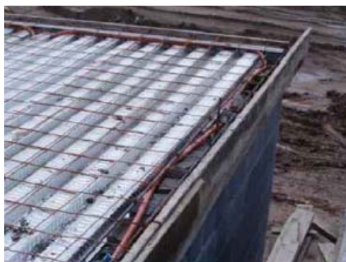
Figura 3.6 Fronteras en el perímetro empleando tabloncillos
