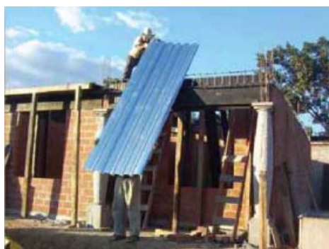
Figura 3.4 Izaje de la lámina losahabit
