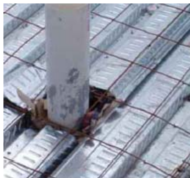
Figura 3.9b Colocación de las instalaciones sanitarias.
