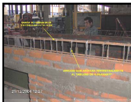
Figura 4.4 Colocación del refuerzo perimetral
