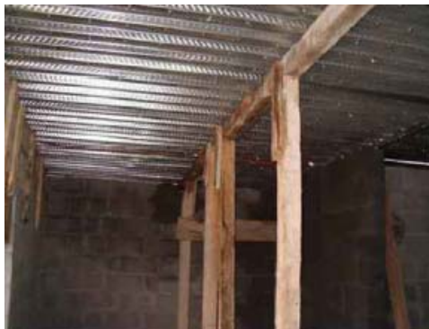
Figura 3.5 Apuntalamiento de la losahabit
