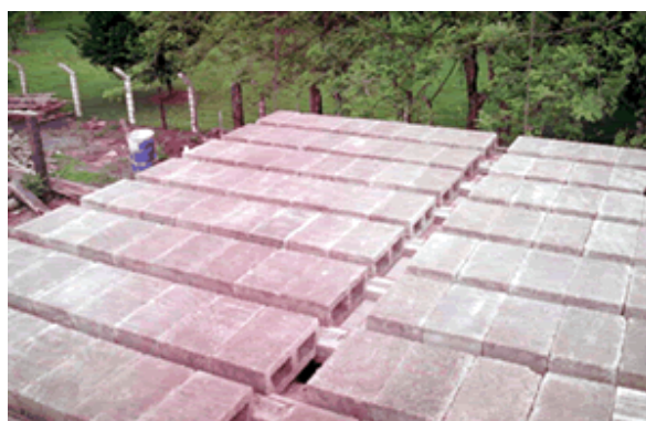
Figura 1.3 Entrepiso con elementos de concreto prefabricados
