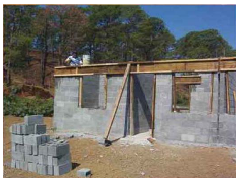
Figura 3.3 Preparación de los muros de apoyo
