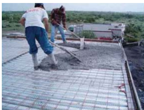
c. Distribución del concreto
