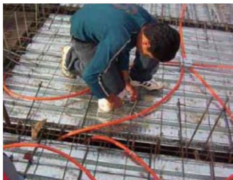
Figura 3.9a Colocación de las instalaciones eléctricas.
