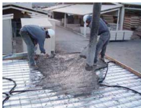
b. Vaciado del concreto
