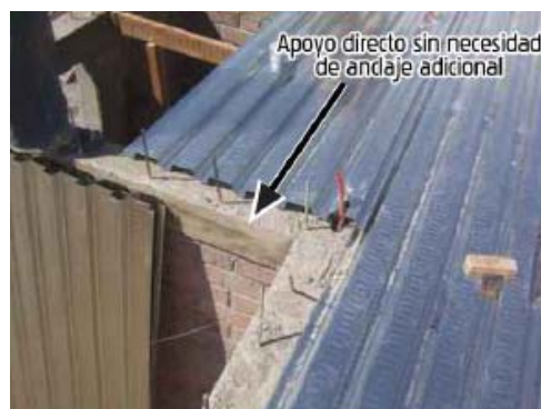
Figura 3.7 Instalación de losahabit directamente sobre muros
