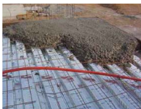
d. Nivel constante del concreto
