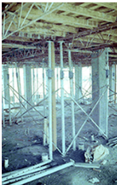
Figura 1.4 Cimbra para entrepisos de hormigón armado
