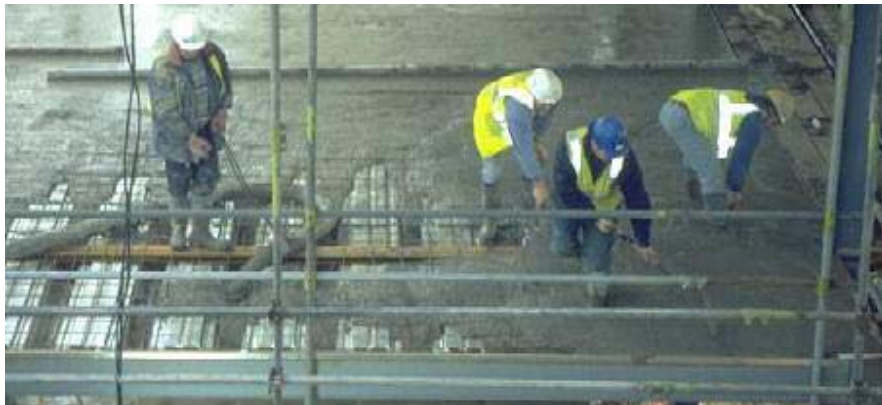
Figura 2.8. La lámina funciona como cimbra
