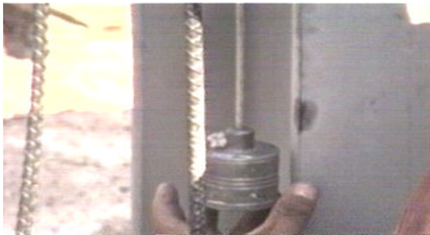
Figura 3.3.1. Plomeo en muros
