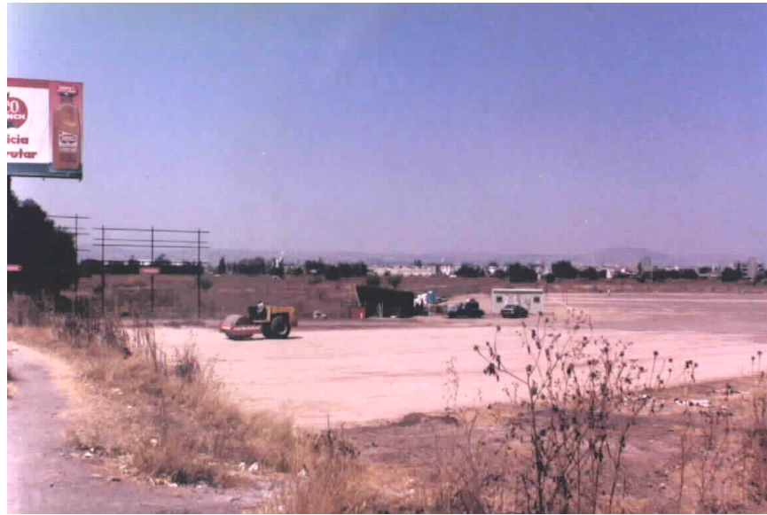
Figura 3.2.2. Compactación del terreno
