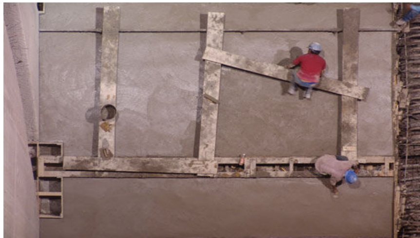
Figura 3.2.3. Colado de plantilla de concreto pobre
