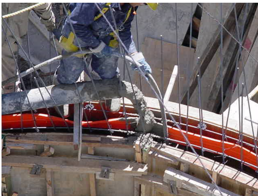
Figura C.8 Colado de elementos del filtro percolador y colocación de banda de PVC de 152 mm (6 pulgadas) en juntas frías.
