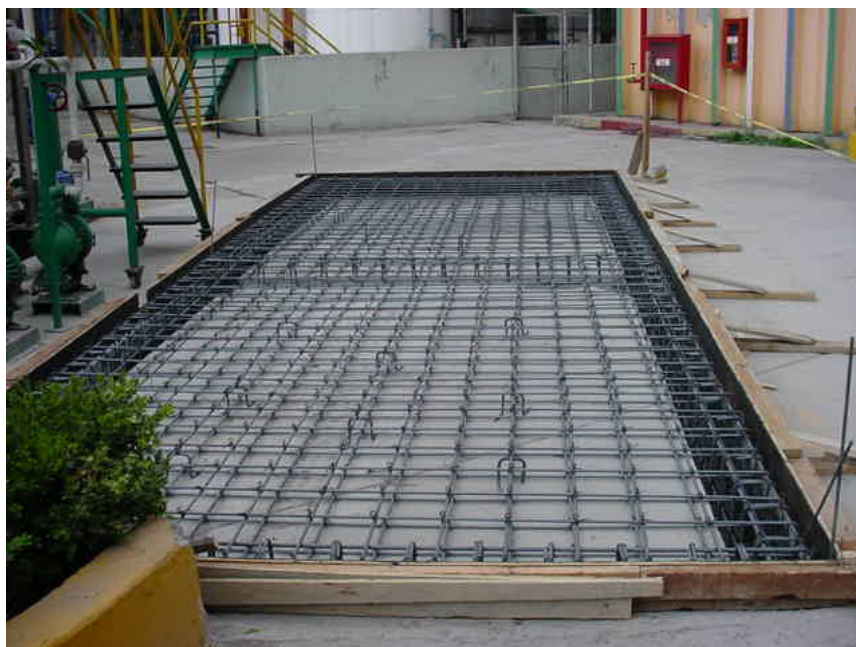
Figura C.13 Habilitado de cimbra y acero de refuerzo para base del Sistema de Flotación por Aire Disuelto (Dissolved Air Flotation DAF)
