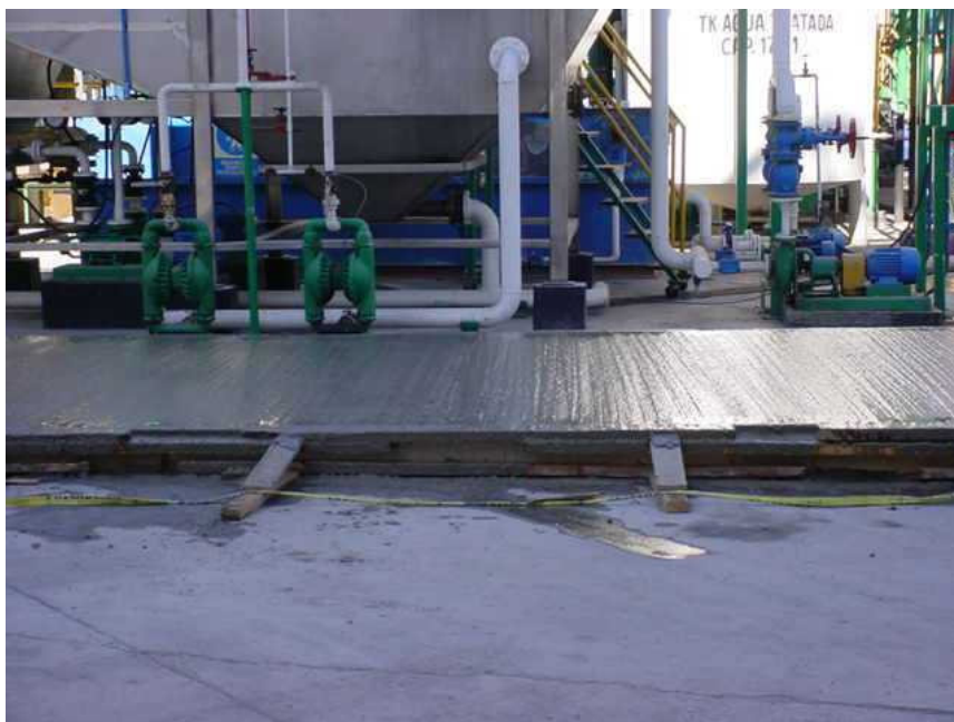
Figura C.14 Concreto premezclado para base del Sistema de Flotación por Aire Disuelto (Dissolved Air Flotation DAF)
