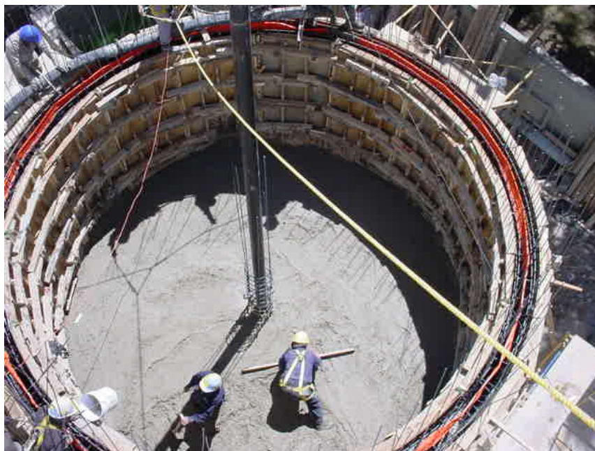
Figura C.7 Colado de elementos del filtro percolador.
