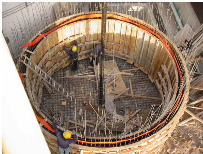
Figura C.5 Habilitado de cimbra y colocación de banda de PVC de 152 mm (6 pulgadas).
