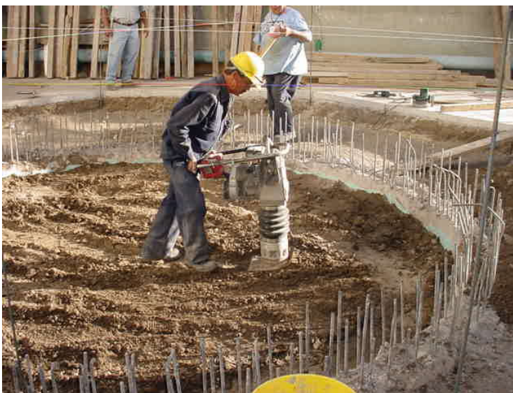
Figura C.2 Relleno y compactación al 90% de la prueba Proctor estándar en base de filtro percolador.
