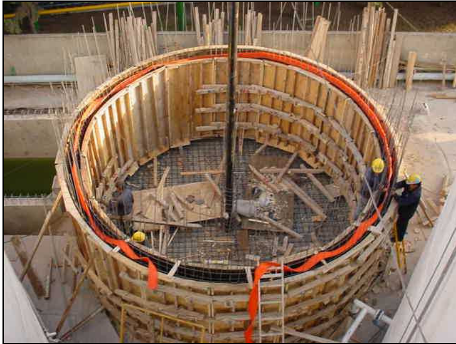
FIGURA IV.3 “HABILITADO DE CIMBRA DE FILTRO PERCOLADOR”
