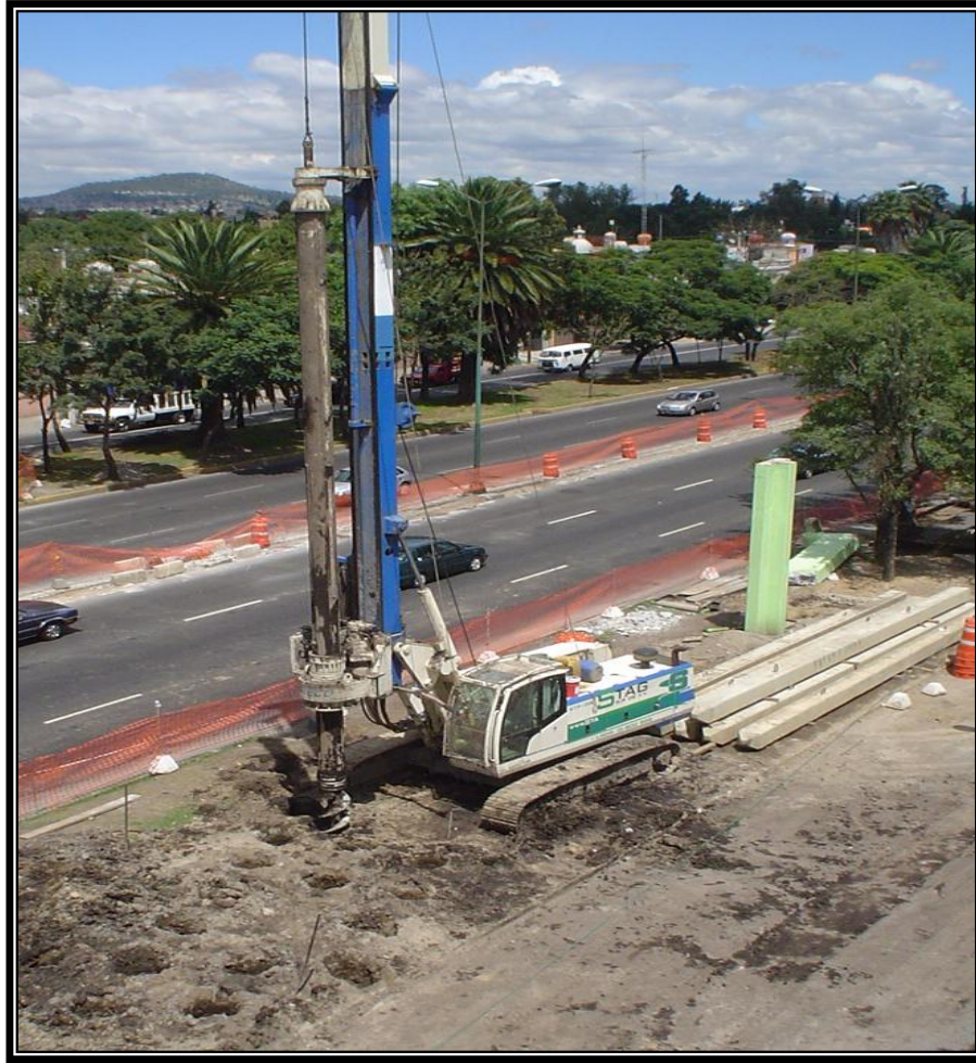
Figura IV.4.1.1a.- Proceso de la perforación guía para el hincado de pilotes.
