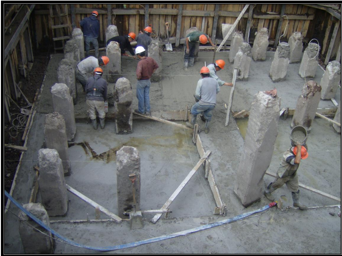
Figura IV.6.1.- Colocación de plantilla de concreto pobre.
