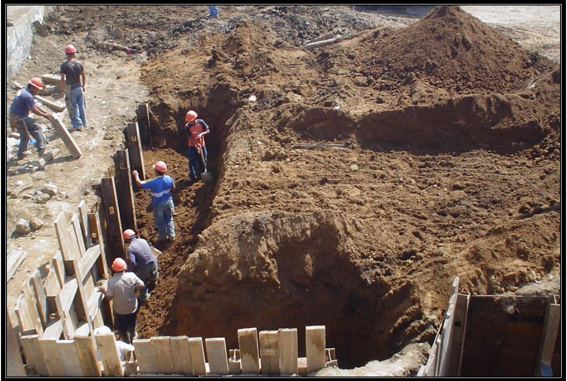
Figura IV.5.1.3a.- Proceso de colocación de la contención temporal de la excavación en obra.
