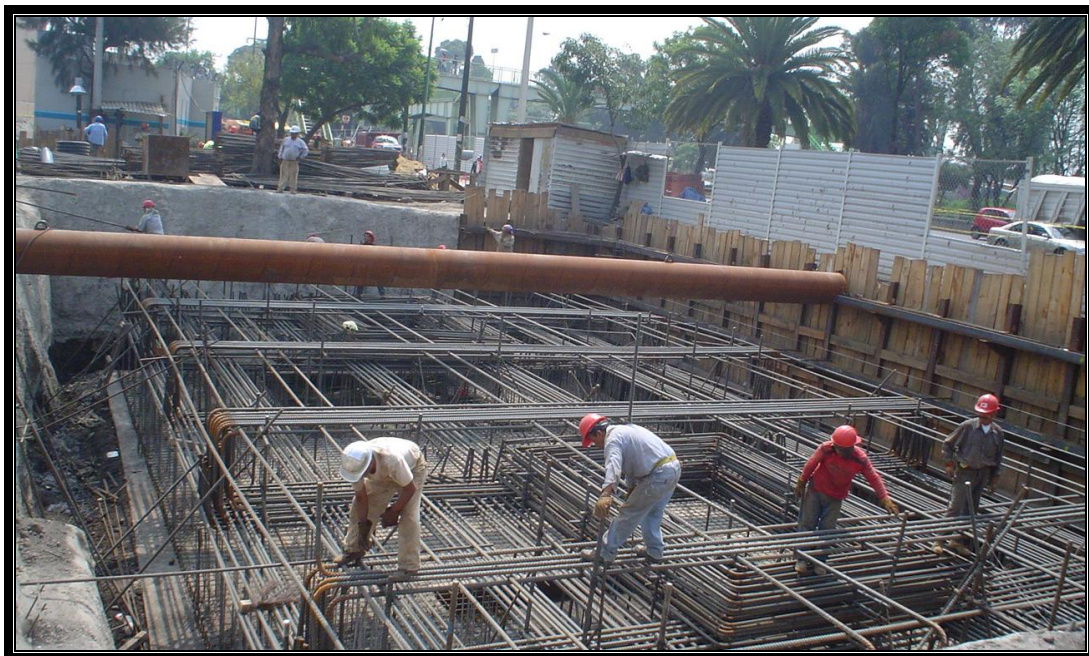
Figura IV.7.1.3b.- Trabajos de colocado de acero para contratraveses.
