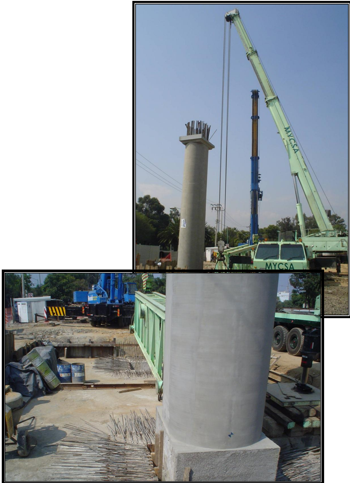
Figura IV.8.4.2.- Izado y colocación de la columna A10.
