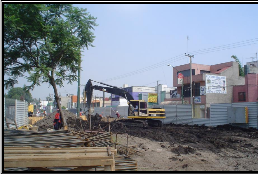
Fig. II.1.2.2a.- Uso del suelo sobre Calzada Acoxa e inicio de zona de obra.
