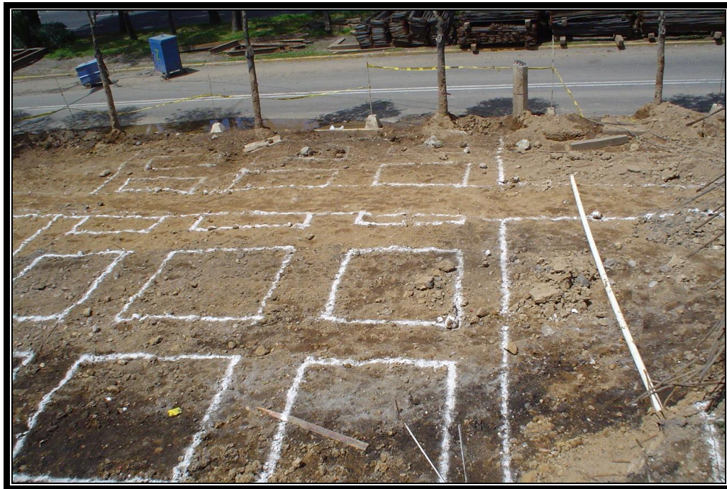
Figura IV.2.2.- Marcado de ejes de zapata E2, sobre la lateral de periférico.
