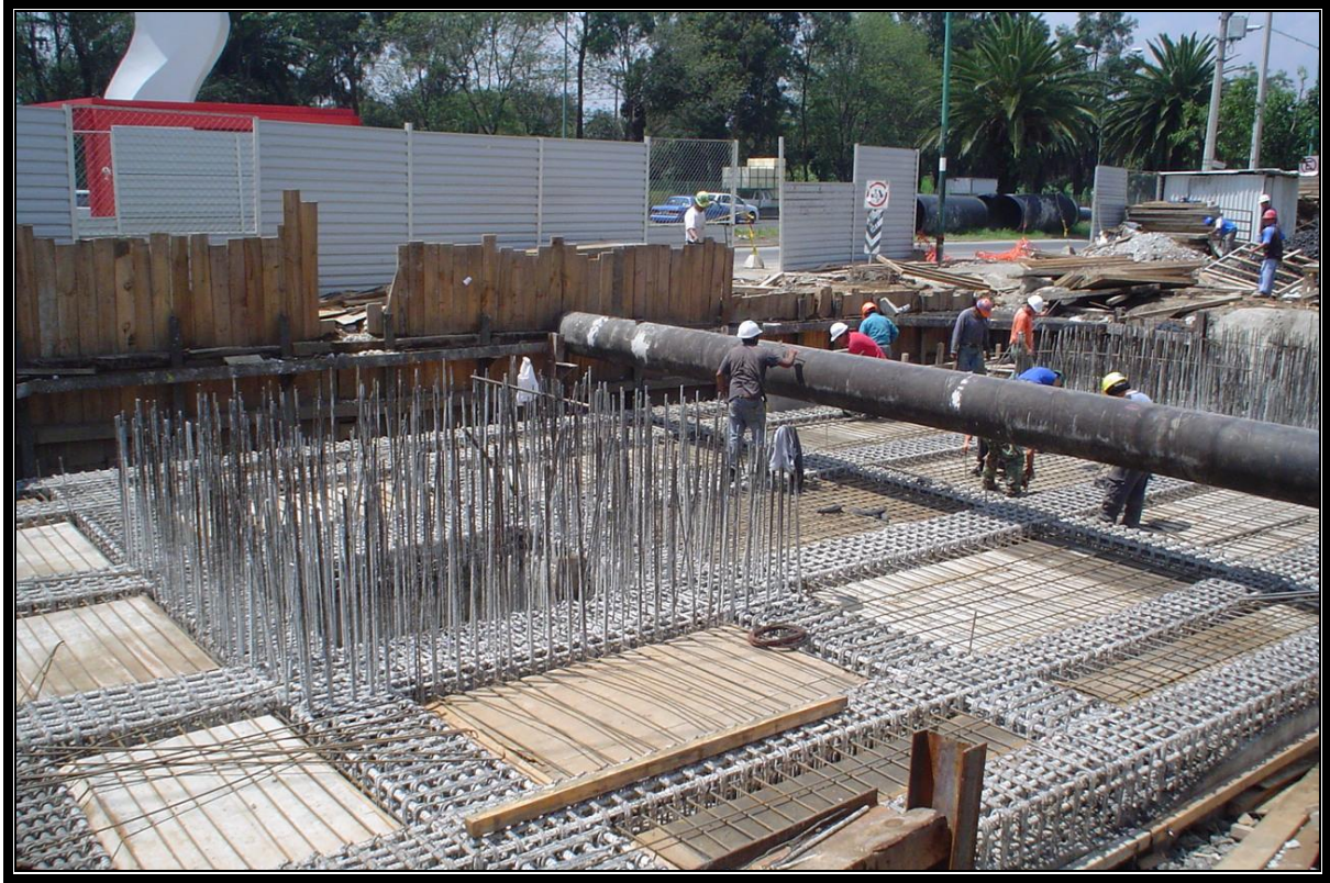
Figura IV.8.2.2.- Colocación del acero de refuerzo para la losa superior de zapata
