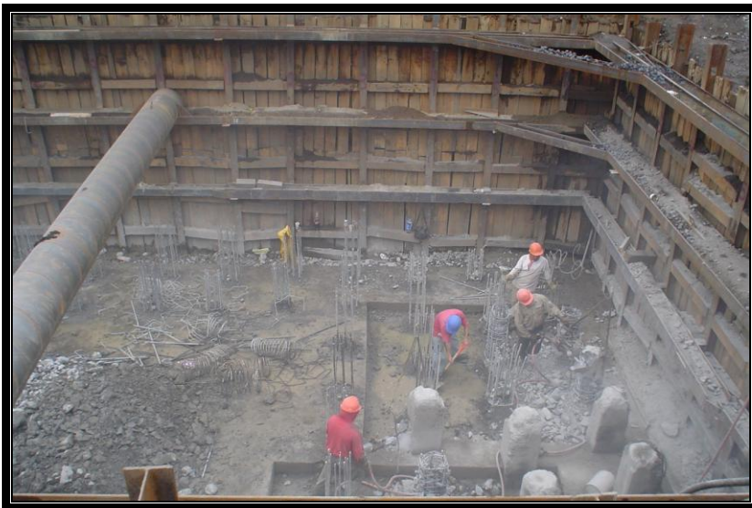
Figura IV.6.2a.- Proceso de descabece de pilotes
