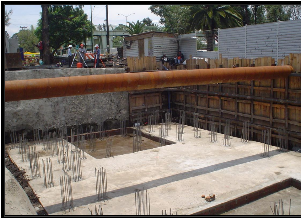
Figura IV.7.1.- Limpieza de la zapata y trabajos de topografía.
