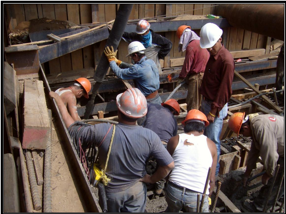
Figura IV.8.2.1.- Colado de zapata y trabajos de vibración del concreto.
