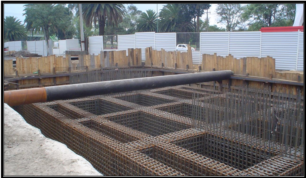
Figura IV.7.2.6.- Armado terminado de zapata A10 – A11.
