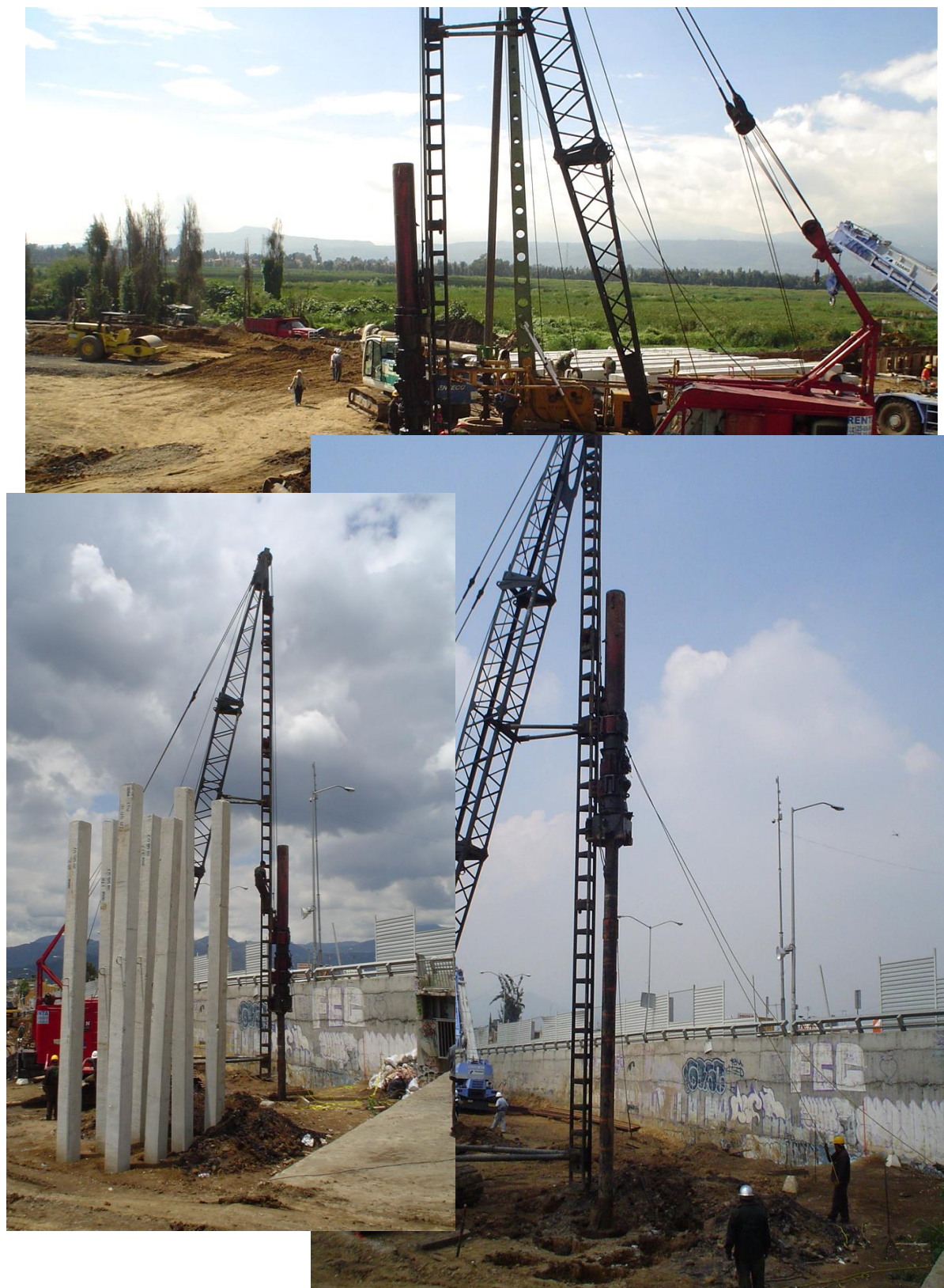
Figura IV.4.2.5a.- Proceso de hincado de pilotes sobre el frente de trabajo Sur (Av. Plan de Muyuguarda-Ciénega Chica).
