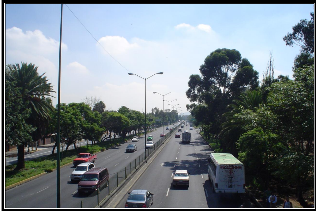
Fig. II.1.2.5.- Anillo Periférico Sur
