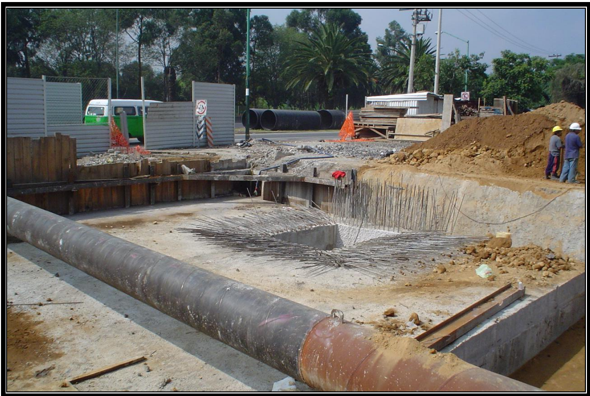
Figura IV.8.4.1.- Relleno de tepetate en la parte exterior de la zapata de cimentación.
