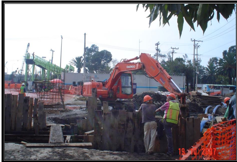
Figura IV.1.1.1.- Trabajos de reacomodo del sistema de drenaje sobre la calle Hacienda Mazatepec esquina Cafetales.
