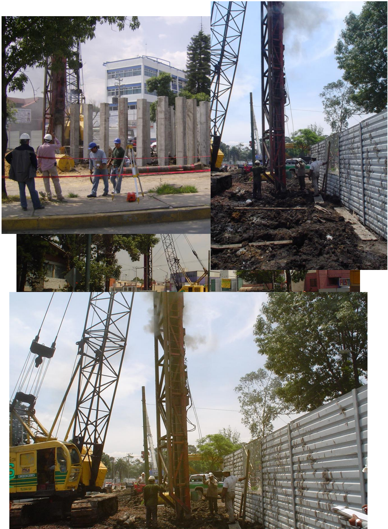
Figura V.4.2.5b.- Proceso de hincado de pilotes en el frente de trabajo Norte (Calzada Acoxa)
