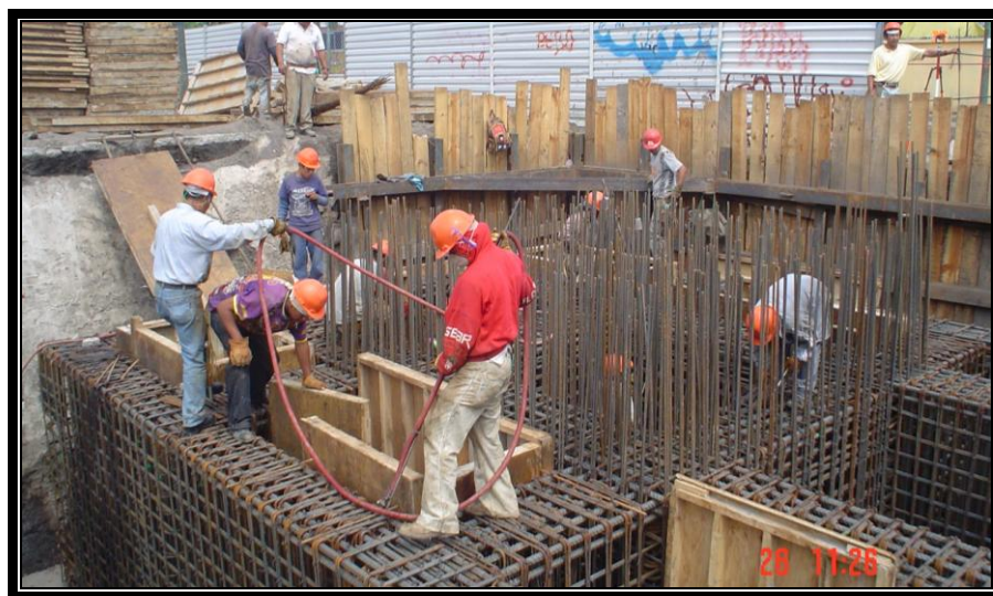
Figura IV.8.1.- Trabajos de limpieza en zapata, mediante el uso de aire comprimido
