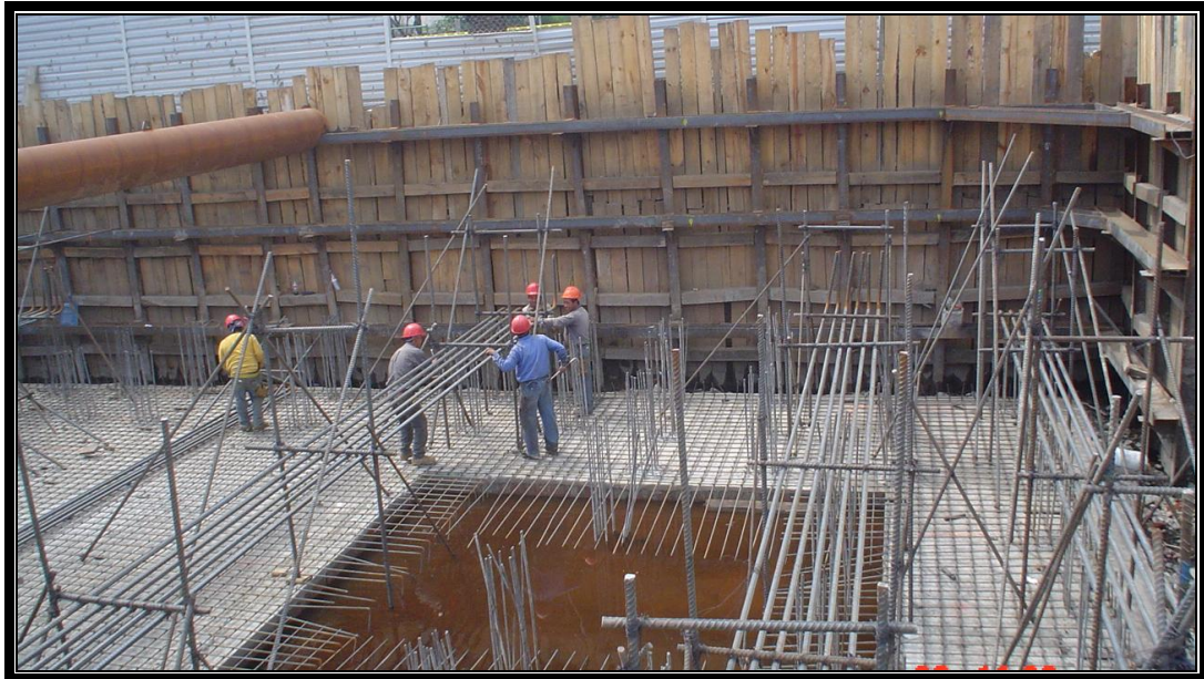
Figura IV.7.1.3a.- Colocado de varillas longitudinales para la losa inferior de zapata
