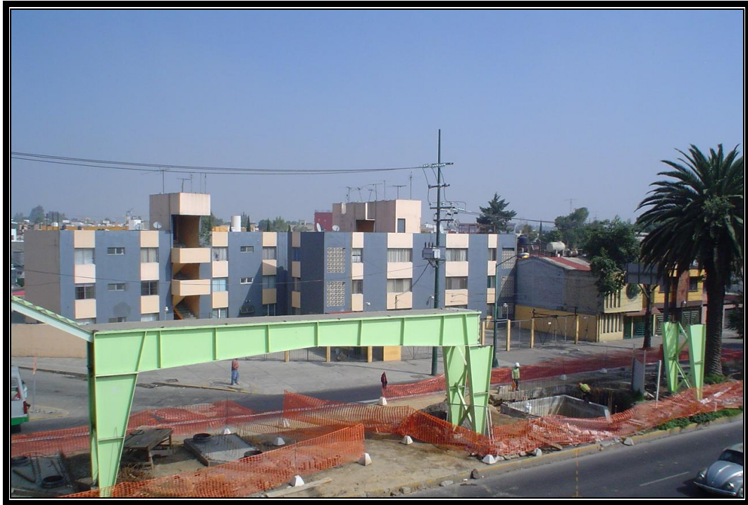
Figura IV.1.1.3.- Retiro definitivo de puente peatonal.
