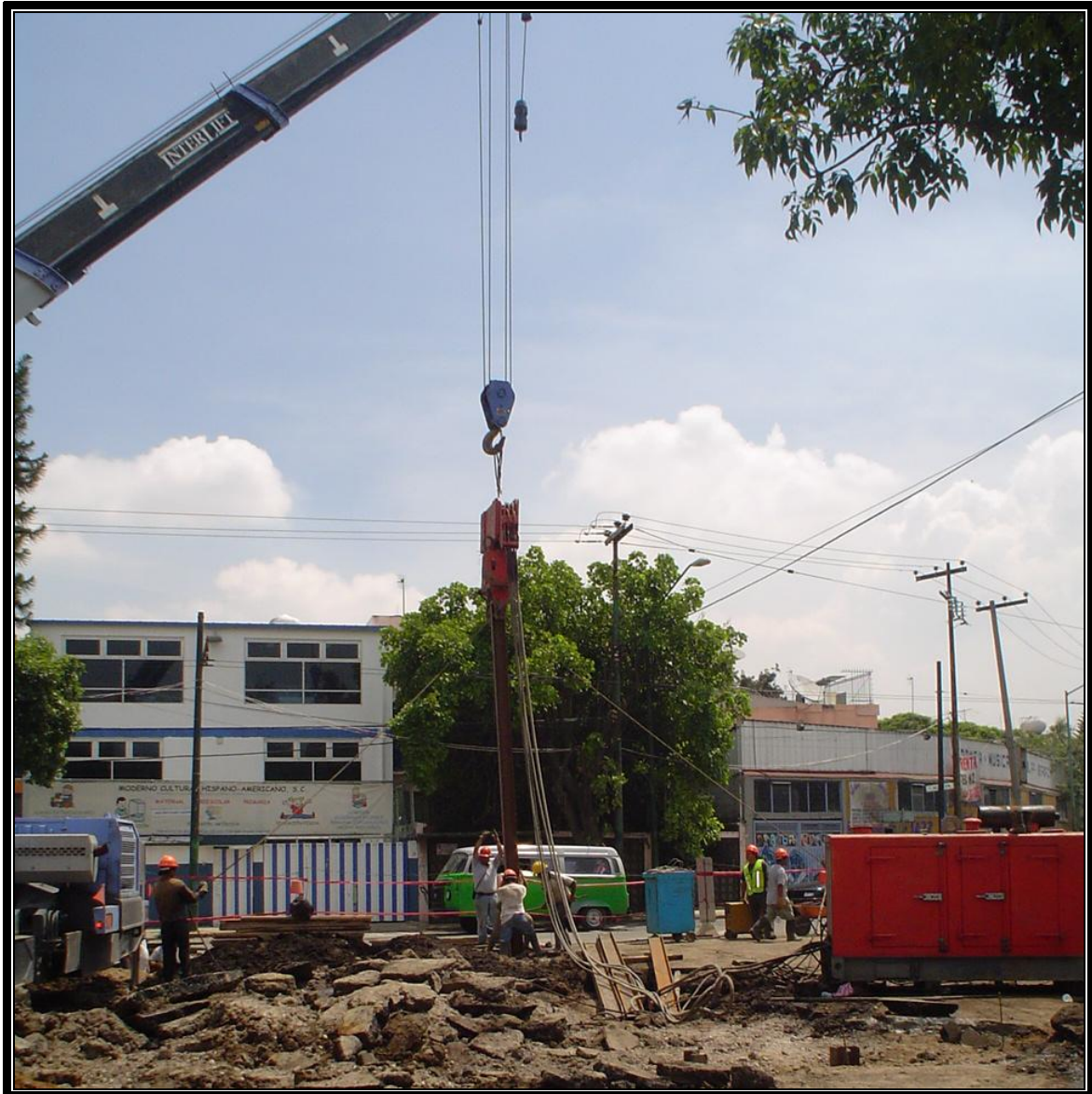
Figura IV.5.1.2.- Hincado de vigueta IPR ligera a base de un equipo vibrohincador, (Calzada Acoxpa).
