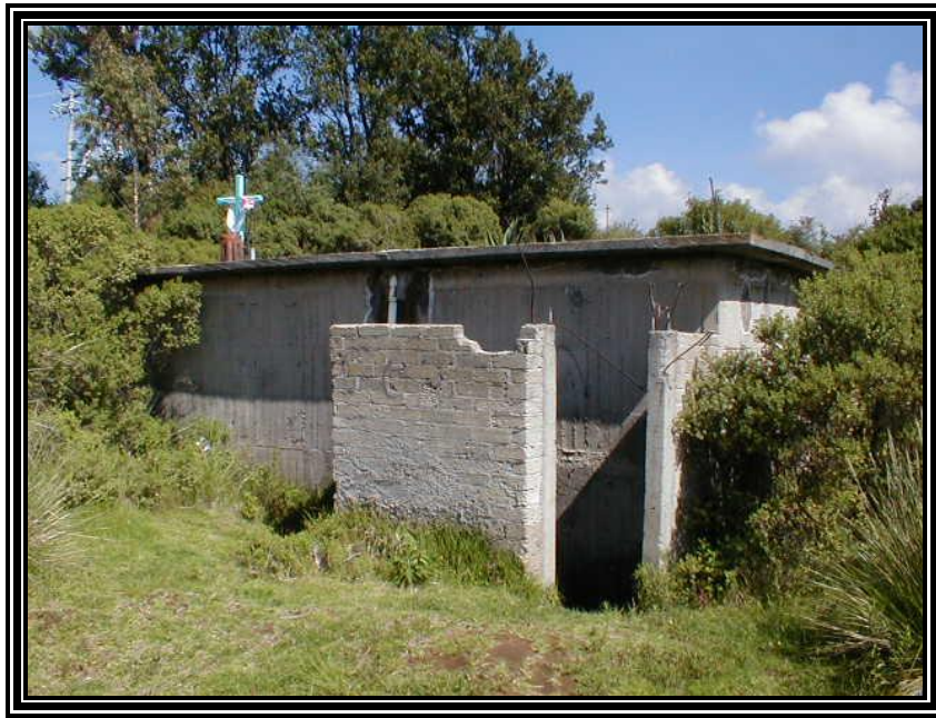
Figura 4.5 tanque de almacenamiento existente.
