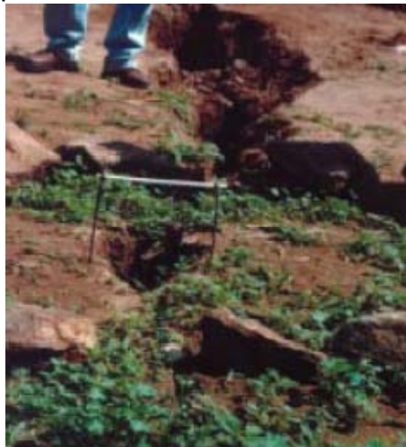
Figura 3.2.1.7. Agrietamiento de la superficie del terreno natural, como consecuencia de los hundimientos.
