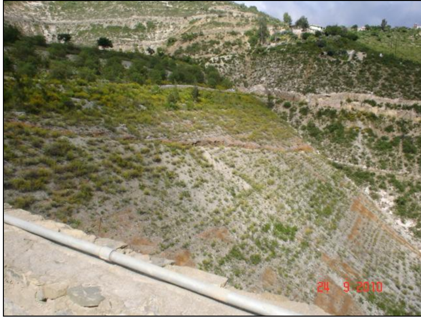
Figura 2 Talud de la Presa 1
