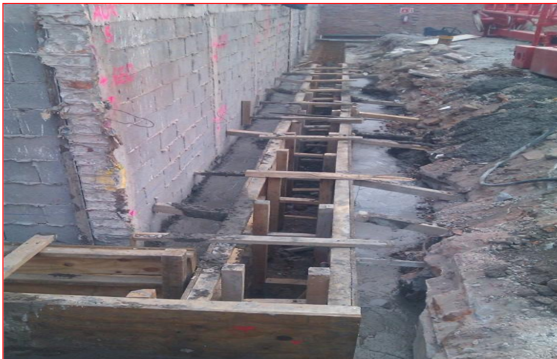
Figura 73. Zanja para alojamiento, previo a colado de brocal; Autor: Ing. Francisco Israel Callejas Quezada. (CIMESA 2011).
