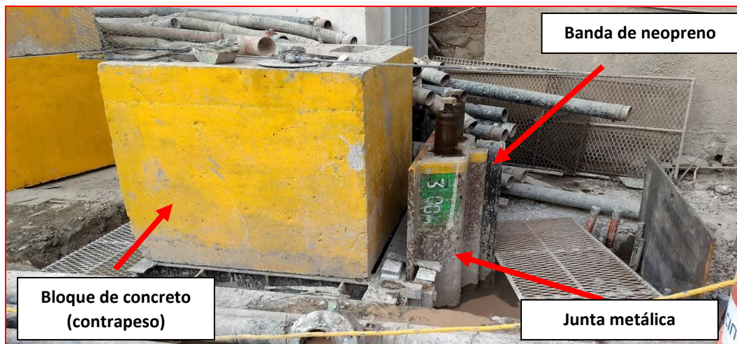
Figura 63. Junta CWS® colocada a un extremo del panel apoyada sobre un bloque de concreto para restringir su movimiento y evitar problemas de volteo. (CIMESA 2019).
