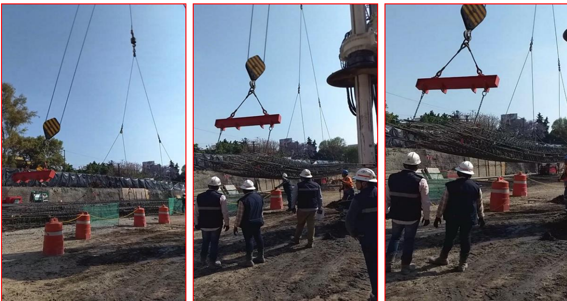
Figura 104, 105 y 106. Una vez colocados los elementos de izaje, se procede a levantar el armado de muro Milán; proyecto "MARNHOS, Lago Filt 7". (CIMESA 2018).
