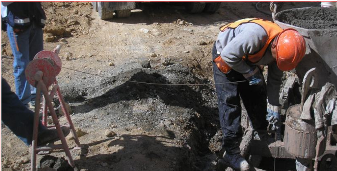
Figura 124. Revisión del nivel de concreto colado en panel de muro Milán; Autor: Ing. Francisco Israel Callejas Quezada. (CIMESA 2011).
