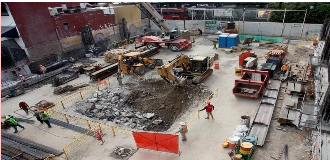
Figura 55. Retroexcavadora CAT 3C; proyecto "Chapultepec 360". (CIMESA 2016).
