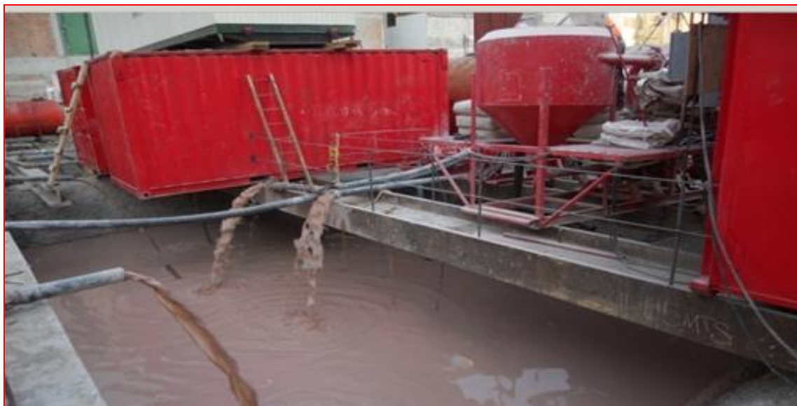
Figura 94. Desarenado de muro Milán; Autor: Ing. Francisco Israel Callejas Quezada. (CIMESA 2011).
