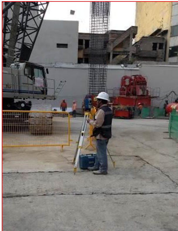
Figura 71. Estación total y brigada de topografía en el sitio de proyecto. (CIMESA 2019).
