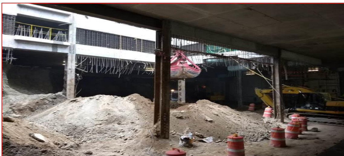
Figura 17. Ejecución de obra con método Top-Down; proyecto "MIRA, Río San Joaquín 498". (CIMESA, 2018).
