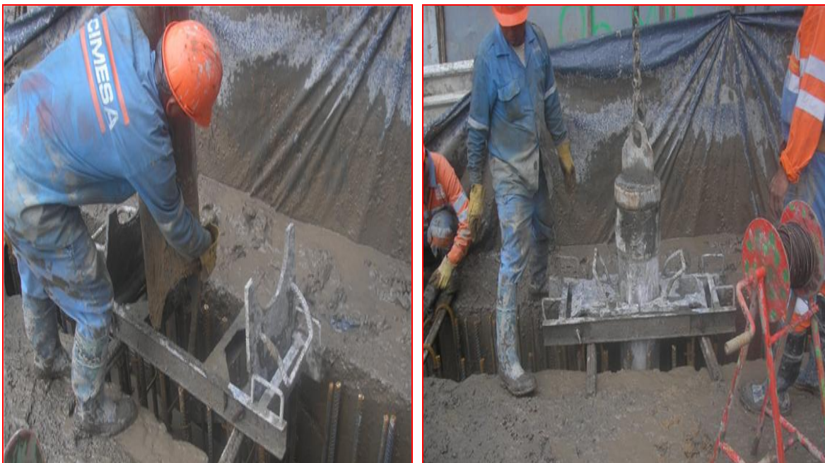
Figura 118 y 119. Colocación de tubería tremie, freno de tubería y sonda para la medición del nivel de concreto, previo al colado; Autor: Ing. Francisco Israel Callejas Quezada. (CIMESA 2011).
