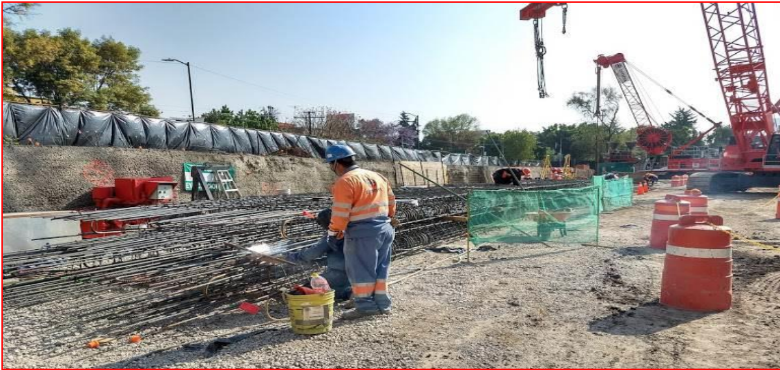
Figura 101. Trabajos de soldadura en armado de muro Milán; proyecto "MARNHOS, Lago Filt 7". (CIMESA 2018).
