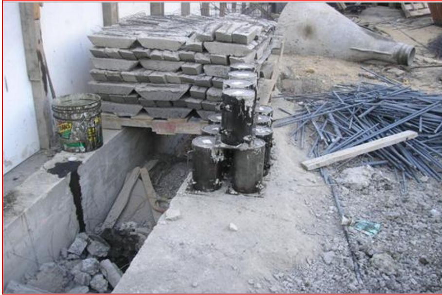
Figura 127. Cilindros para pruebas destructivas en concreto de muro Milán; Autor: Ing. Francisco Israel Callejas Quezada. (CIMESA 2011).
