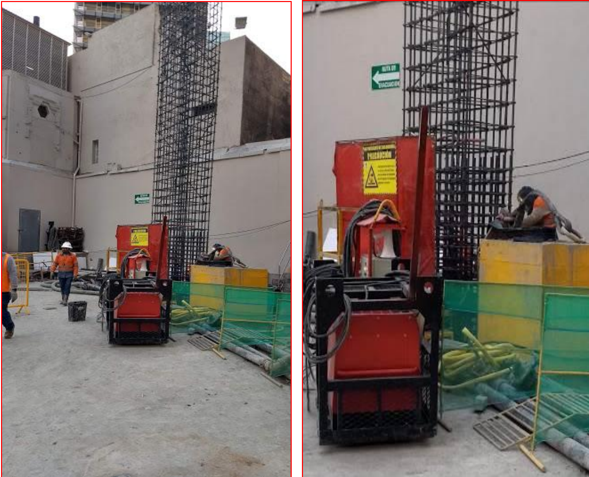
Figura 112 y 113. Trabajos de soldadura en el traslape de los armados de muro Milán en el sitio de obra. (CIMESA 2019).
