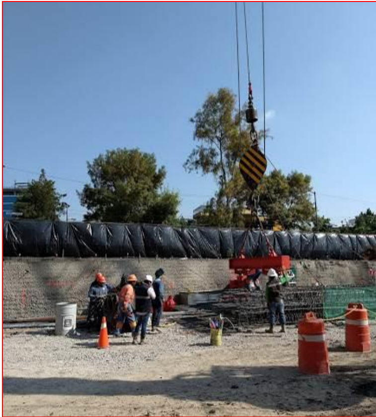
Figura 103. Inicio del izaje del armado de muro Milán; proyecto "MARNHOS, Lago Filt 7". (CIMESA 2018).
