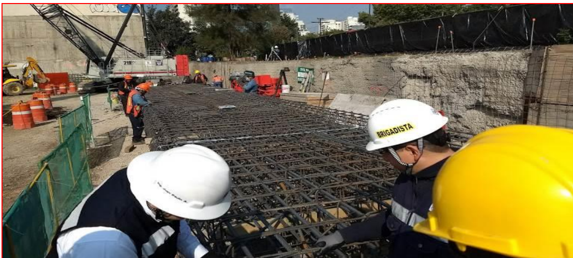
Figura 100. Revisión y verificación del armado de muro Milán; proyecto "MARNHOS, Lago Filt 7". (CIMESA 2018).
