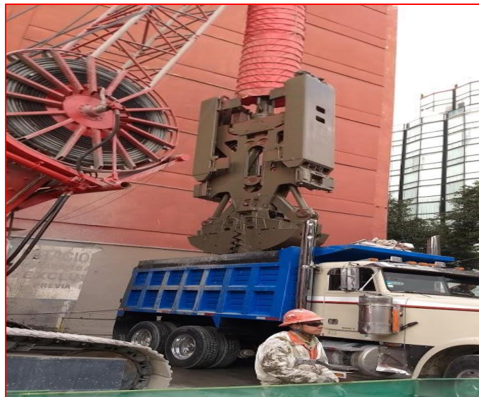
Figura 53. Grúa Liebherr HS 855 equipada con almeja hidráulica retirando el material de rezaga, previo a la colocación del armado de muro Milán. (CIMESA 2019).
