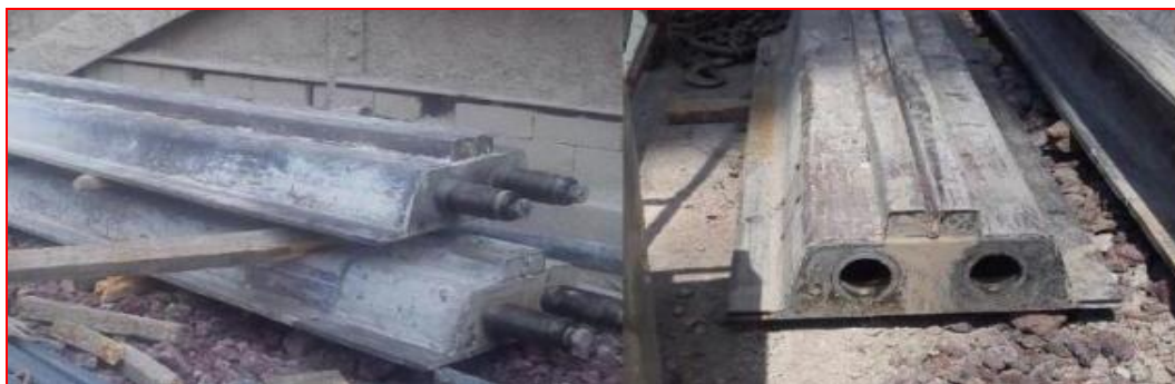
Figura 64. Junta metálica con sistema de macho y hembra; proyecto "Reforma 509". (CIMESA 2014).
