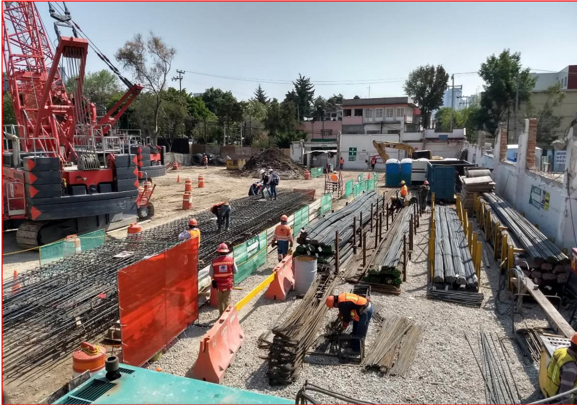
Figura 99. Habilitado de acero y armado de panel de muro Milan; proyecto "MARNHOS, Lago Filt 7". (CIMESA 2018).
