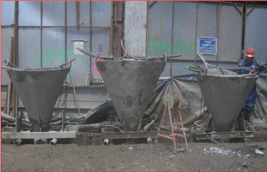
Figura 120. Colocación de tolvas para colado de muro Milán; Autor: Ing. Francisco Israel Callejas Quezada. (CIMESA 2011).
