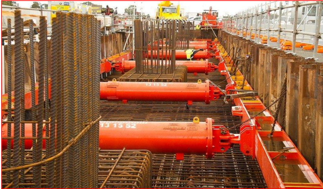
Figura 15. Uso de precarga en excavaciones. (Honvajec, Joseph. 2015).
