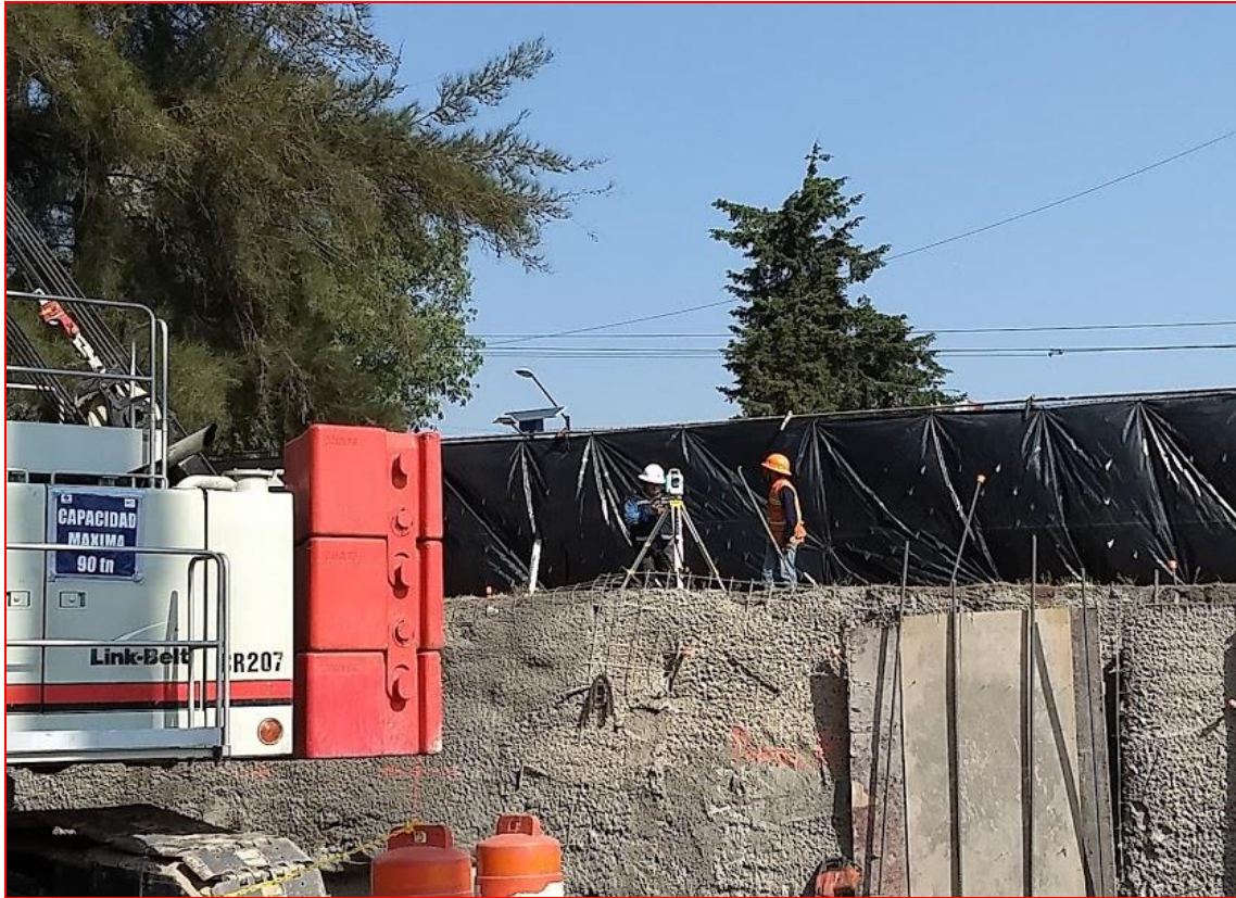
Figura 72. Estación total y brigada de topografía; proyecto "MARHNOS, Lago Filt 7". (CIMESA 2018).
