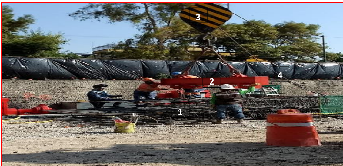
Figura 102. Maniobras para el izaje del armado de muro Milán; proyecto "MARNHOS, Lago Filt 7". (CIMESA 2018).
