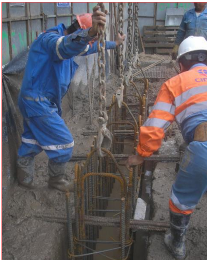
Figura 116. Posición final del armado de muro Milán dentro de la lumbrera; Autor: Ing. Francisco Israel Callejas Quezada. (CIMESA 2011).
