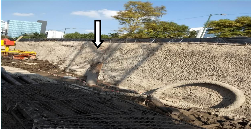
Figura 58. Inclinómetro capaz de monitorear el desplazamiento del muro Milán; proyecto "MARHNOS, Lago Filt 7". (CIMESA 2018).
