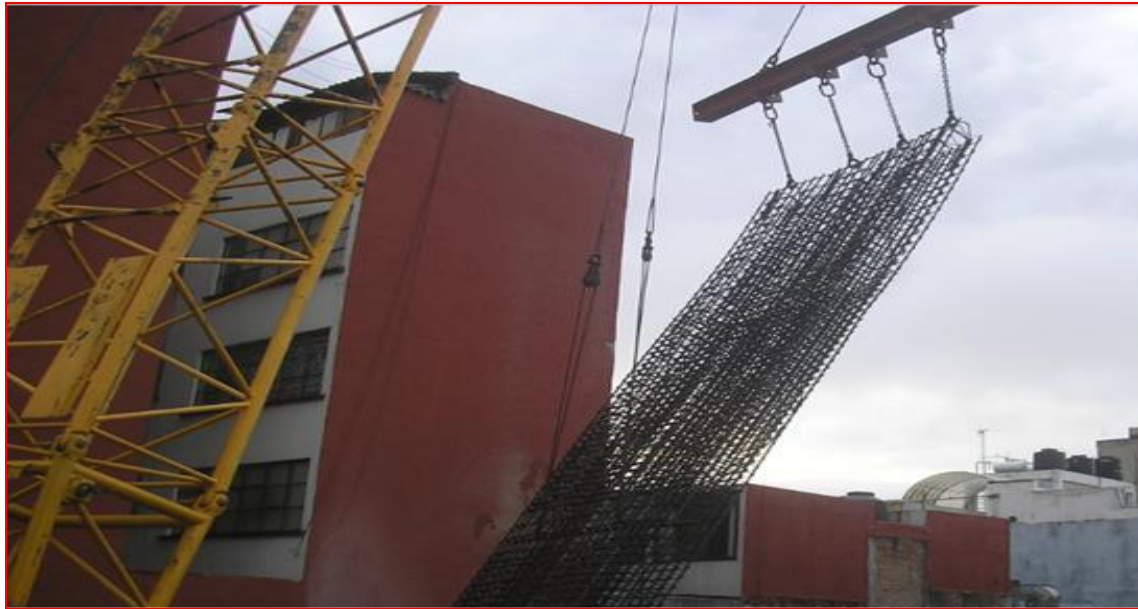
Figura 107. Izaje del armado de muro Milán; Autor: Ing. Francisco Israel Callejas Quezada. (CIMESA 2011).
