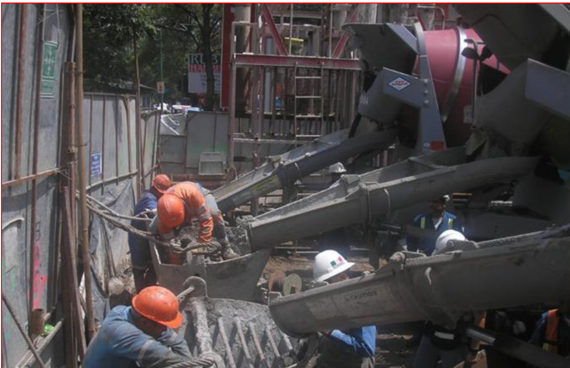
Figura 121. Ejecución programada de colado de muro Milán; Autor: Ing. Francisco Israel Callejas Quezada. (CIMESA 2011).
