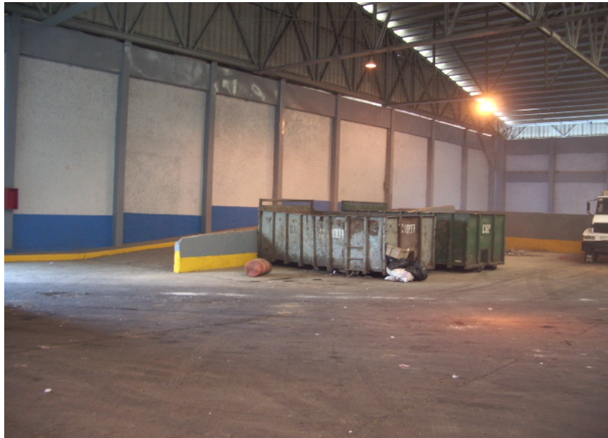
Figura 6.8 Contenedor para desechos de la construcción
