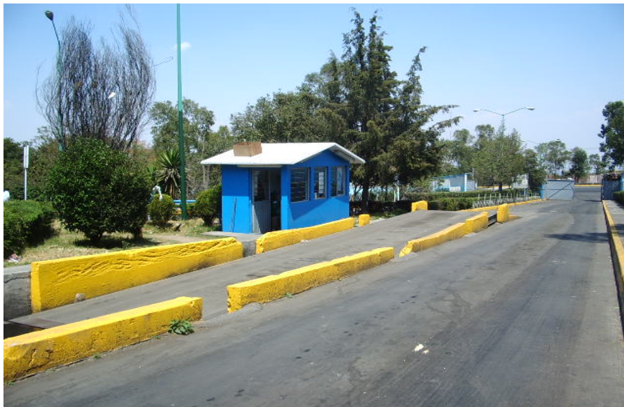
Figura 6.2 Rampa de salida de camiones recolectores
