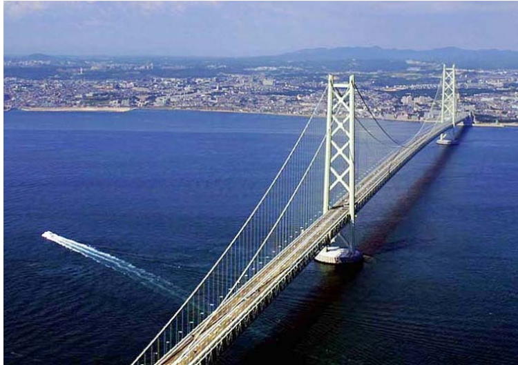
Fig 1.12 Foto del puente Akashi Kaikyo, Kobe, Japón
