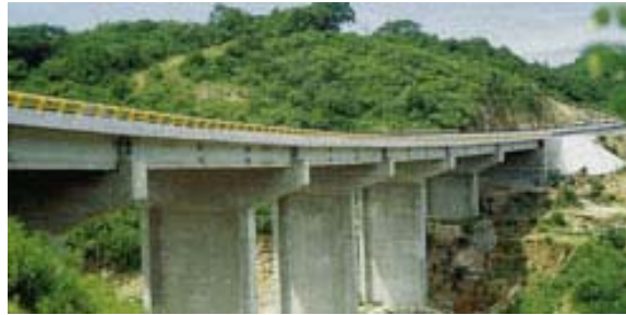
Fig 1.4 Foto del puente El Ejido, autopista México – Acapulco
