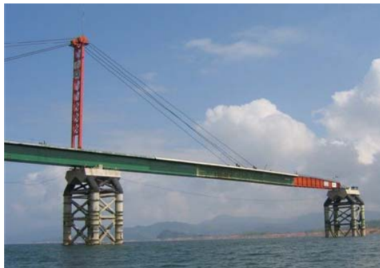
Fig 1.5 Foto del puente Chiapas, carretera Las Choapas-Ocozocoautla, Chiapas
