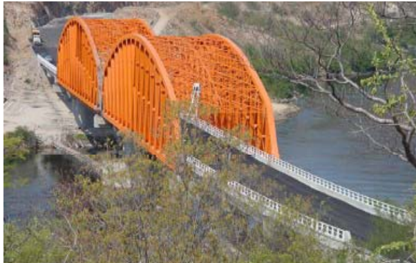
Fig 1.6 Foto del puente Infiernillo, Morelia – Lázaro Cárdenas, Michoacán
