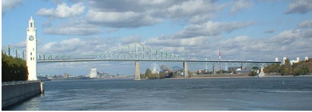
Fig 1.10 Foto del puente Jacques Cartier, Montreal, Québec, Canadá
