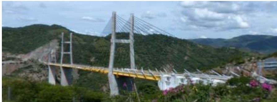
Fig 1.11 Foto del puente Mezcala Solidaridad I, autopista México - Acapulco
