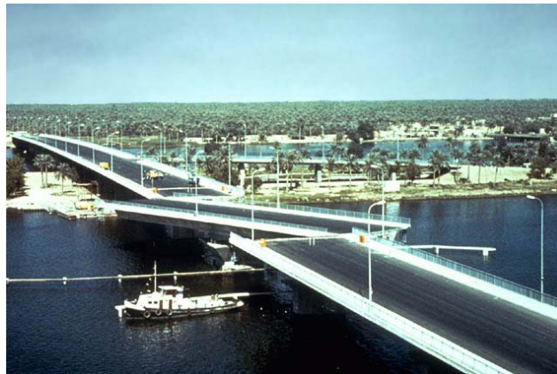
Fig 1.15 Foto del puente sobre el shatt-al-arab, en Basrah, Irak
