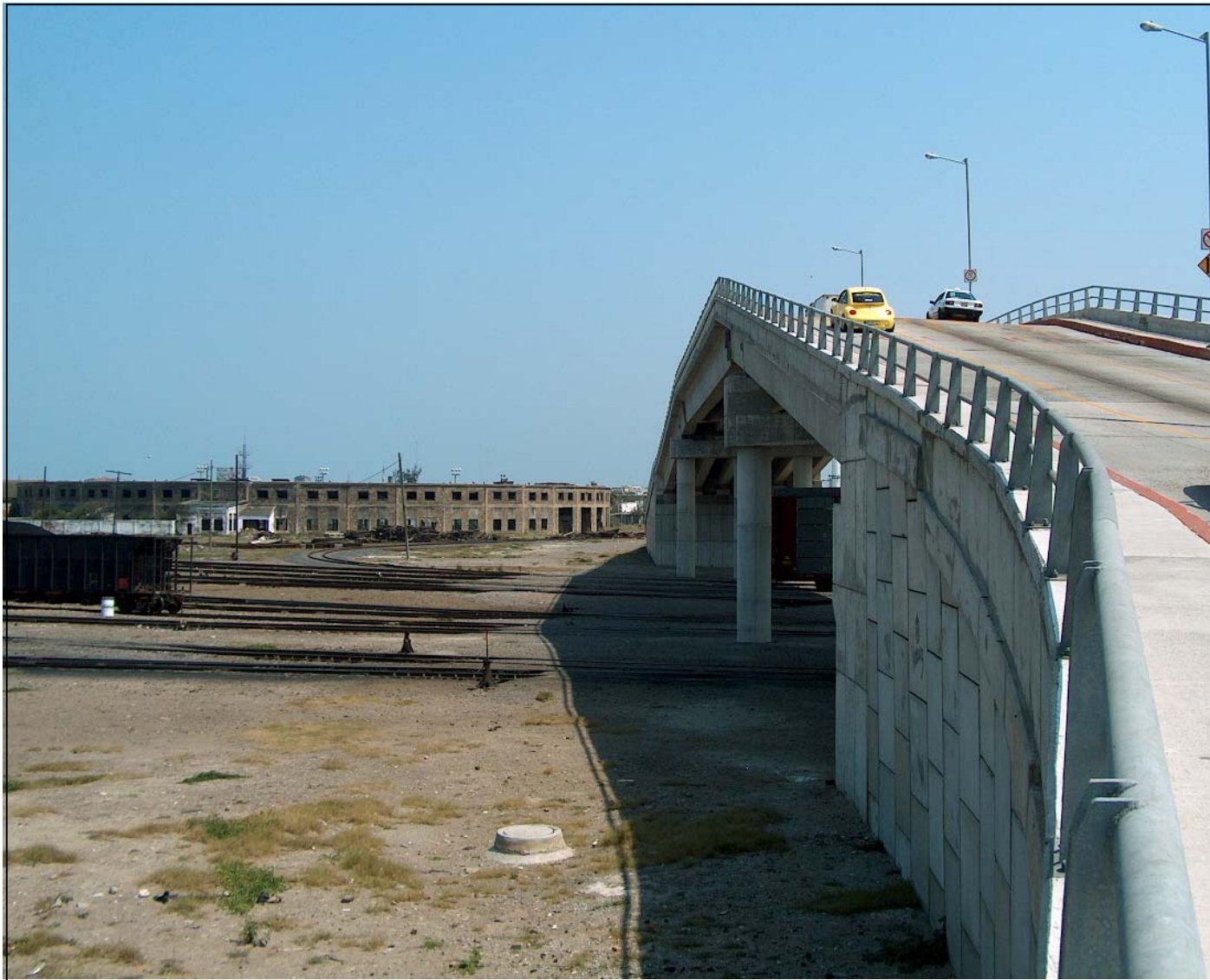
Figura 2.6 Fotografía del puente
