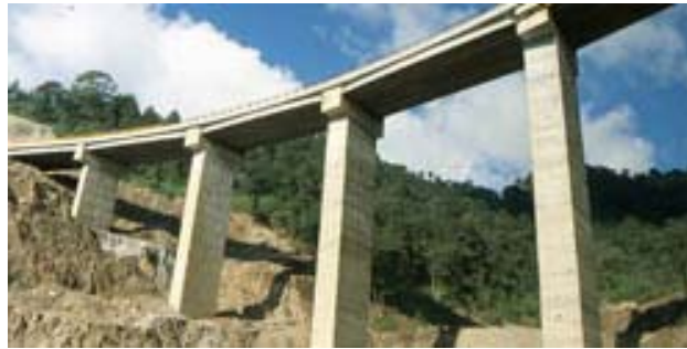
Fig 1.2 Foto del puente Maltrata, carretera Córdoba - Veracruz
