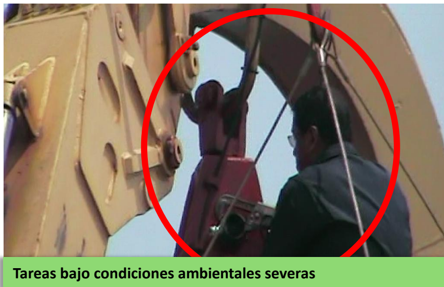
Fotografía 5: Operario expuesto a severas condiciones ambientales mientras lleva a cabo tareas de mantenimiento
