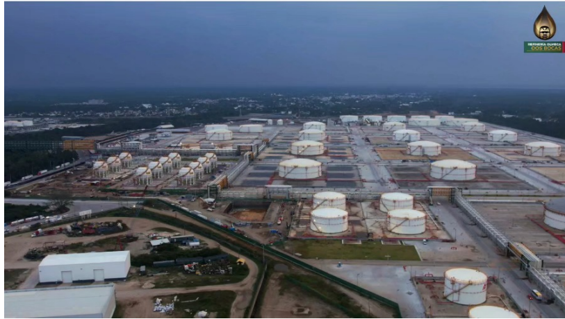
Figura 1.2: Tanques de almacenamiento en Refinería de Dos Bocas. Fuente: Tomado de Refinería Olmeca-Dos Bocas (2024).
