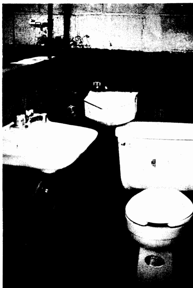
Fig 3.3.1 Sistema de reuso de agua jabonosa en desague de inodoro
