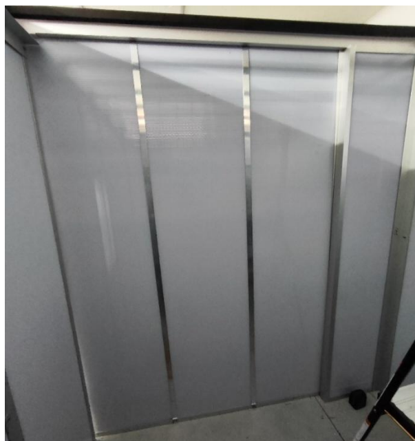
Ilustración 57. Puerta instalada (vista interna).
