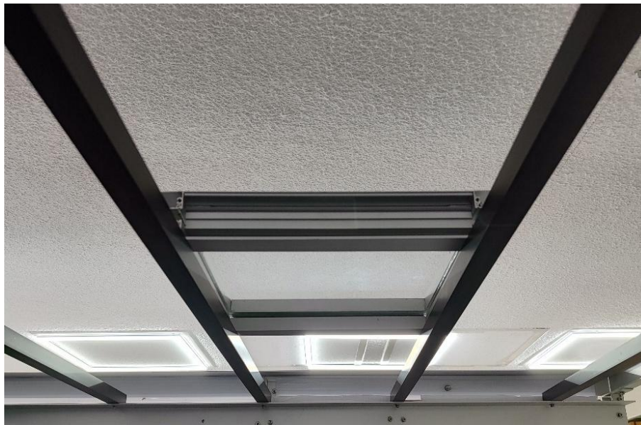
Ilustración 26. Ventana superior instalada.
