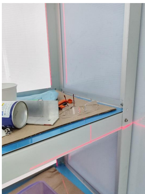
Ilustración 52. Comprobación de la rectitud de la estructura con nivelador laser 3.
