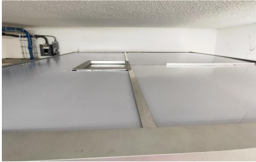
Ilustración 59. Techo recubierto (vista exterior).
