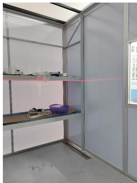
Ilustración 51. Comprobación de la rectitud de la estructura con nivelador laser 2.
