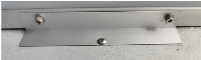
Ilustración 20. Fijación de la Cámara Ambiental al suelo.
