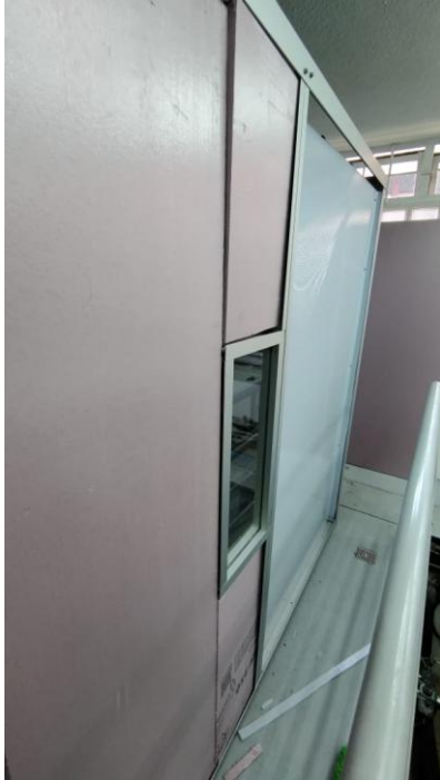
Ilustración 42. Vista exterior. Pared derecha (sin terminar).
