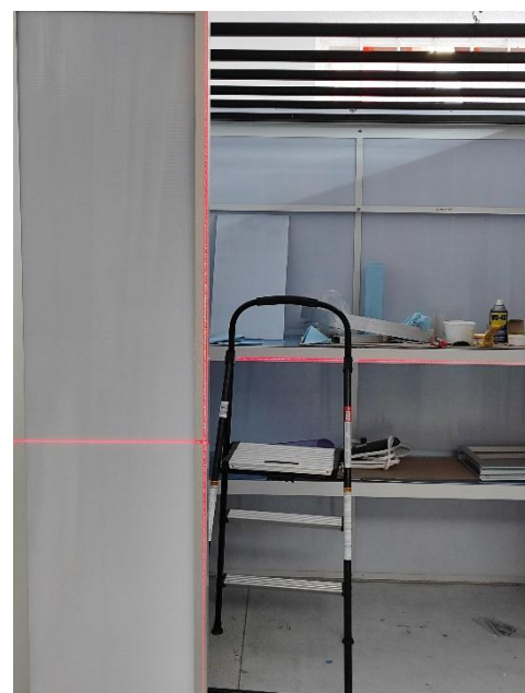
Ilustración 53. Comprobación de la rectitud de la estructura con nivelador laser 4.
