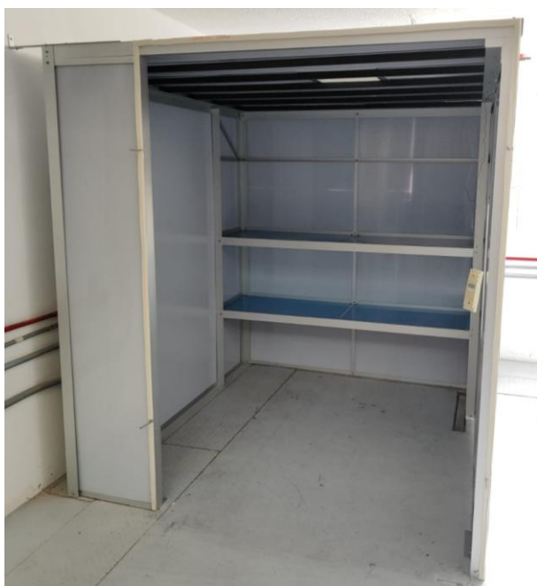
Ilustración 61. Estructura construida (vista al interior).
