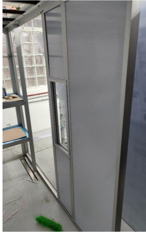
Ilustración 41. Vista interior. Pared derecha
