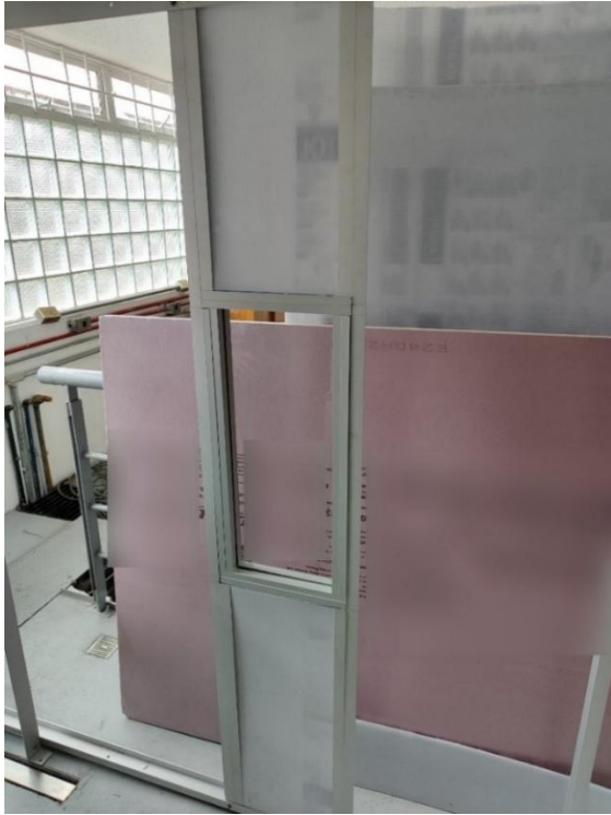
Ilustración 40. Recubrimientos por debajo y encima de ventana.
