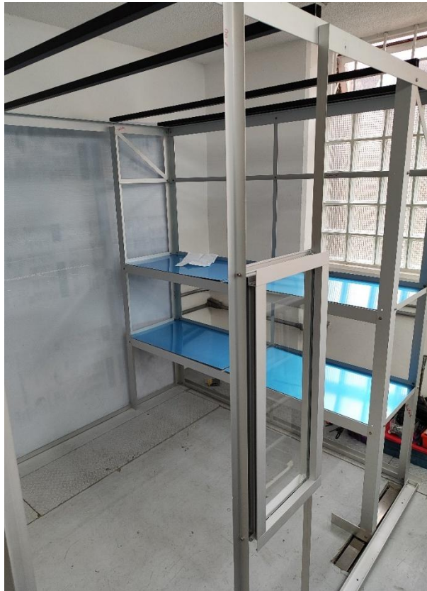
Ilustración 23. Instalación de ventana lateral.
