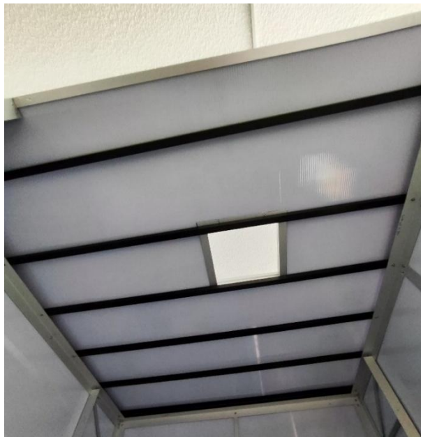
Ilustración 60. Techo recubierto (vista interior).
