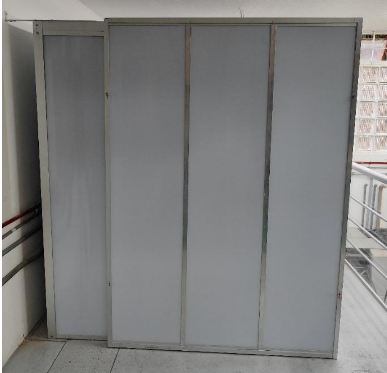
Ilustración 58. Puerta instalada (vista externa).
