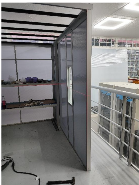
Ilustración 50. Comprobación de la rectitud de la estructura con nivelador laser 1.
