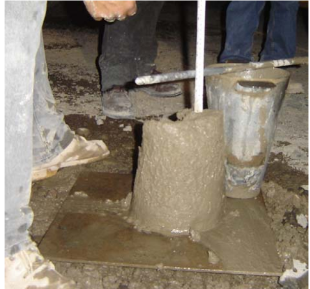
Figura 6. Prueba de revenimiento
