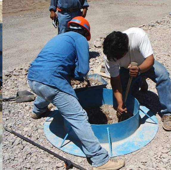
Figura 4. Excavación de la cala
