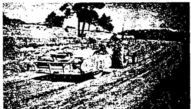
Fig. 6-16 Compactador vibratorio jalado por tractor.
