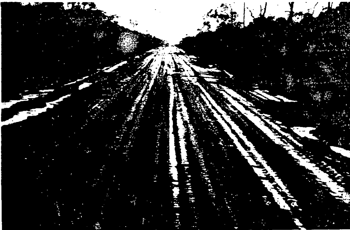
Fig. 8-6 Fotografía que muestra los estragos del agua de lluvia a un terraplén construido con arena de playa y a pesar de tener una protección superficial de arena estabilizada con asfalto.
