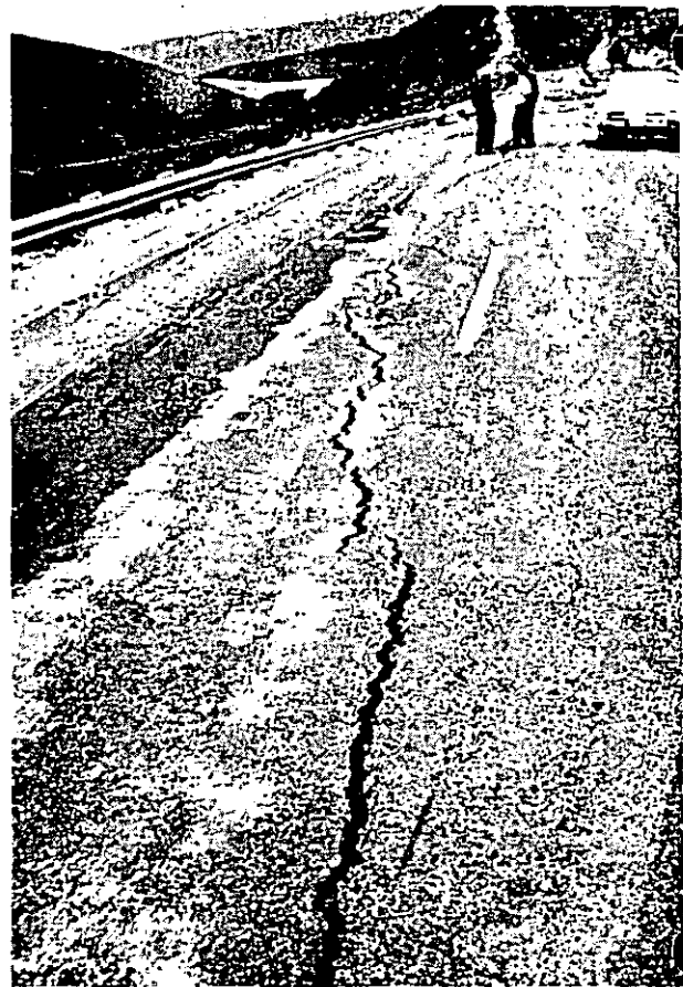
Grietas longitudinales en un terraplén. (Carretera Apasco-Irapuato.)
