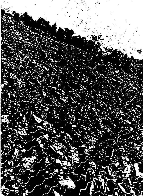
Distintas obras de protección. Nótese el uso de estructuras de retención y de mallas para retener los caídos.
