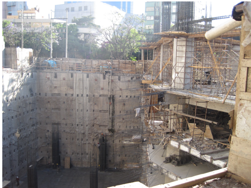
Toma realizada hacia la calle José María Velasco donde se aprecia una sección hasta el nivel Cero (calle) y otra al nivel Sótano -4
