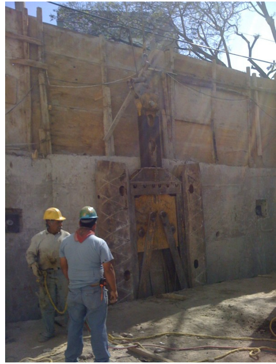
Perforación con la grúa almeja
