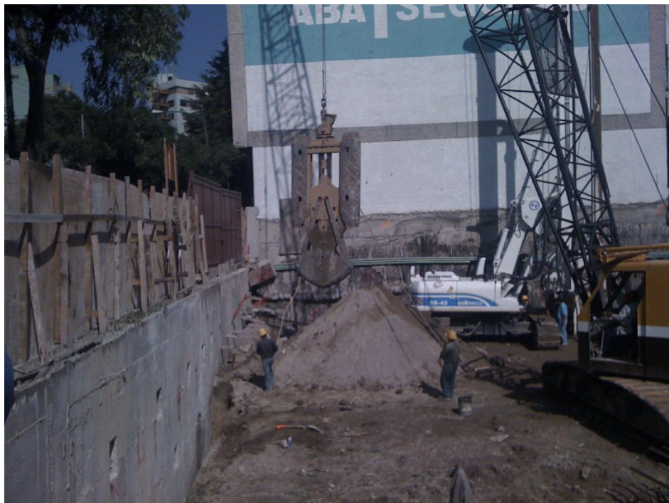
Perforación para Muro Milán con grúa almeja
