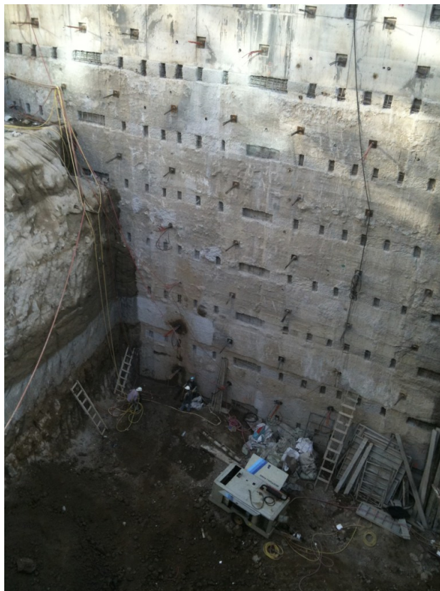
Vista General del Muro Milán con anclas durante el proceso de excavación
