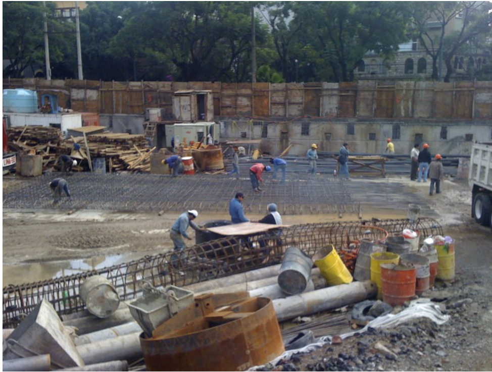
Habilitación de acero para pilas de cimentación
