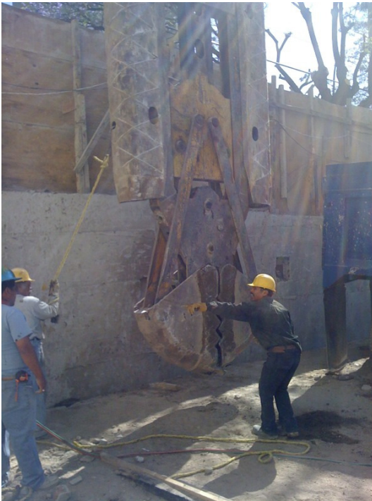
Perforación con la grúa almeja
