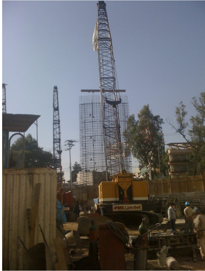
Colocación de Parrilla
