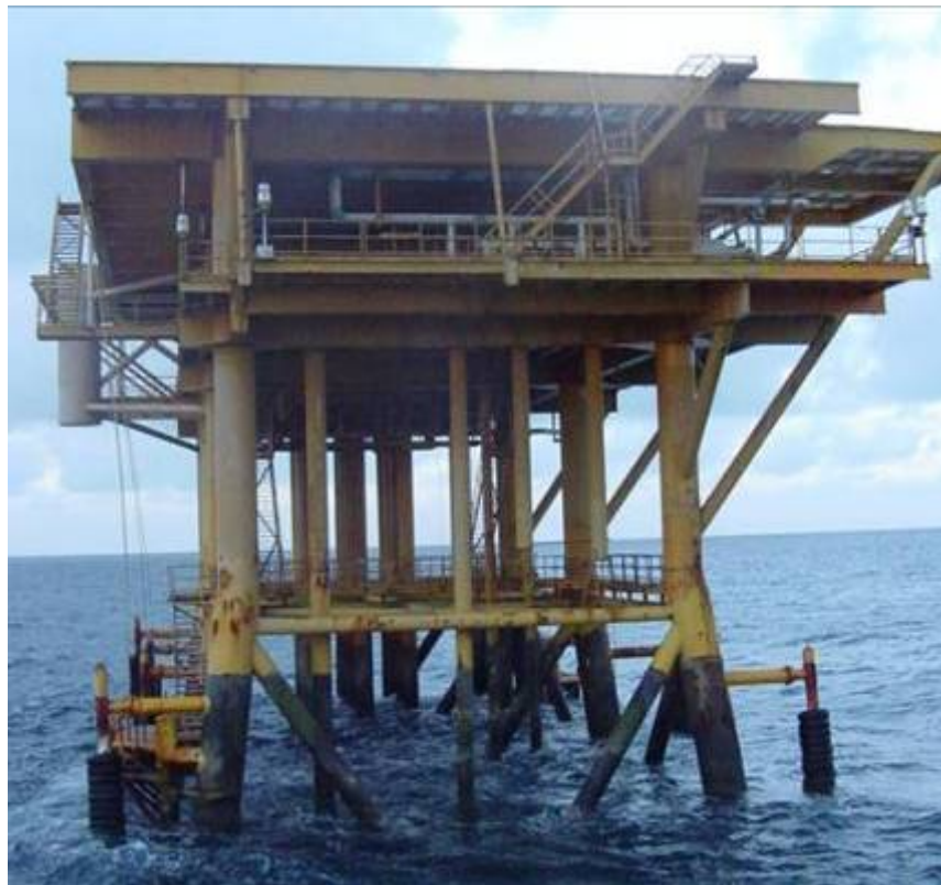
FIGURA 2.13 ABKATUN-I SUPERSTRUCTURA EJE 4
