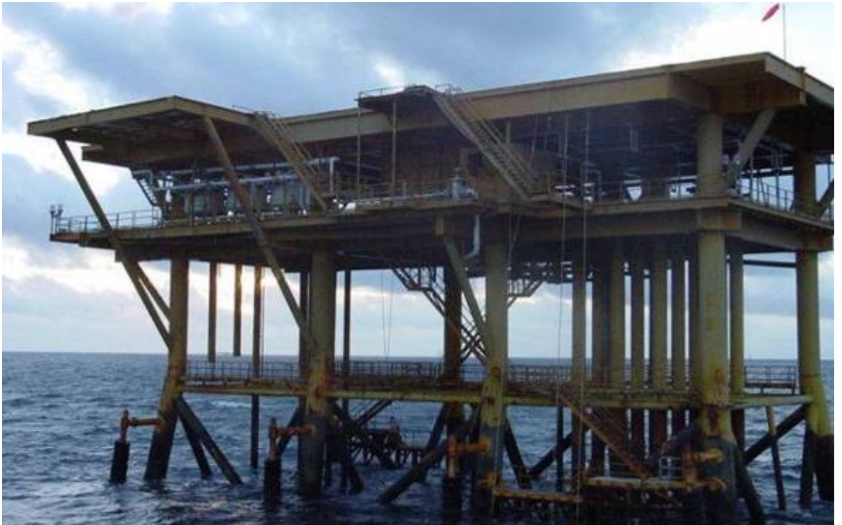
FIGURA 2.11 ABKATUN-I SUPERESTRUCTURA EJE B
