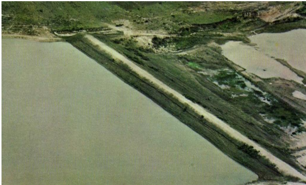
Figura 4.5 c) Vista de la presa La Mina Oaxaca, Referencia CFE
