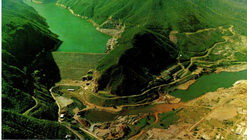
Figura 4.5 d) Vista de la Presa Infiernillo, con cortina de materiales graduados
