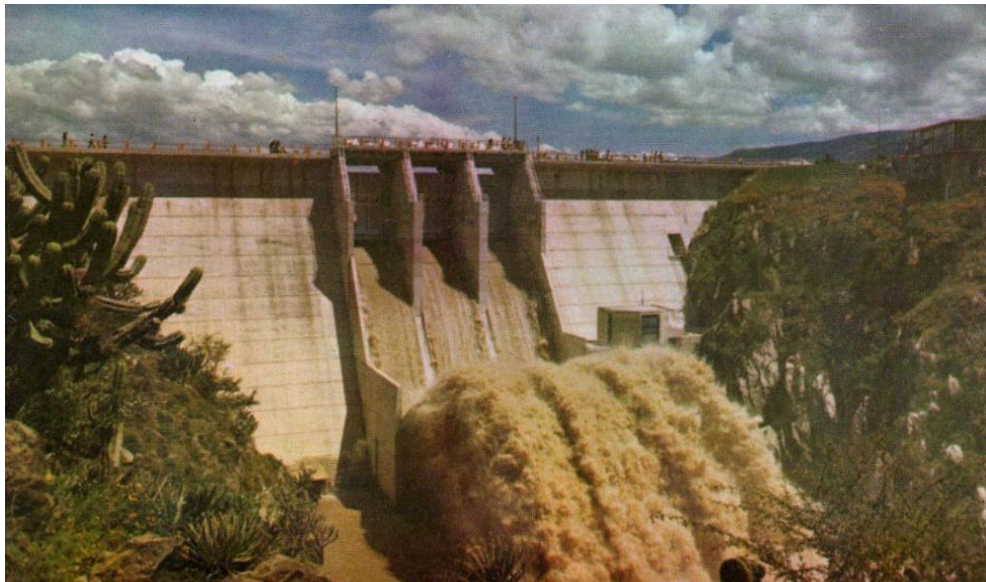
Figura 4.4 a) Cortina de concreto masivo, Ignacio Allende, Referencia CFE
