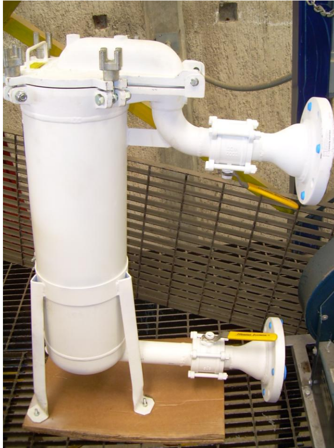
Figura 2-9: Vista lateral del filtro (elaboración propia).
