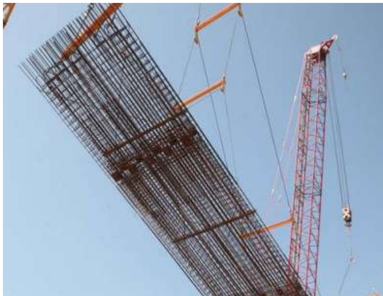
Figura IV. XIX Izaje de Acero de refuerzo para Muro Milán
