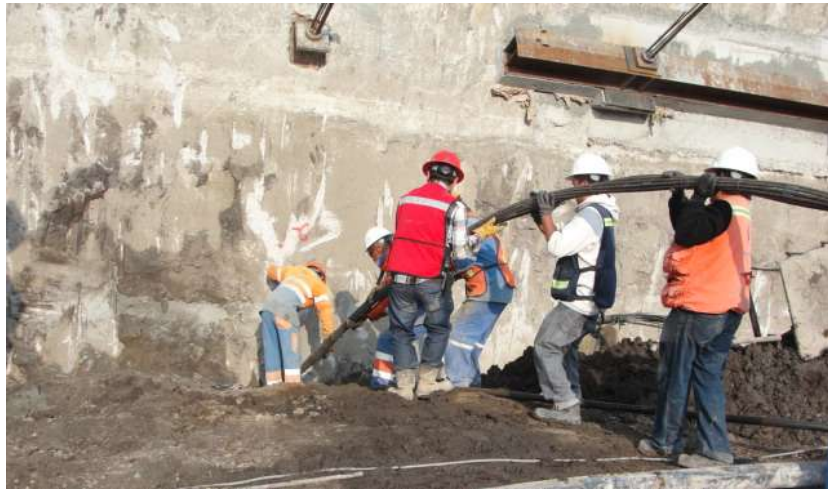
Figura IV. VIII Colocación manual de un ancla
