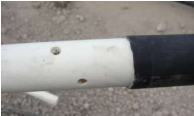
Figura IV. IV Perforación de la conducción de PVC a punto de ser recubierta por un manguito
