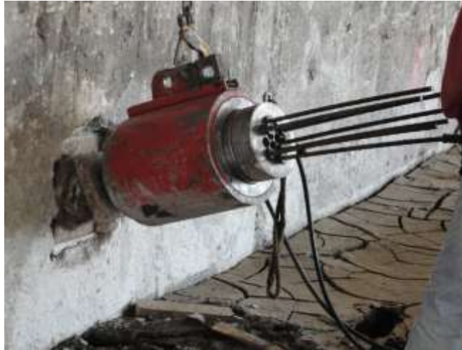
Figura IV. XII Montaje Final del gato hidráulico, el queso de arrastre colocado al último
