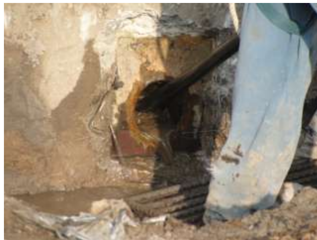
Figura IV. VII Inyección de la primera lechada de cemento para estabilizar el barreno
