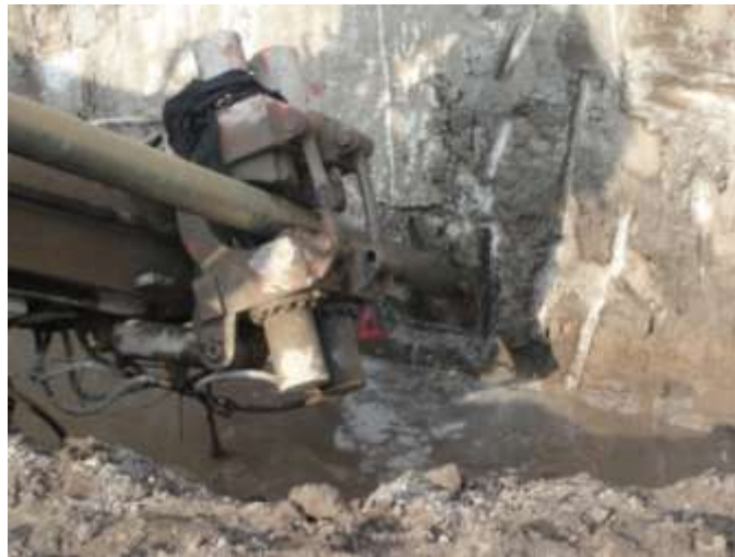
Figura IV. VI Inicio de un barreno para un ancla en el 2do nivel
