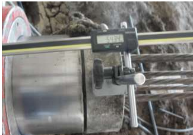
Figura IV. XIII Inicio del tensado del ancla, y arranque de la prueba simultánea de tensado para conocer las diferentes deformaciones a las diferentes cargas aplicadas, la deformación por ciclo de carga no debe exceder a 1 mm
