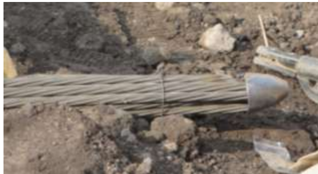
Figura IV. IX Punta de bala de un ancla para facilitar su colocación
