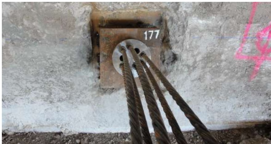
Figura IV. XIV Vista Final del tensado de un ancla: silleta, queso de bloqueo y cuñas de bloqueo tensando el ancla por medio de los torones.
