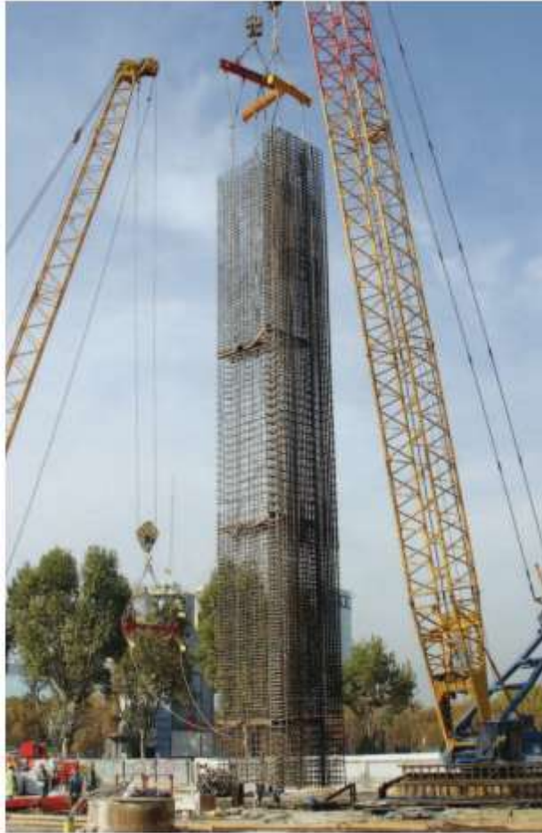
Figura V. XII Izaje de las parrillas de acero de refuerzo para Muro Milán
