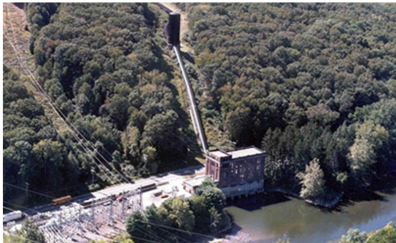
Imagen 2 Central de Bombeo Rocky River
