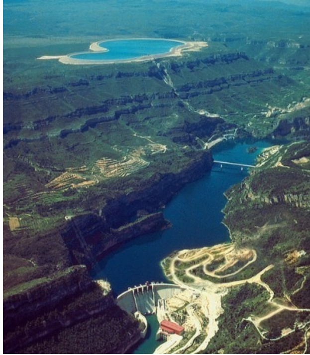
Imagen 6 Central Hidroeléctrica Reversible Cortes-La Muela, España
