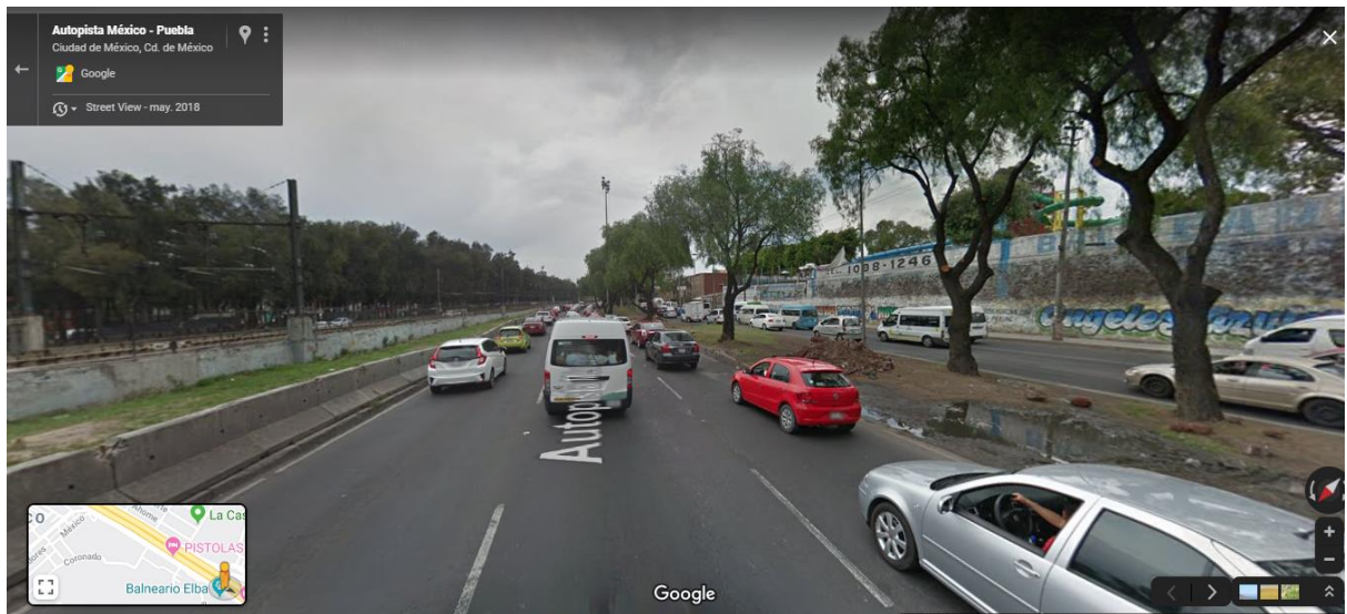
Figura 55. Disponibilidad de la vía para mantener 4 carriles en toda la sección (Google Maps, 2019).
