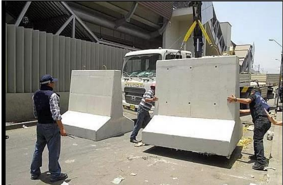
Figura 59. Barrera New Jersey de gran altura
