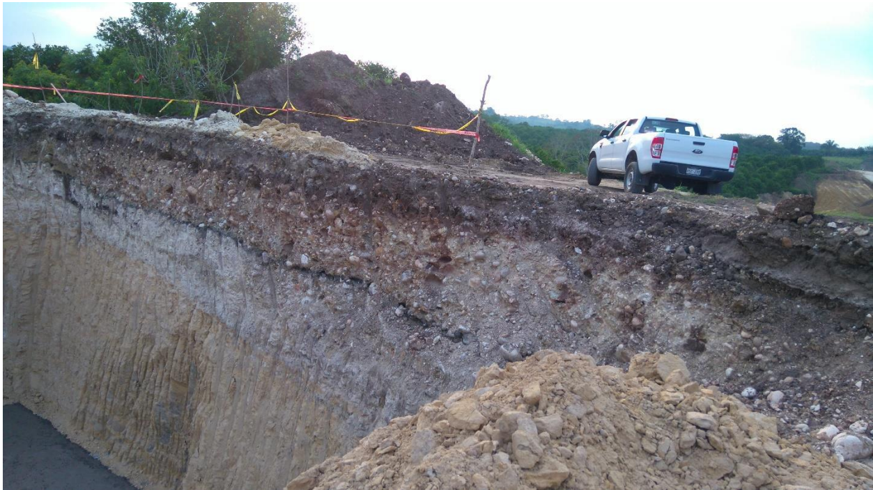
Fig. 4.2. Corte carretero en el que se muestra una sucesión de areniscas, lutitas y conglomerados, característicos de la formación Tuxpan.
