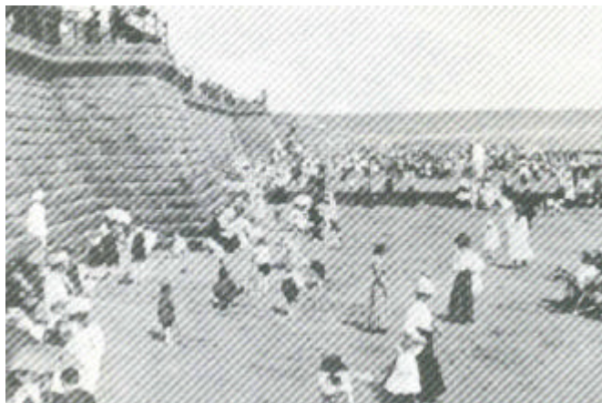
Figura 2.7 Vista de la de un Dique Marino, que se encuentra en Bridlington Inglaterra, la fotografía data del año 1900. Se aprecia que este dique se construyó a partir de bloques de concreto.
