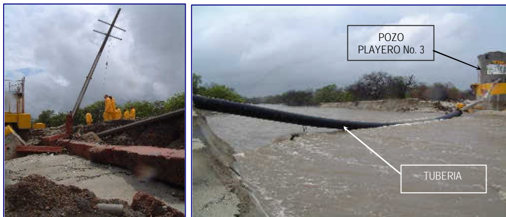
Figura 5.1 Vista de los daños ocasionados a la infraestructura y líneas eléctricas en la zona de la Bahía de la Ventosa Salina Cruz, Oaxaca.
