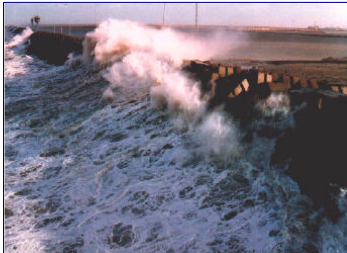
Figura 4.18 Figura que muestra el rebase de una ola sobre una estructura (Ola Overtopping ).
