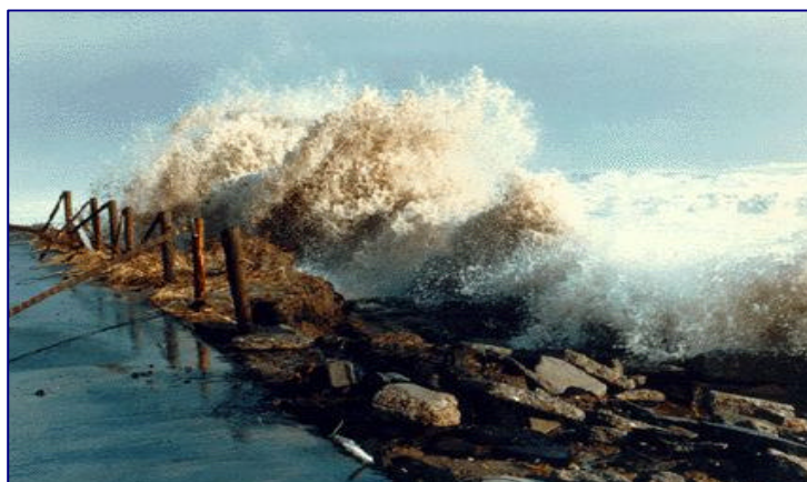
Figura 4.13 Vista del momento en el que un oleaje extremal se impacta sobre una estructura de protección.
