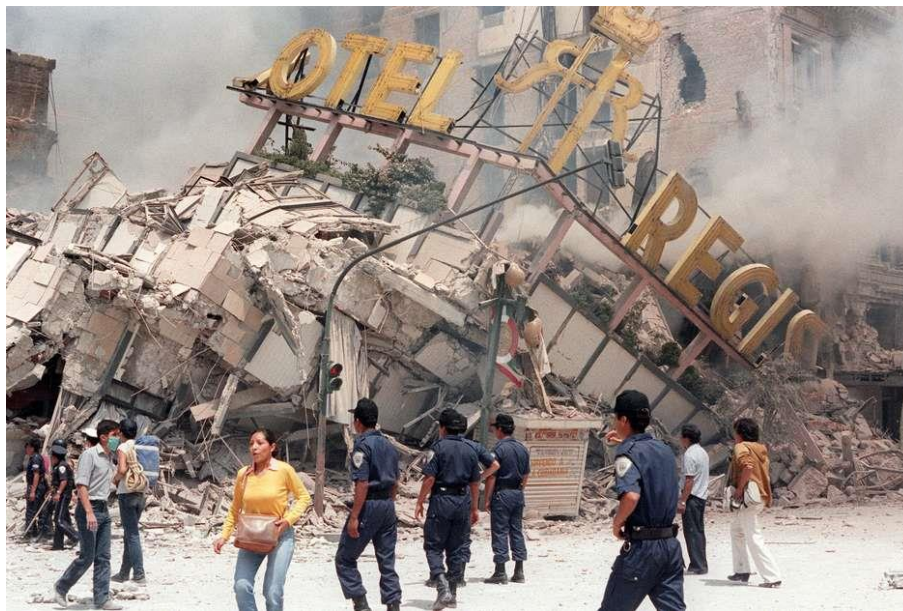
Figura 1.2 Daños ocasionados por el sismo de 1985 en el Hotel Regis (hoy Plaza de la Solidaridad)
