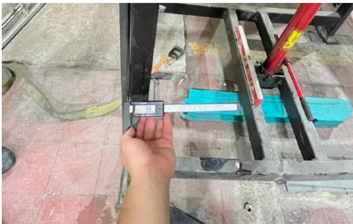
Fig. 27. Medición empírica de la deformación por abolladura y el desplazamiento resultante en la estructura física del bastidor.
