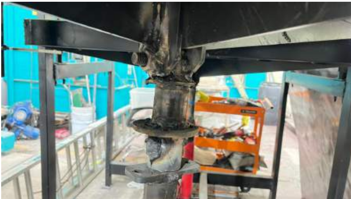
Fig. 8. Instalación del mecanismo de potencia mediante la fijación directa por soldadura del gato hidráulico a la base estructural inferior.
