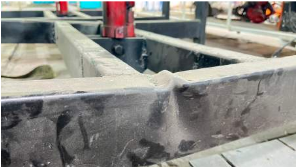
Fig. 30. Evidencia de deformación local.
