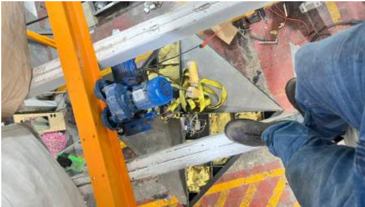
Fig. 12. Ensamble general y acoplamiento de las bases mediante grúa industrial en la prensa térmica.
