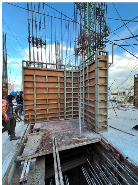
Imagen 18. Montaje del muro core en Torre Tauri.
