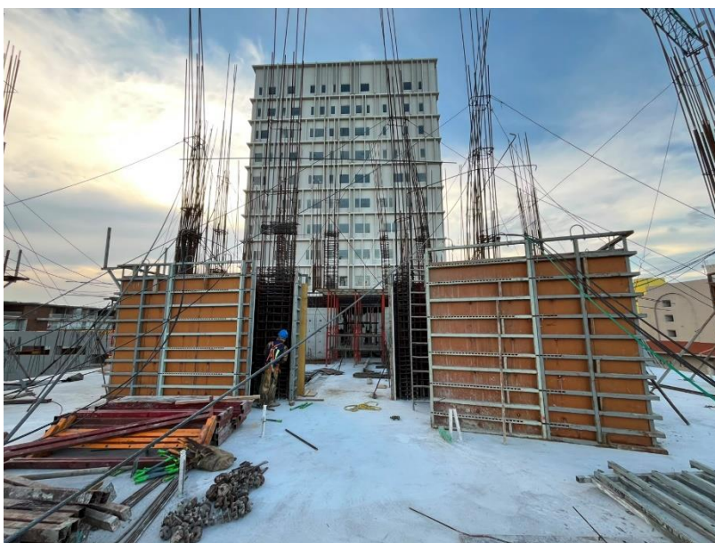
Imagen 17. Montaje del muro core completo en Torre Tauri.
