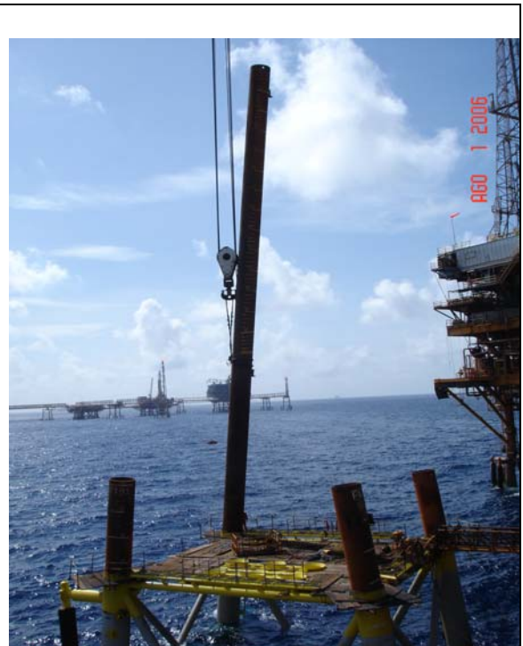
Figura V.4.3 Instalación de la primera sección
