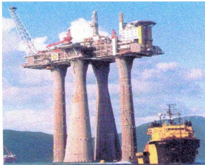
Figura I.3. Plataforma Troll A, con 430 metros de alto, y sólo 142 m de altura sobresalieron durante su traslado al sitio.
