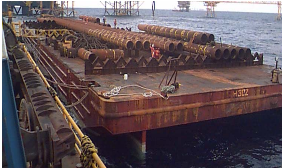
Figura V.3.3 Arreglo de pilotes en la barcaza de transportación.
