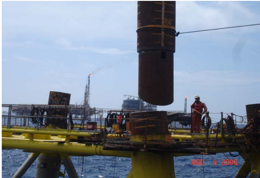
Figura V.4.10 Maniobras de acoplamiento entre secciones.
