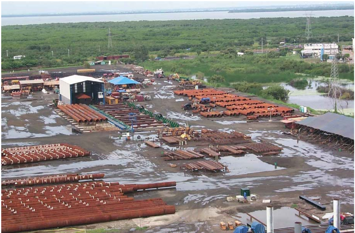
Figura V.7. Área de almacenamiento y construcción de pilotes y conductores.
