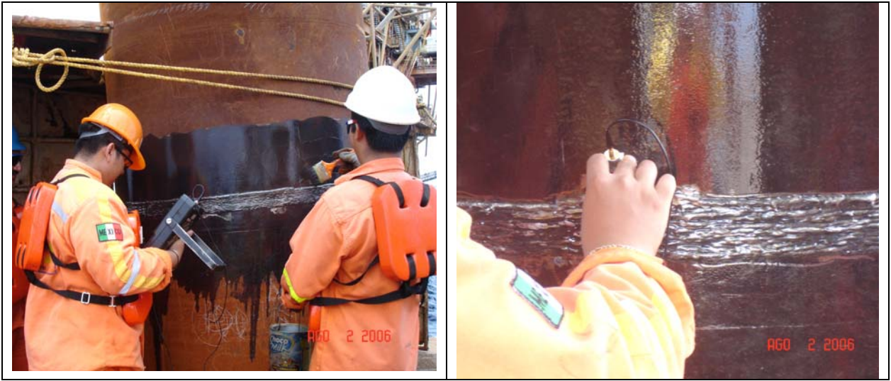
Figura V.4.13 Inspección de soldadura en campo con un palpador angular de 60°.
