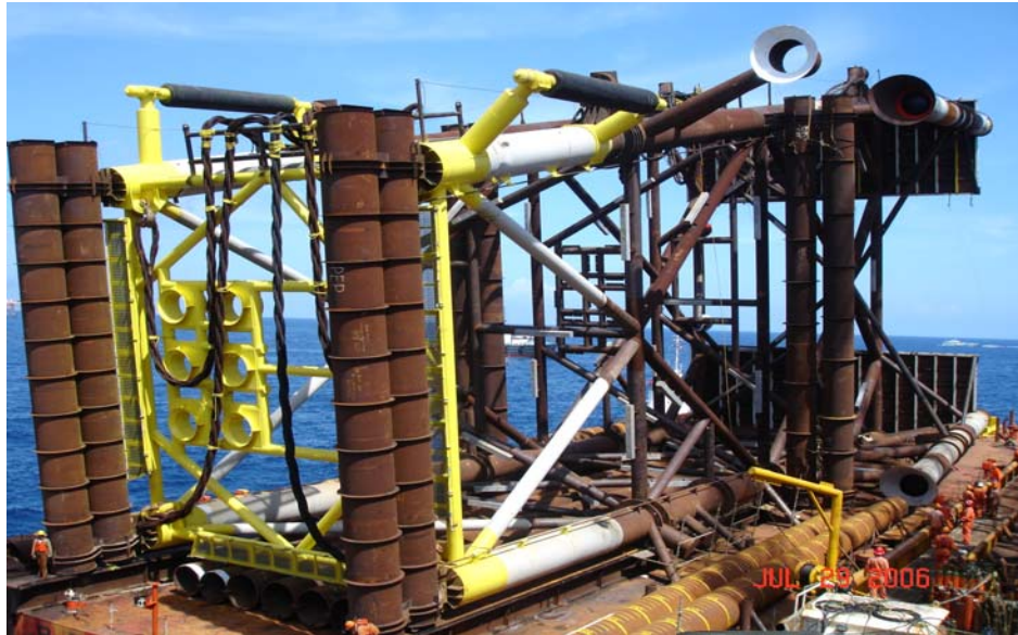
Figura V.3.4 Arreglo de pilotes en la barcaza de transportación junto con la subestructura.
