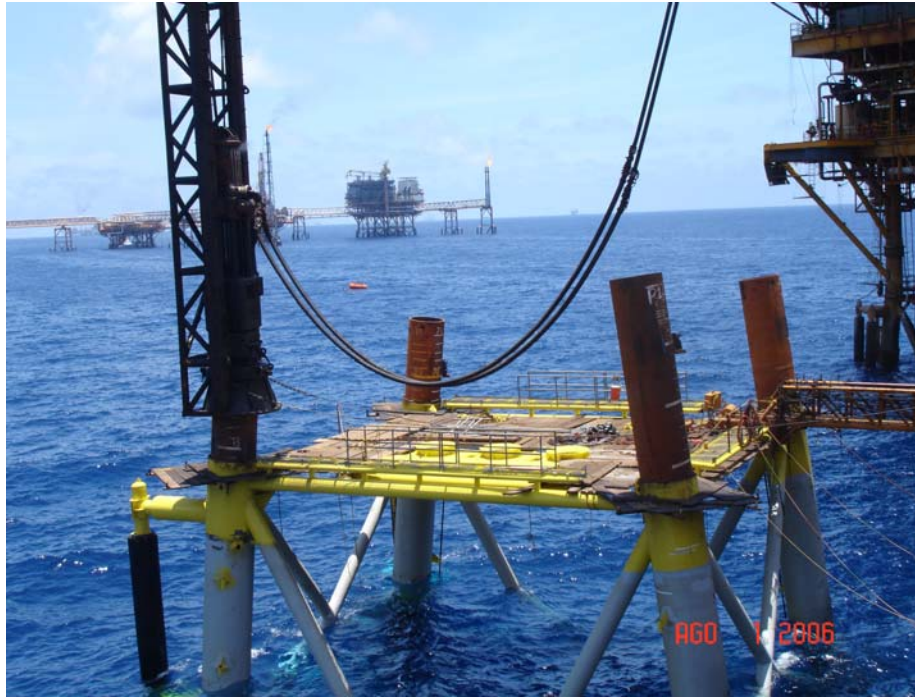
Figura V.4.4 Hincado de primeras secciones.
