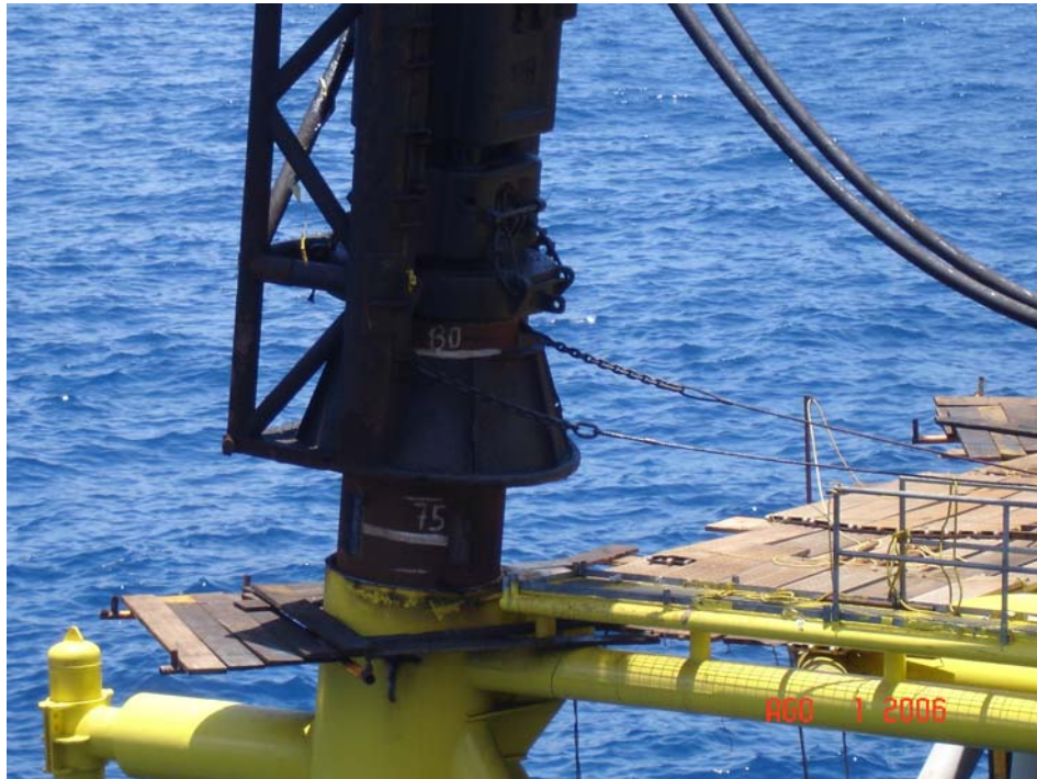
Figura V.4.5 Finaliza hincado de primeras secciones.
