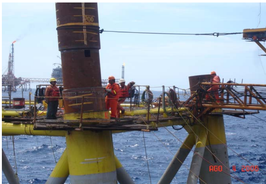
Figura V.4.11. Acoplamiento entre secciones.
