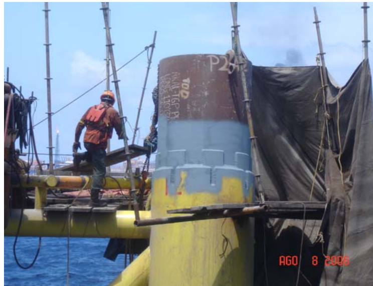
Figura V.4.17. Preparación de coronas en el pilote.
