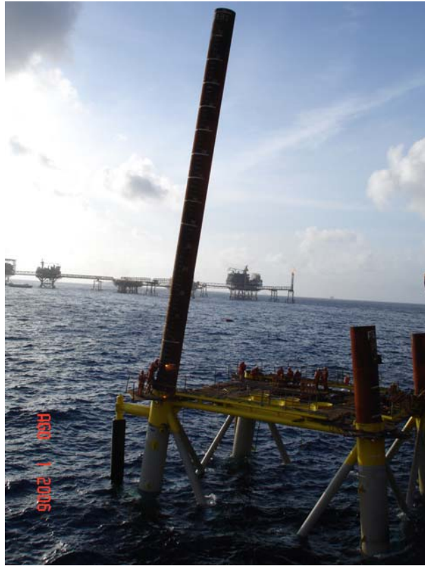
Figura V.4.12 Aplicación de soldadura entre secciones.
