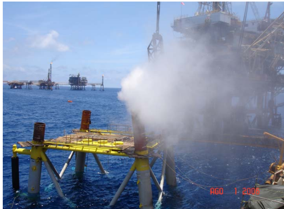
Figura V.4.4 Acción del martillo de vapor sobre el pilote a hincar.
