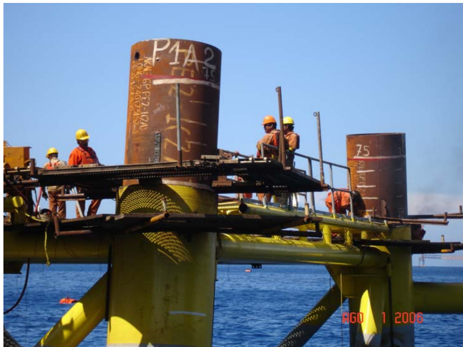
Figura V.4.6 Longitud optima (2-6 ft) para realizar corte de la primera sección de pilote y unión de soldadura del siguiente tramo
