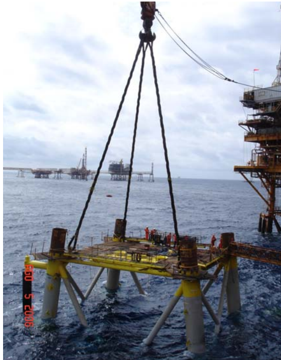
Figura V.4.16. Nivelación de la subestructura.
