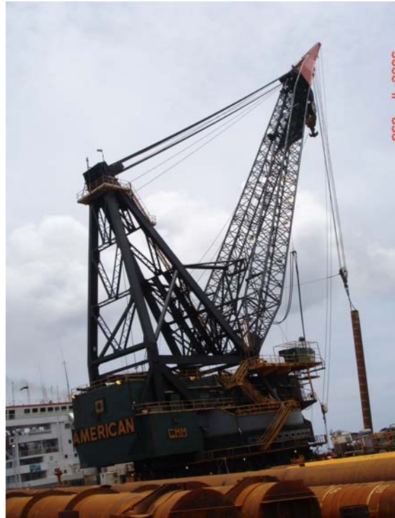
Figura V.3.8 Maniobras de izaje para segundas secciones.
