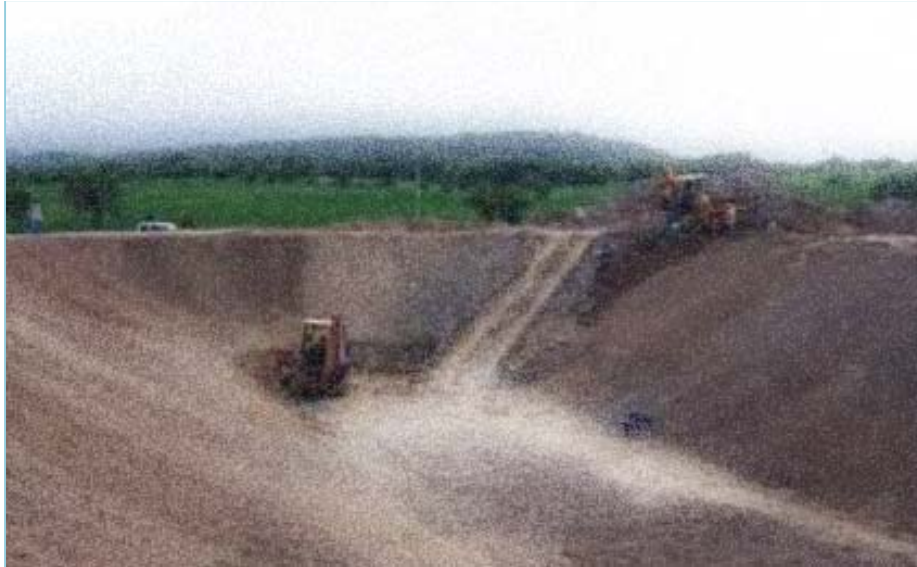
Figura 4.2 Fase de excavación
