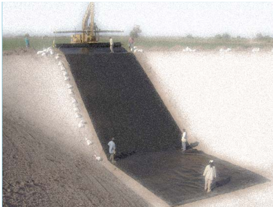
Figura 4.3 Colocación de la geomembrana
