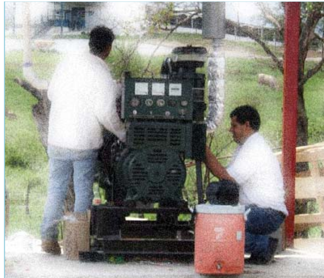
Figura 4.11 Instalación del equipo motogenerador
