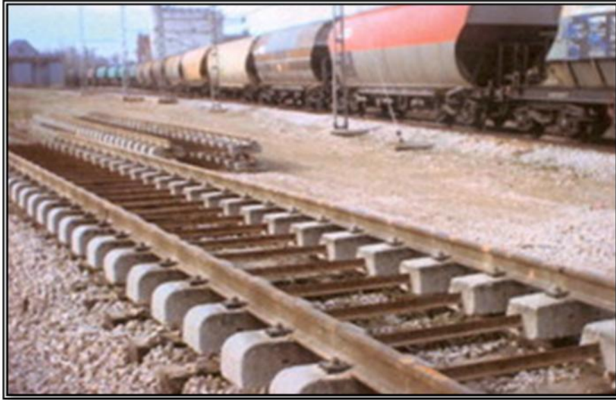
Figura N° 2. En la imagen se muestra la estructura de los durmientes bibloque.
