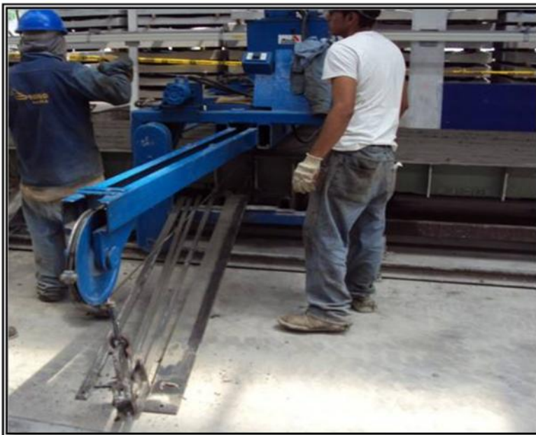
Figura N° 15. Retiro de placas.
