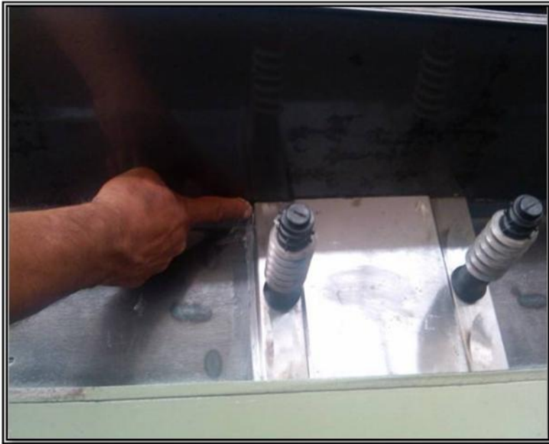
Figura N° 9. Aplicación de grasa en placas y pernos.
