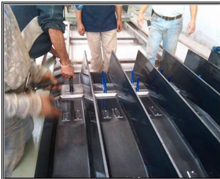
Figura N° 10. Aplicación de grasa en placas y pernos.
