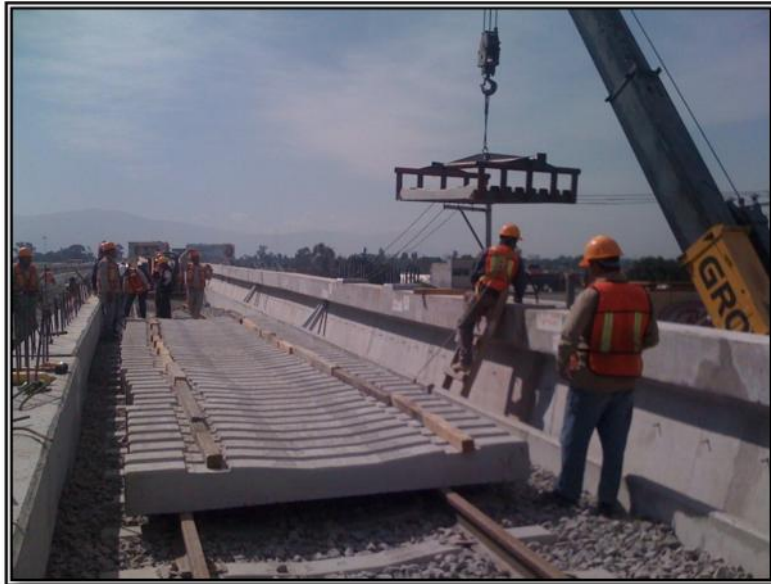
Figura N° 25. Izado de durmientes.
