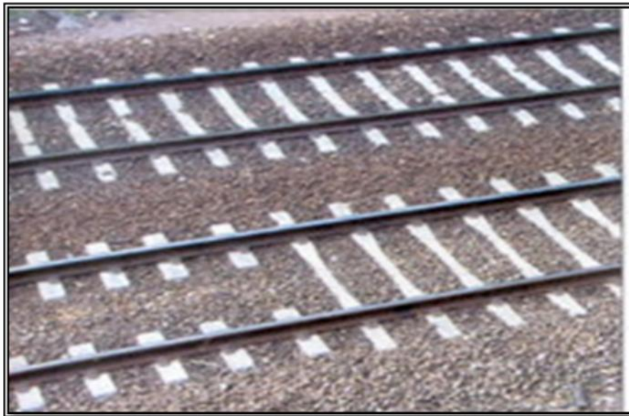
Figura N° 1. En esta foto se puede apreciar la diferencia entre los dos tipos de durmientes de concreto una vez instalados en esta figura se muestra el durmiente monobloque de concreto.
