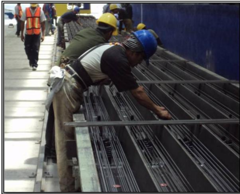
Figura N° 13. Verificación de nomenclaturas accesorios y alambre previamente colocados.
