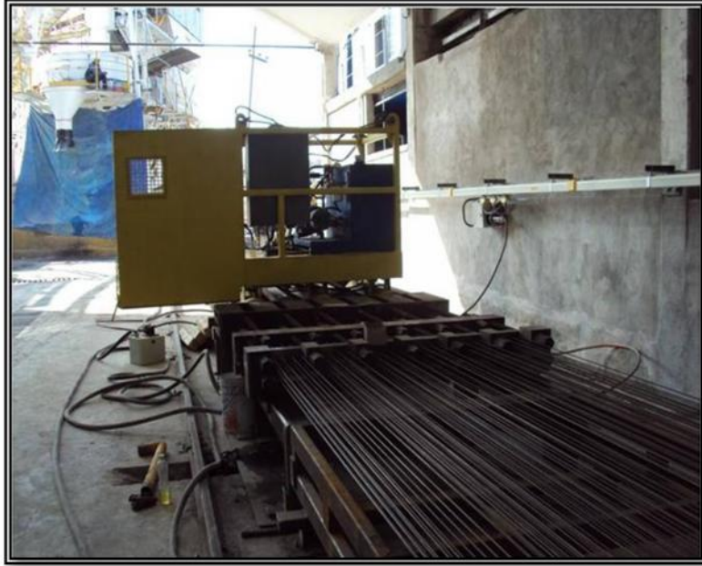
Figura N° 12. Colocación de alambre y tensado.
