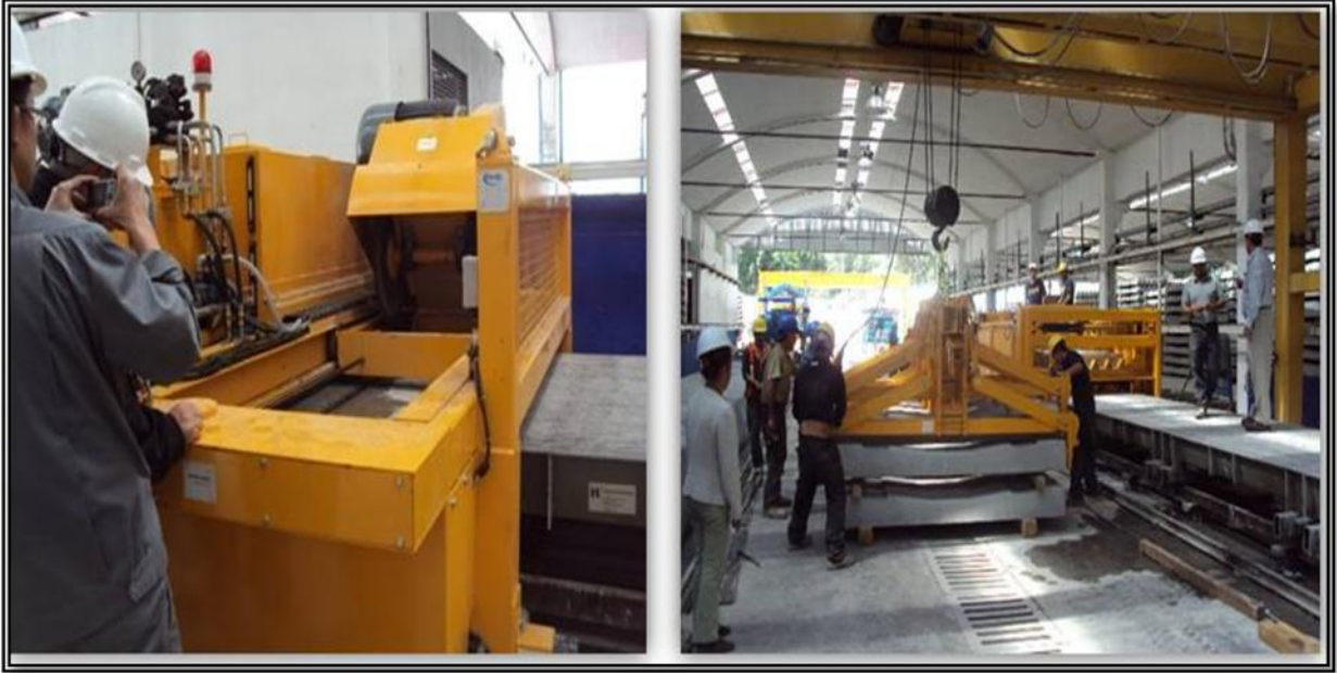
Figura N° 18. Liberación de presfuerzo, desmoldeo y retiro de durmientes.
