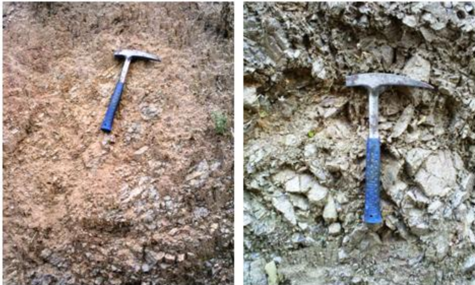
Fotografía 10. Granito rosado con fuerte grado de intemperismo mecánico ubicado en la calle San Fernando, Barrio 12 de octubre (corte inducido por la construcción de una vivienda).
