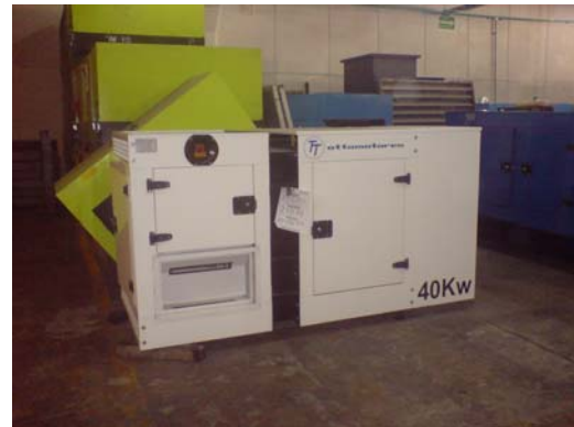
FIG 2. Caseta Acústica planta 40 kW.
