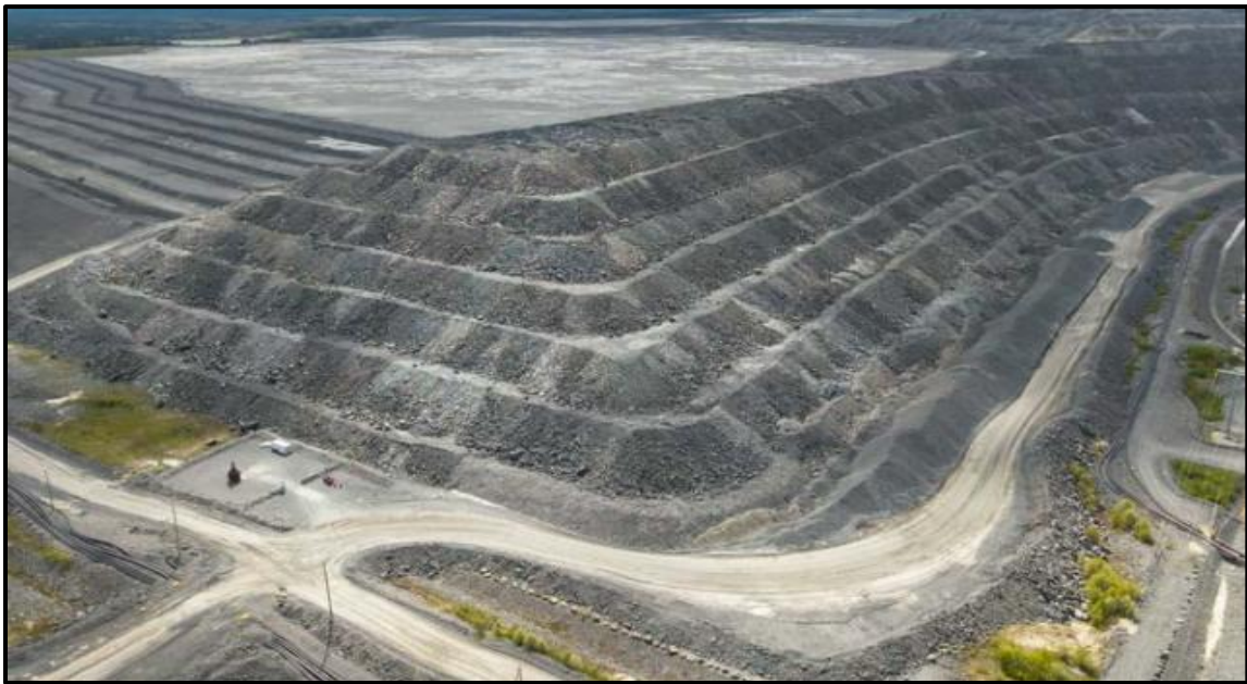
Figura 4. 8. Depósito de jales espesados en Canadian Malartic. Fuente: Responsible Tailings Management (Agnico Eagle, 2025) .
