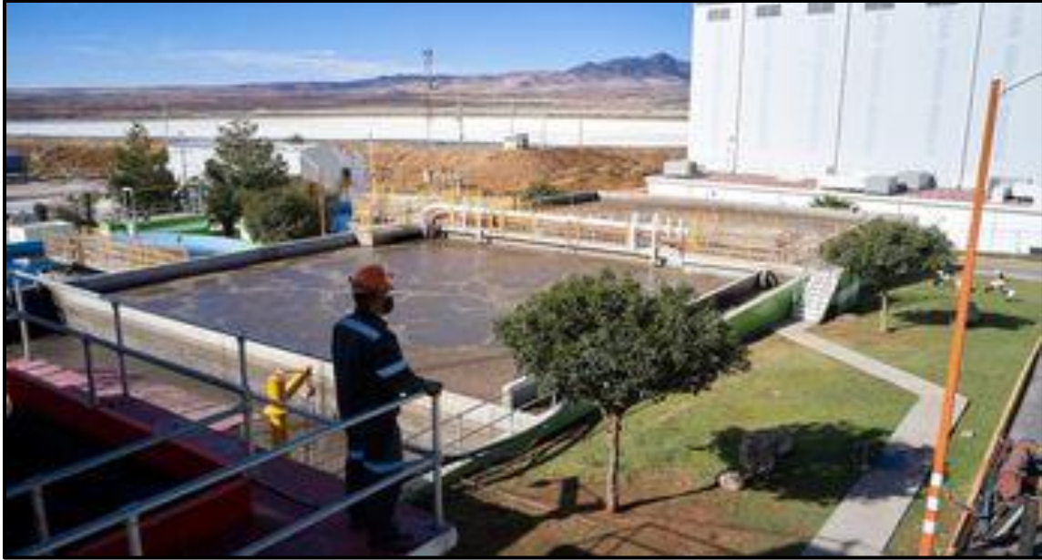
Figura 4. 28. Planta de tratamiento de aguas residuales de Met-Mex Peñoles. Fuente: Peñoles, pionera en el tratamiento del agua residual (MILENIO, 2017).
