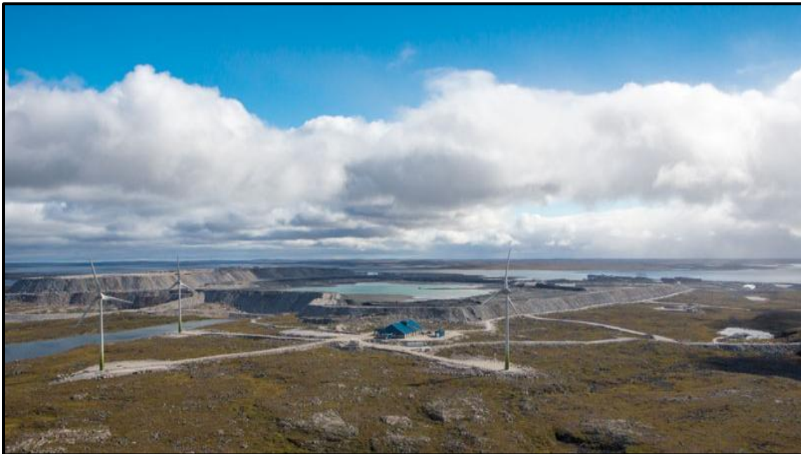
Figura 4. 47. Planta de energía híbrida eólica-diésel para suministro de la mina Diavik, Canadá. Fuente: Diavik Diamond (Natural Resources Canada, 2014).
