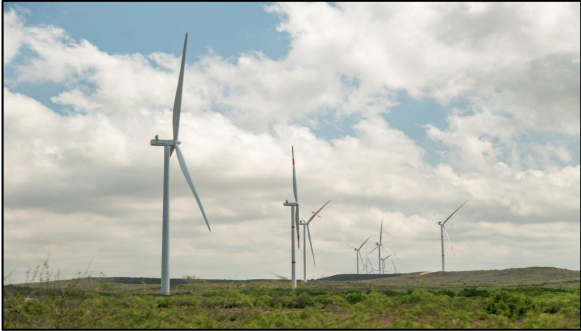
Figura 4. 51. Parque eólico Fenicias, que abastece la Refinería Electrolítica de Zinc en SLP. Fuente: Informe de sostenibilidad ( Grupo México, 2025 ).
