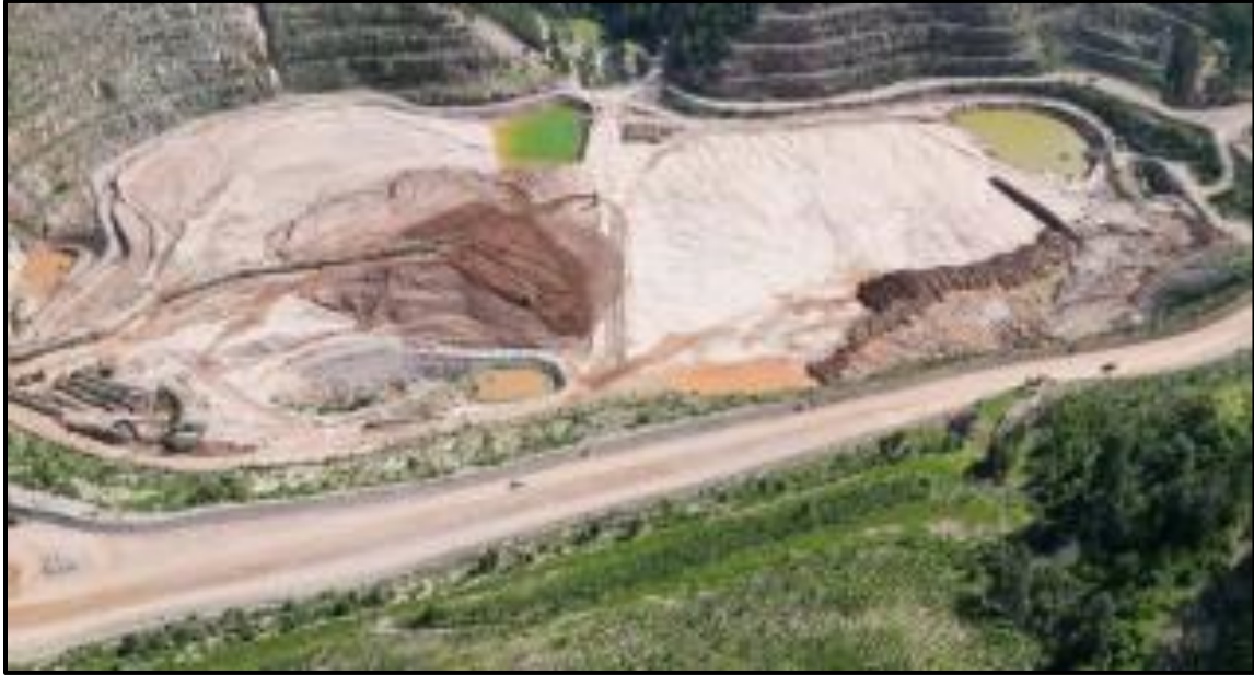
Figura 4. 6. Relleno de tajo unidad Pinos Altos. Fuente: Responsible Tailings Management (Agnico Eagle, 2025).
