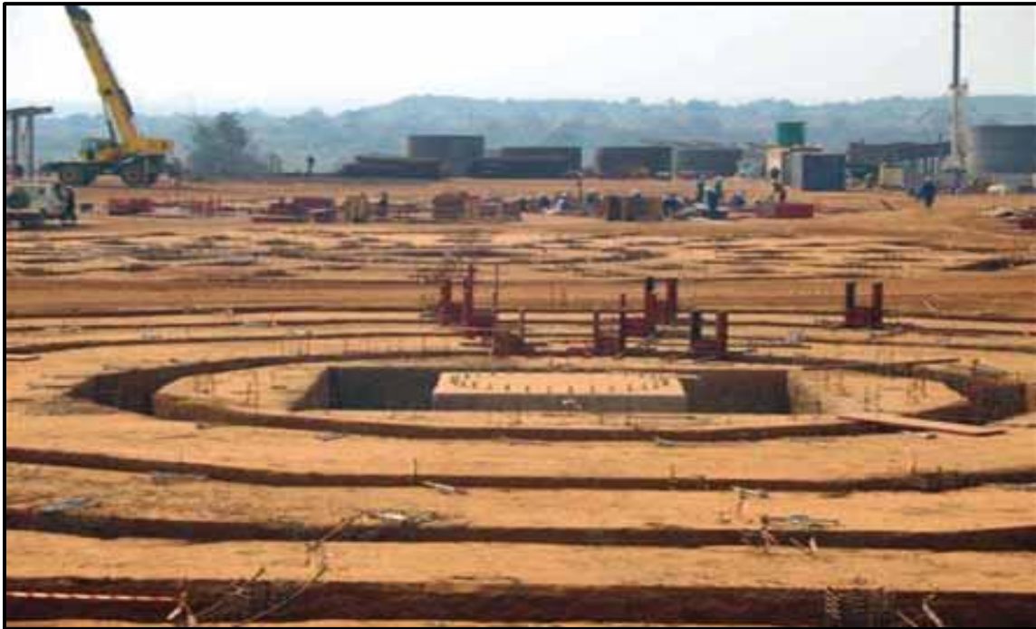
Figura 4. 18. Construcción del proyecto de recuperación de jales de cobre y cobalto, con un avance de 65%. Fuente: First Quantum Suspend Construction at Kolwezi (Metalkol RTR, 2020).
