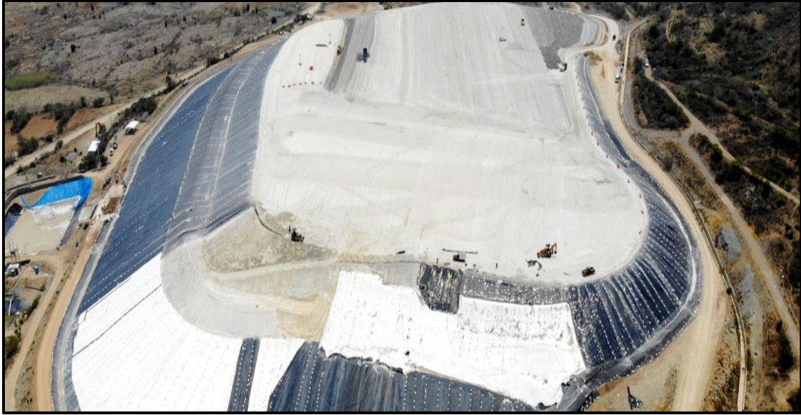
Figura 4. 31. Sistema de captación de agua de lluvia en depósito de jales de mina San José. Fuente: Unidad Minera San José opera con normalidad ante lluvias (México Minero, 2025).
