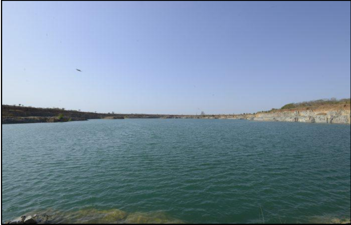
Figura 4. 33. Captación de agua de lluvia en Vikram Cement Works. Fuente: Rainwater Harvesting at UltraTech's Vikram Cement Works – Case Study (GCCA, 2021).
