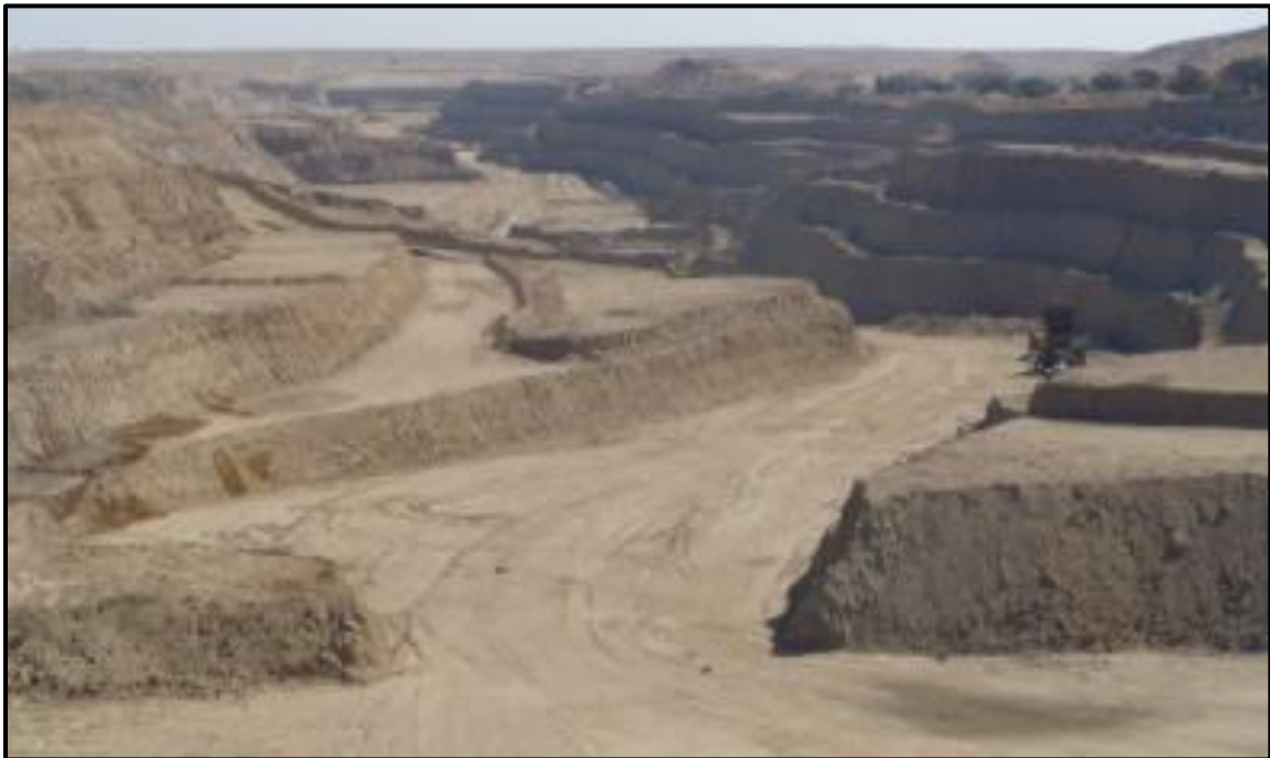
Figura 4. 7. Tajo minado y construcción parcial del paleocanal. Fuente: In-pit Tailings Disposal at Langer Heinrich – Tailings Storage Facilities in a Unique Hydrogeological Setting (Hore & Luppnow, 2015).
