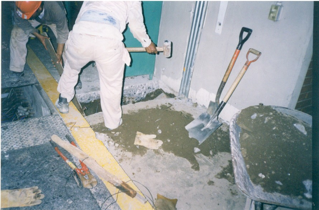
Fig. 5 Demolición de piso de concreto en caseta existente
