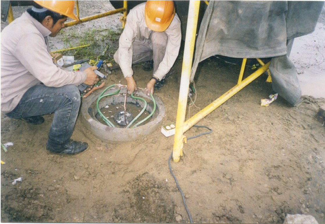
Fig. 9 Ejecución de soldadura cadweld en cables para sistema de Tierras
