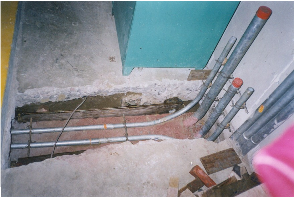
Fig. 6 Encofrado de tuberías de Fo.Ga. en canalizaciones eléctricas
