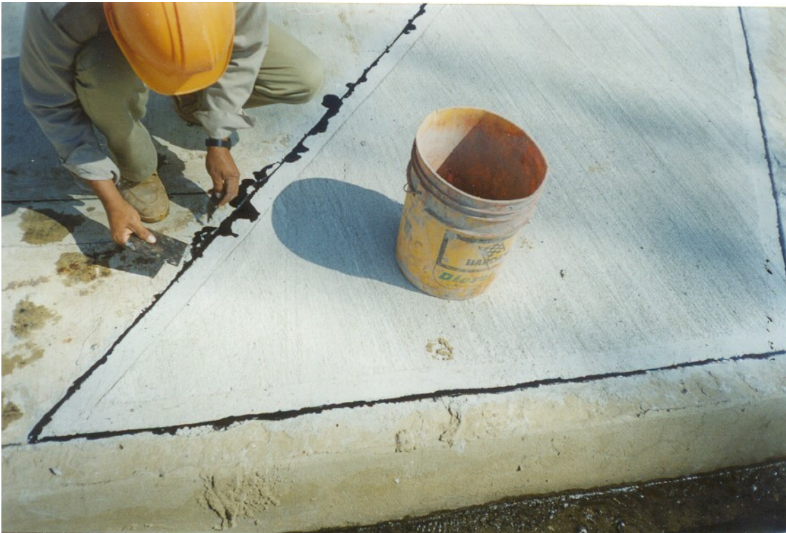
Fig. 12 Relleno de juntas con asfalto oxidado para evitar filtraciones
