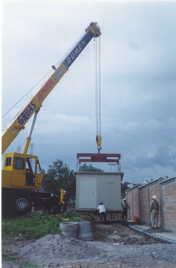
Fig. 2 Montaje de la caseta prefabricada en estación VC-010
