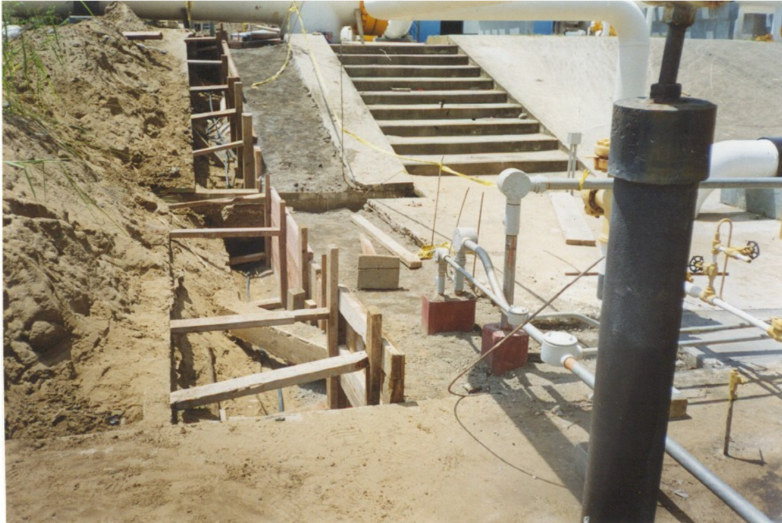
Fig. 10 Vista de cepa excavada para alojar canalizaciones eléctricas encofradas
