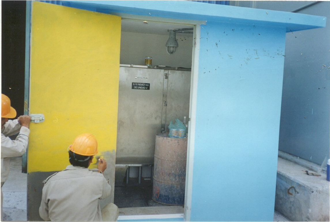
Fig. 13 Pintura en caseta existente de acuerdo a especificaciones
