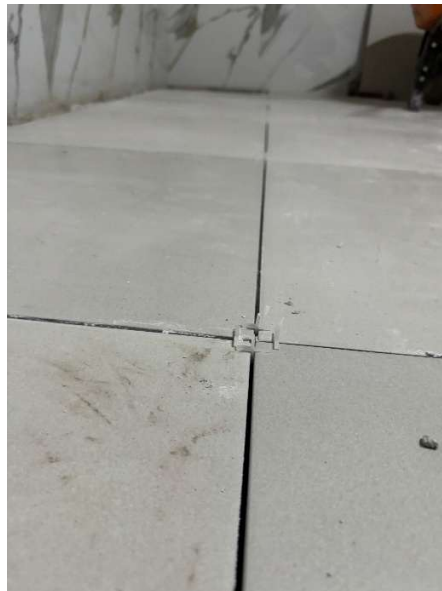
Imagen 99 Utilización de separadores para porcelanato. Elaborado por el autor.
