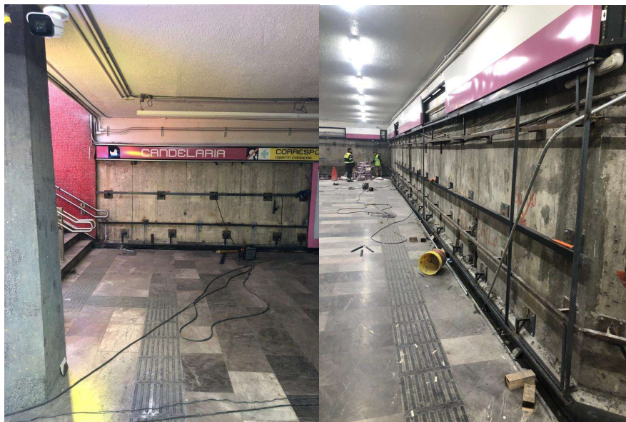
Imagen 26 Bastidor de herrería terminado. Elaborado por el autor.
