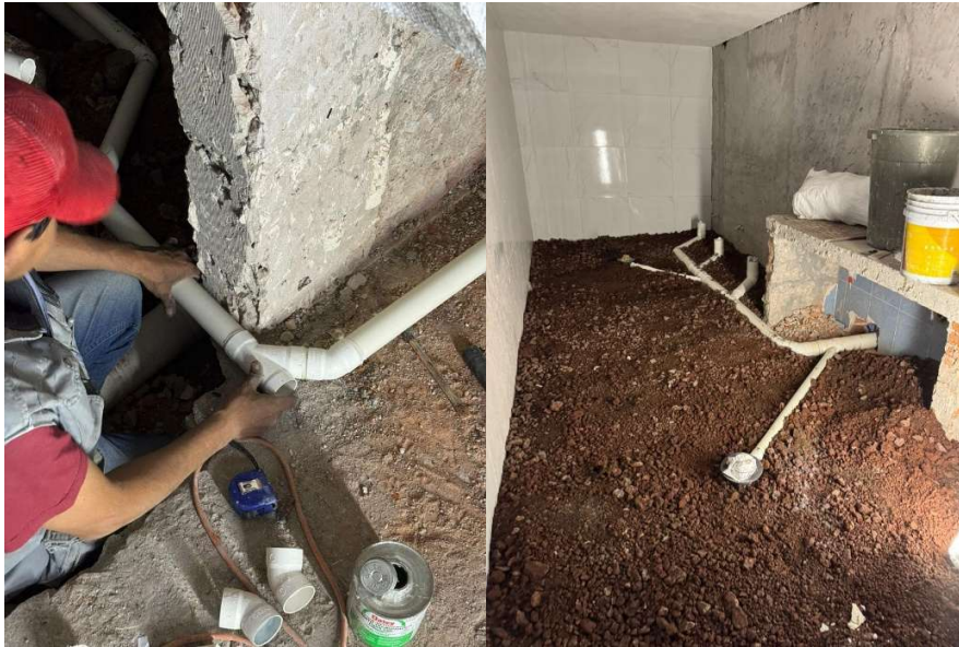
Imagen 110 Instalación de tubería sanitaria. Elaborado por el autor.
