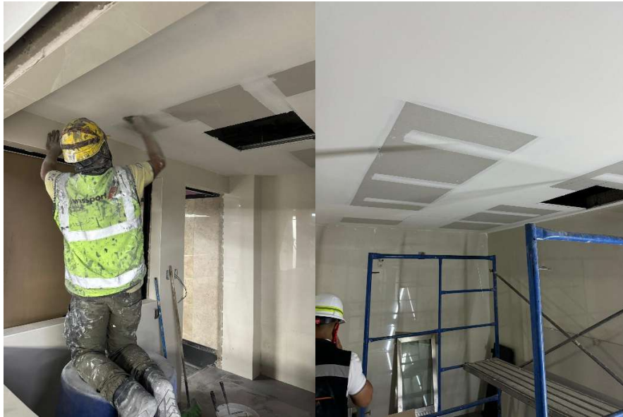
Imagen 104 Proceso de lijado de imperfecciones. Elaborado por el autor.
