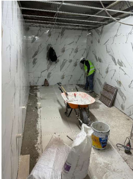
Imagen 117 Colocación de porcelanato en piso. Elaborado por el autor.
