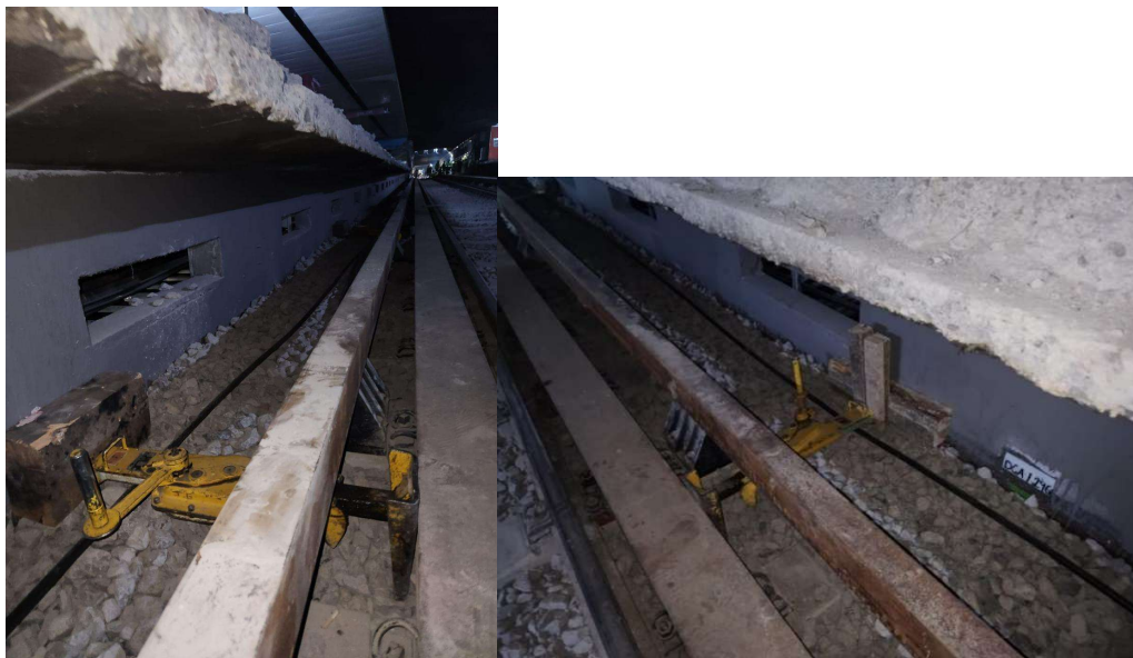
Imagen 124 Movimiento de vía por medio de gatos hidráulicos. Elaborado por el autor.
