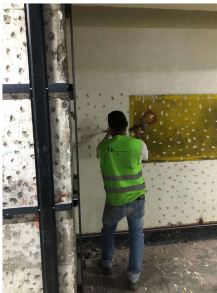
Imagen 28 Martelinado de Muro Existente. Elaborado por el autor.
