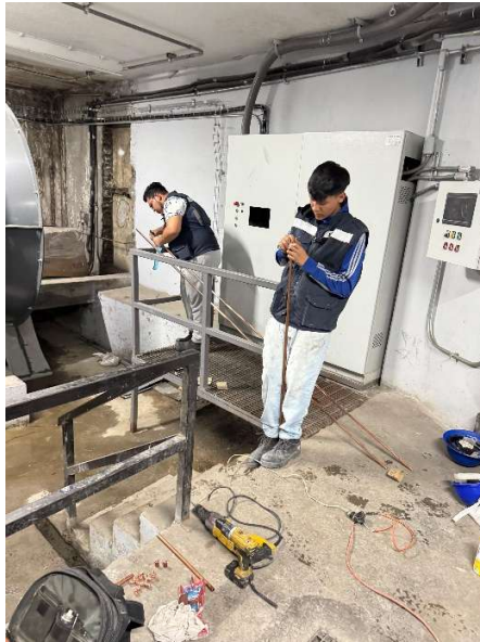
Imagen 111 Lijado de extremos de tubería de cobre. Elaborado por el autor.
