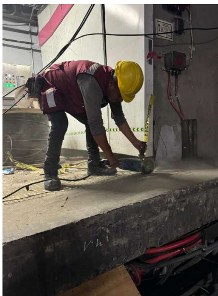
Imagen 39 Corte con disco de concreto. Elaborado por el autor.
