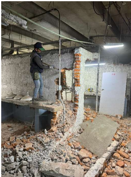
Imagen 108 Demolición de muros de ladrillo rojo. Elaborado por el autor.
