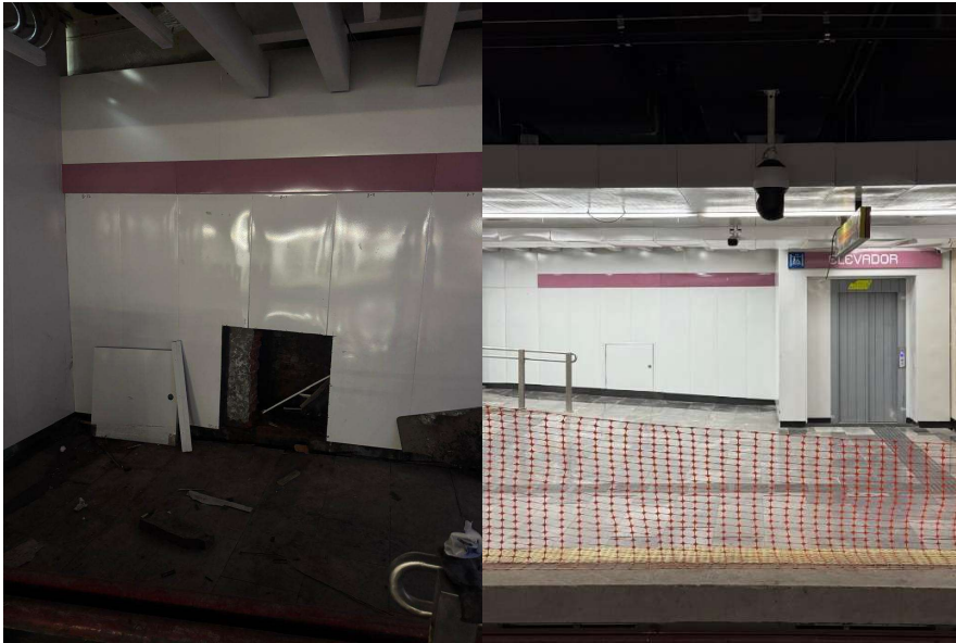
Imagen 126 Puerta del andén de la estación hacia la rejilla de ventilación. Elaborado por el autor.
