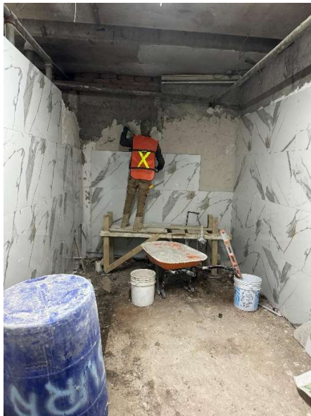
Imagen 118 Aplicación de pasta blanca en muro. Elaborado por el autor.
