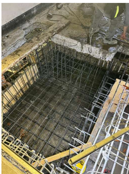
Imagen 63 Armado de refuerzo para cimentación de elevador. Elaborado por el autor.
