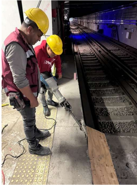
Imagen 40 Demolición de concreto por medios mecánicos. Elaborado por el autor.
