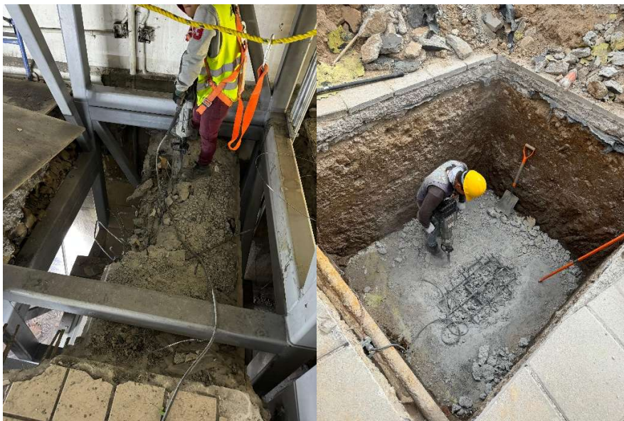
Imagen 60 Demolición de losas de concreto. Elaborado por el autor.
