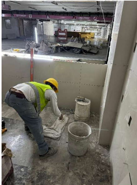
Imagen 97 Colocación de pasta blanca sobre pieza de porcelanato. Elaborado por el autor.
