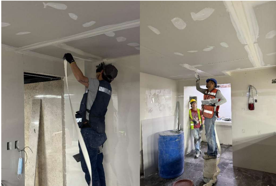
Imagen 103 Colocación de perfacinta mediante redimix. Elaborado por el autor.
