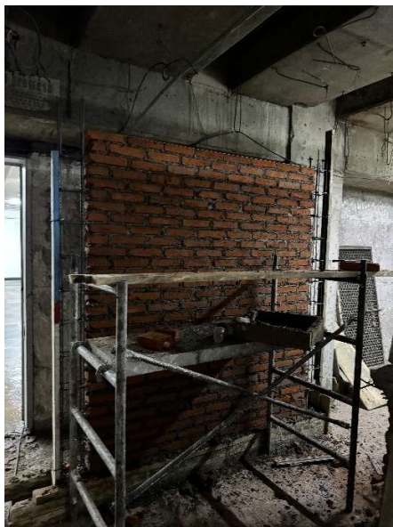
Imagen 109 Construcción de muros de ladrillo rojo recocido. Elaborado por el autor.
