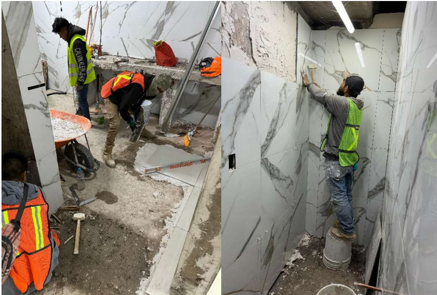
Imagen 98 Colocación de piezas de porcelanato. Elaborado por el autor.
