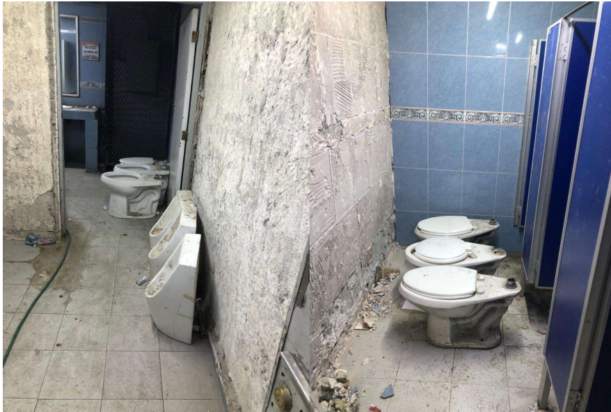
Imagen 105 Muebles sanitarios desmontados. Elaborado por el autor.
