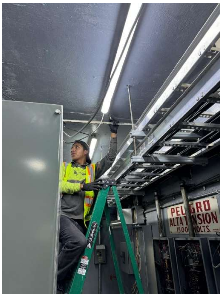
Imagen 50 Desmantelamiento de tubería de diferentes diámetros. Elaborado por el autor.
