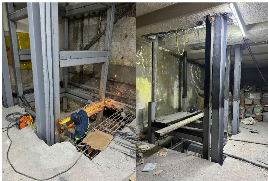
Imagen 68 Estructura Metálica del Cubo de Elevador. Elaborado por el autor.
