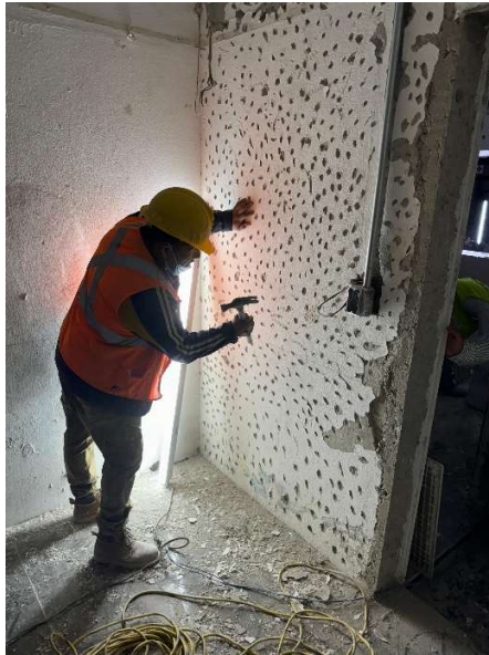
Imagen 116 Martelinado de muro existente. Elaborado por el autor.
