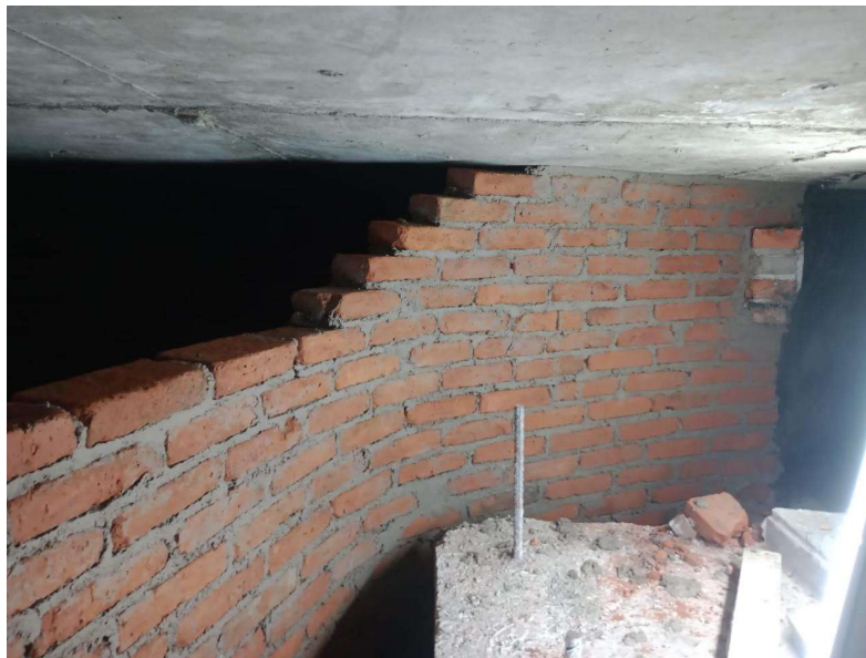
Imagen 125 Muro de ladrillo rojo recocado en el bajo andén. Elaborado por el autor.
