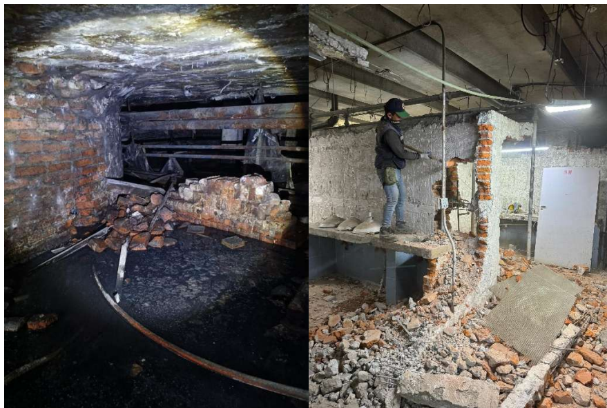
Imagen 61 Demolición de muros de ladrillo rojo recocido. Elaborado por el autor.
