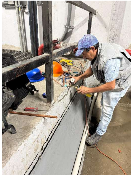
Imagen 113 Proceso de soldadura de tubería de cobre. Elaborado por el autor.
