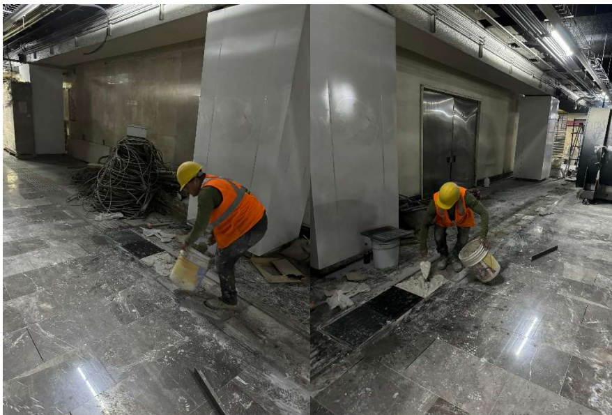
Imagen 82 Instalación de pavimento podotáctil como ruta. Elaborado por el autor.
