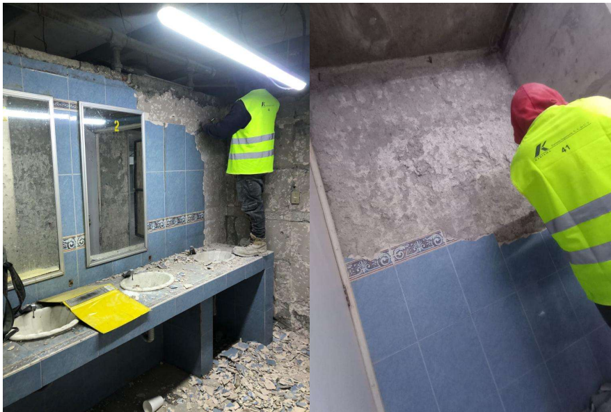
Imagen 107 Demolición de recubrimiento cerámico en baños. Elaborado por el autor.
