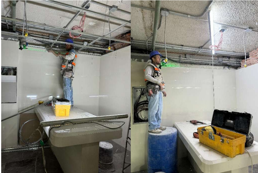
Imagen 101 Nivelación de bastidor mediante nivel láser. Elaborado por el autor.
