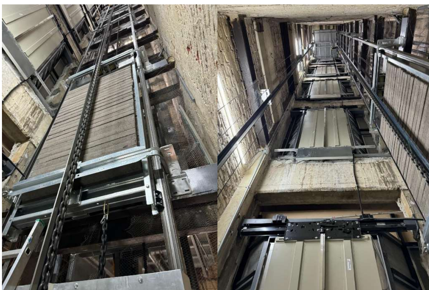
Imagen 73 Contrapeso de elevador (Arriba a la izquierda). Elaborado por el autor.
