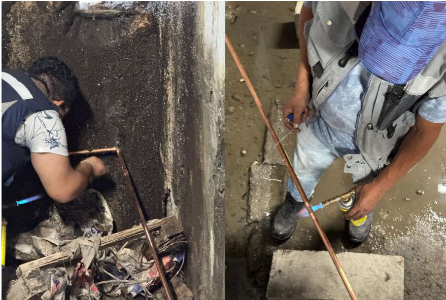
Imagen 112 Aplicación de soldadura y pasta para soldar tubería de cobre. Elaborado por el autor.
