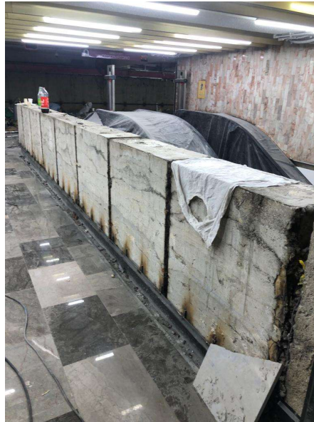
Imagen 29 Colocación de ángulo de herrería. Elaborado por el autor.
