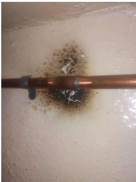
Imagen 115 Anillo de soldadura en unión de dos tramos de tubería. Elaborado por el autor.
