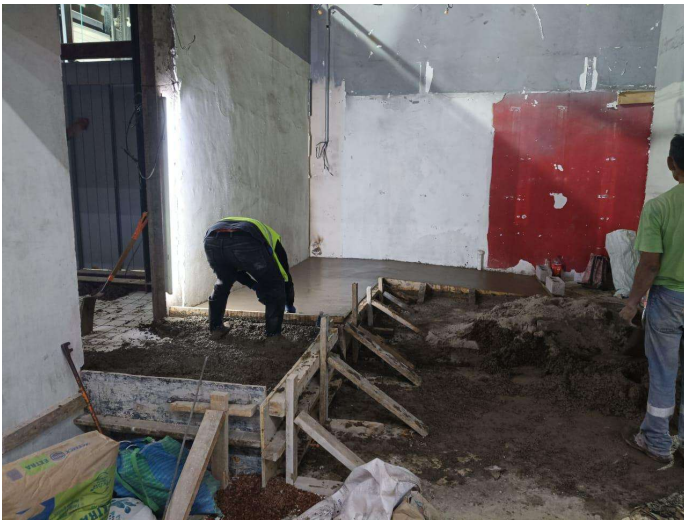
Imagen 87 Colado de firme de concreto.
