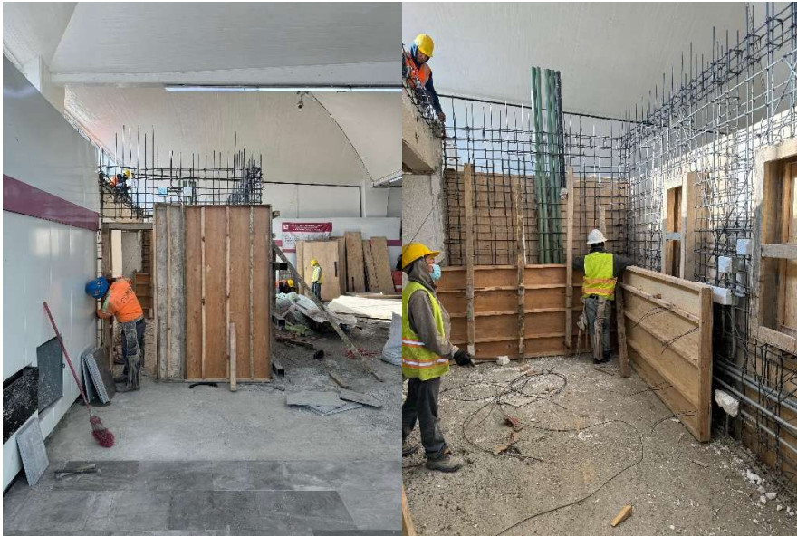
Imagen 95 Proceso de cimbrado de muro. Elaborado por el autor.
