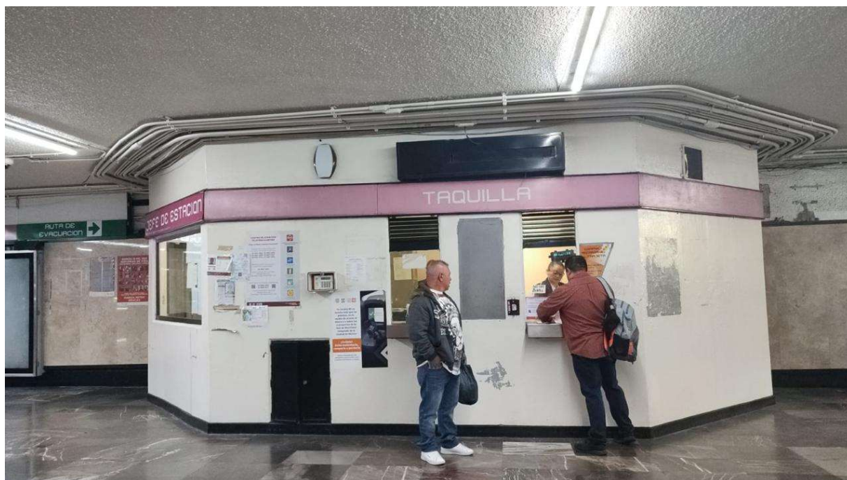
Imagen 21 Fachada Taquilla Balderas Línea 1 previo a su intervención. Elaborado por el autor.
