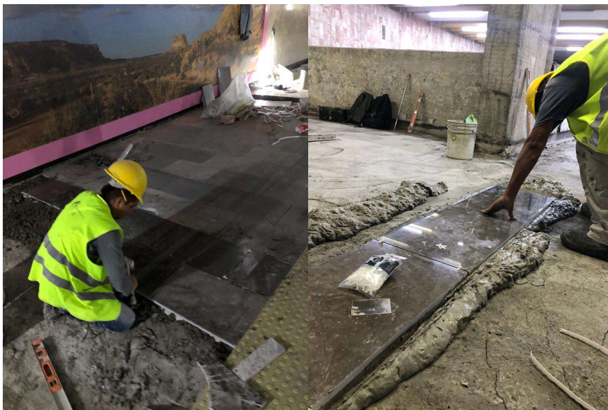
Imagen 37 Colocación de mármol gris santo tomás en andén. Elaborado por el autor.
