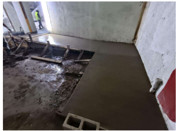
Imagen 87 Colado de firme de concreto.
