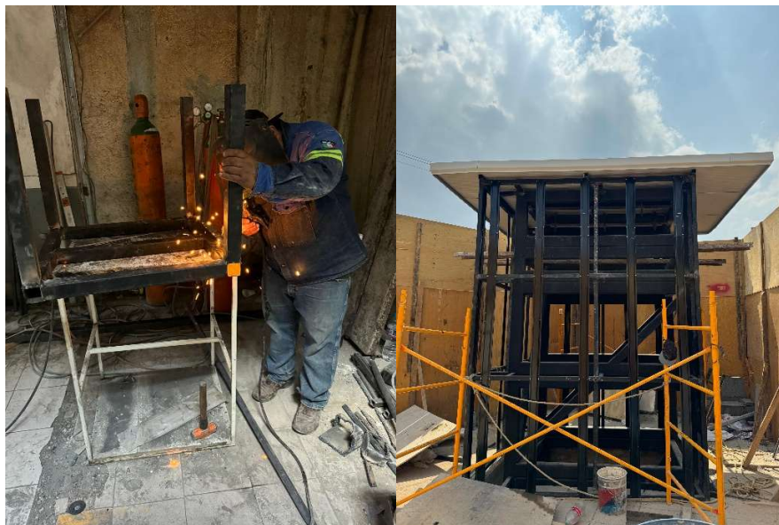
Imagen 70 Estructura Metálica del Cubo de Elevador. Elaborado por el autor.
