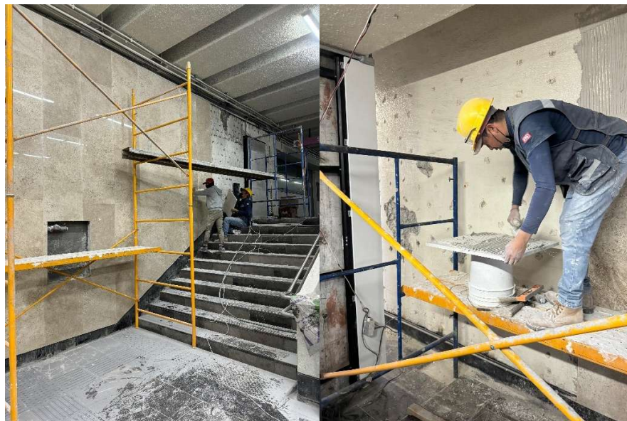
Imagen 30 Proceso de colocación de mármol travertino pegado. Elaborado por el autor.
