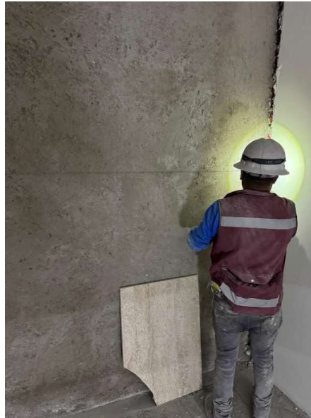
Imagen 85 Marcaje de Referencia sobre muro. Elaborado por el autor.
