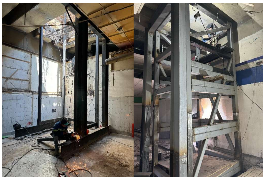
Imagen 69 Estructura Metálica del Cubo de Elevador. Elaborado por el autor.
